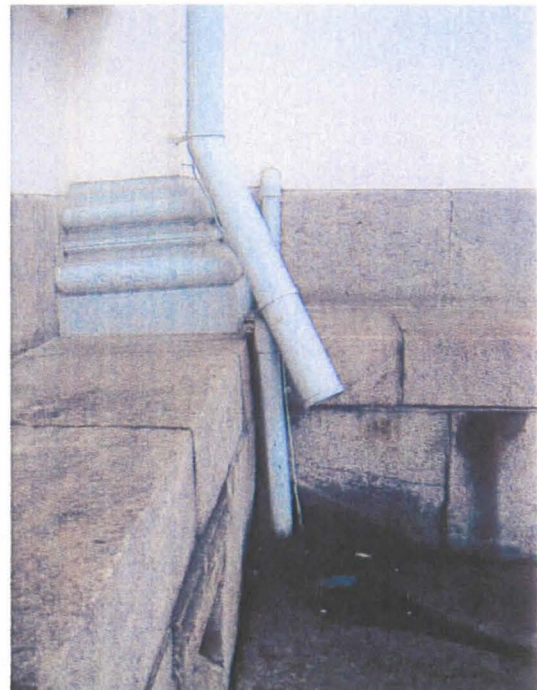
Kuva 3: Koristeiden ja listojen pellityksiä oli riittävästi. Sen sijaan pienten yksityiskohtien kosteustekniseen toimivuuteen on syytä kiinnittää huomiota. Oikeanpuoleisessa kuvassa syöksytornin kiinnitys on kallistunut seinään päin ja ohjaa siten veden seinään. Sen lisäksi torvi roiskii veden pitkin sokkeliä, joka voi aiheuttaa ongelmia sisätiloissa, lähinnä kryptassa.
