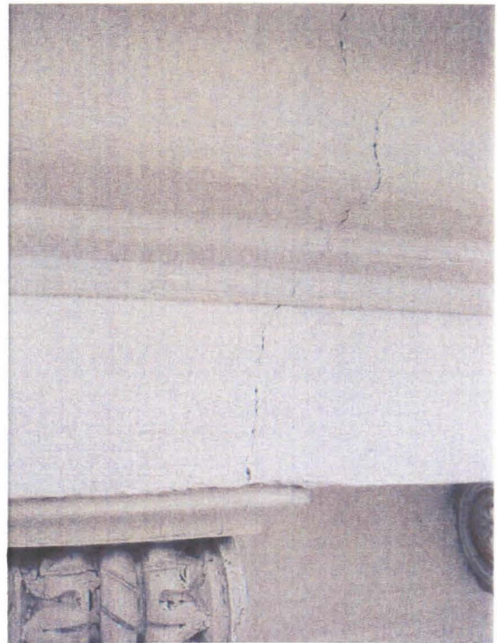
Kuva 2: Halkeamat altistavat seinärakenteen suuremmalle kosteusrasitukselle kuin normaalisti. Rästäslinjoissa oli suhteessa muihin rakenteisiin paljon halkeamia.
