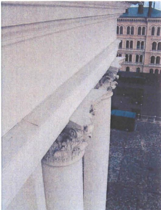
Kuva 3: Koristeiden ja listojen pellityksiä oli riittävästi. Sen sijaan pienten yksityiskohtien kosteustekniseen toimivuuteen on syytä kiinnittää huomiota. Oikeanpuoleisessa kuvassa syöksytornin kiinnitys on kallistunut seinään päin ja ohjaa siten veden seinään. Sen lisäksi torvi roiskii veden pitkin sokkeliä, joka voi aiheuttaa ongelmia sisätiloissa, lähinnä kryptassa.
