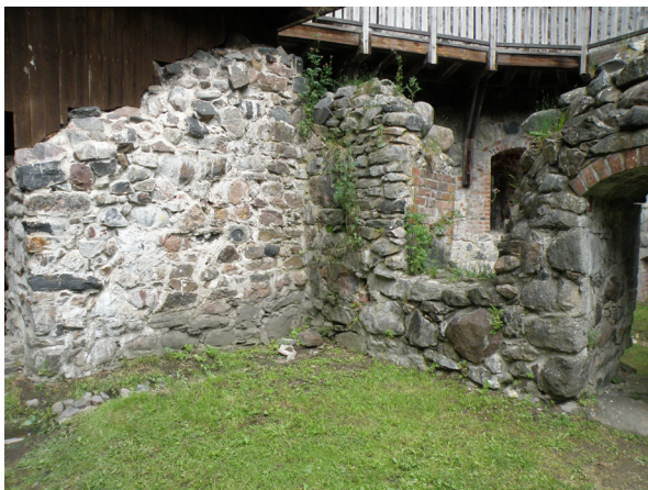
59. Koekuopan 5 paikka. Vasemmalla pohjoistorni, oikealla itäsiivessä oleva keittiö. SW-NE. GH.
