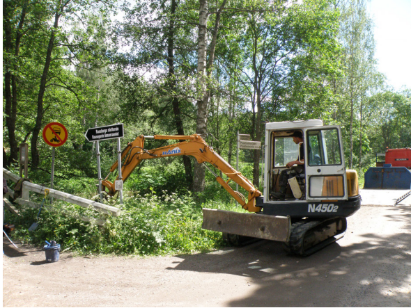
1. Linnansalmen/Fiskarbron sillan länsipään eteläpuolelle tehdyn koekuopan paikka. Vasemmalla sillan länsipääty. Kuopan kaivaminen aloitetaan poistamalla vanha opasviitta. NW-SE. GH.
