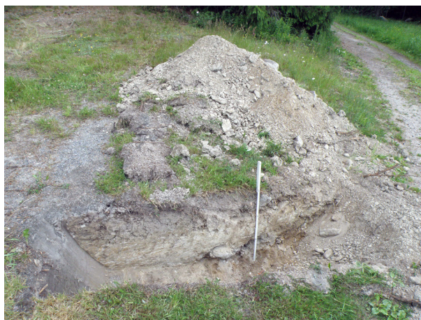
Kuva 9. Koekuoppa 6 konekaivuun jälkeen. Linnan pohjoispuolella olleissa koekuopissa ei näkynyt merkkejä keskiaikaisesta toiminnasta. Kuva GH.
