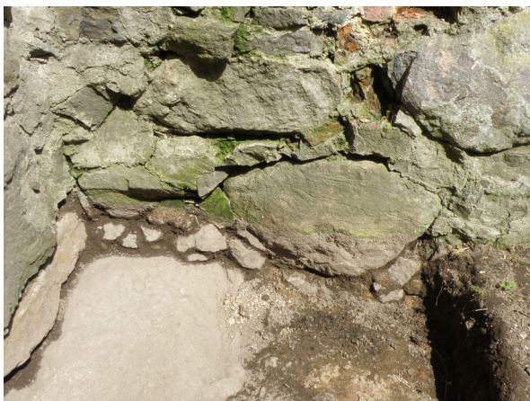
78. Koekuoppa 5. Taso 1. Itäsiiven keittiön ulkoseinä ja sen liitos kallioon. Detalji. W-E. GH.
