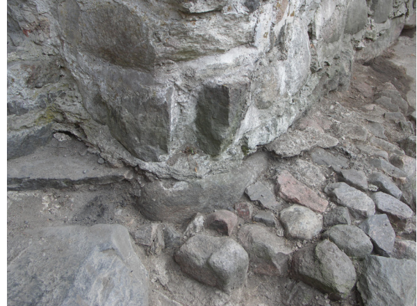
102. Taso 1. Linnan Pohjoistornin oviaukon kulma ja sen liitos pihakiveykseen. SWW-NEE. GH.
