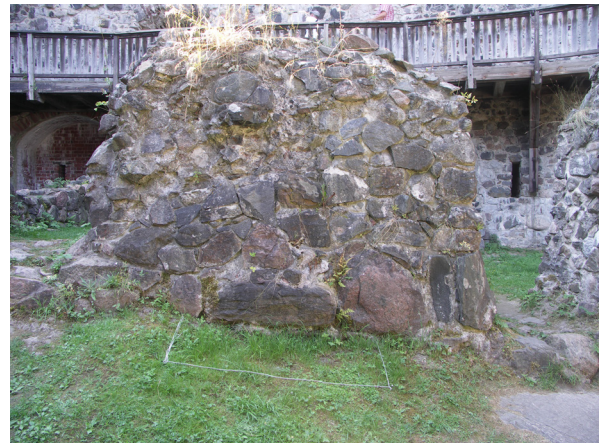
104. Koekuopan 9 paikka ennen kaivausta. E-W. GH.
