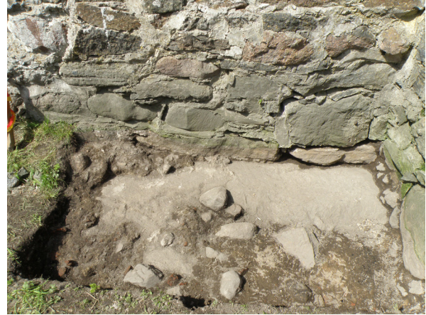
75. Koekuoppa 5. Taso 1. Pohjoistornin ulkoseinä ja sen liitos kalliioon. S-N. GH.
