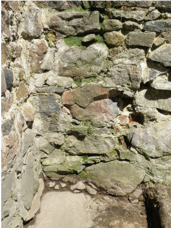
77. Koekuoppa 5. Taso 1. Itäsiiven keittiön ulkoseinä ja sen liitos kallioon. W-E. GH.
