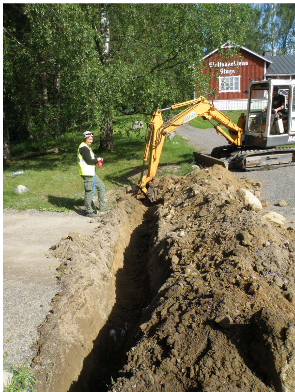
Kuva 6. Koeojaa 1 avataan kaivinkoneella. Kuva GH.
