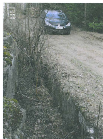
Entinen ratalinja on louhittu kallioon ja ratapohjan reunat on kivetty.
