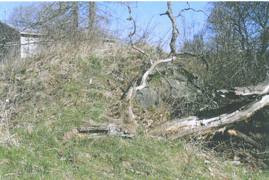
Siggans, rakenteet C. Maakellari kuvattuna kaakosta.
