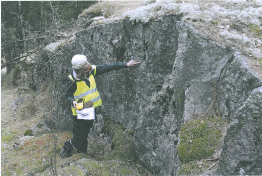
Harjulinnan louhosalueen itäosien louhittua kallioseinämää.
