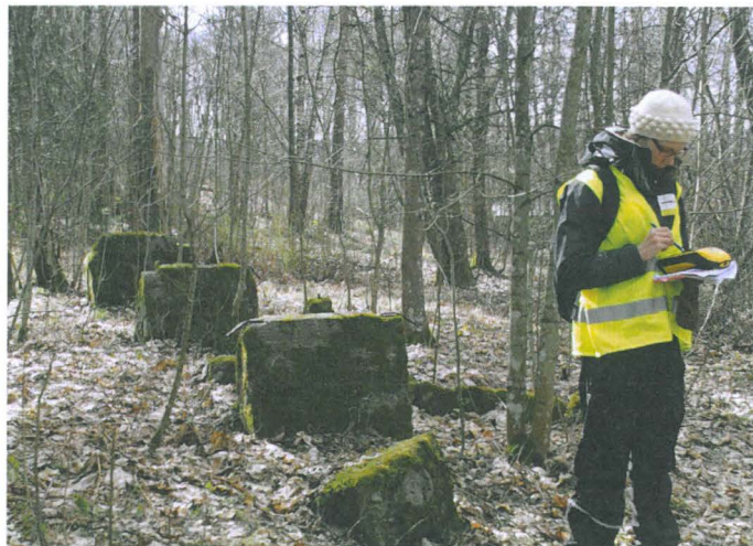
Betonipilarit ovat luultavasti kuuluneet liiteriin. Kuvattu pohjoisesta.
