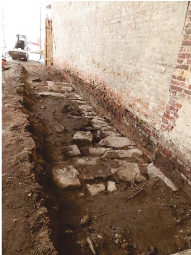
DT2014:72:16. Rakenne R003 kaivannossa 1. Kuvattu itäkoillisesta. JP 12.3.2014.
