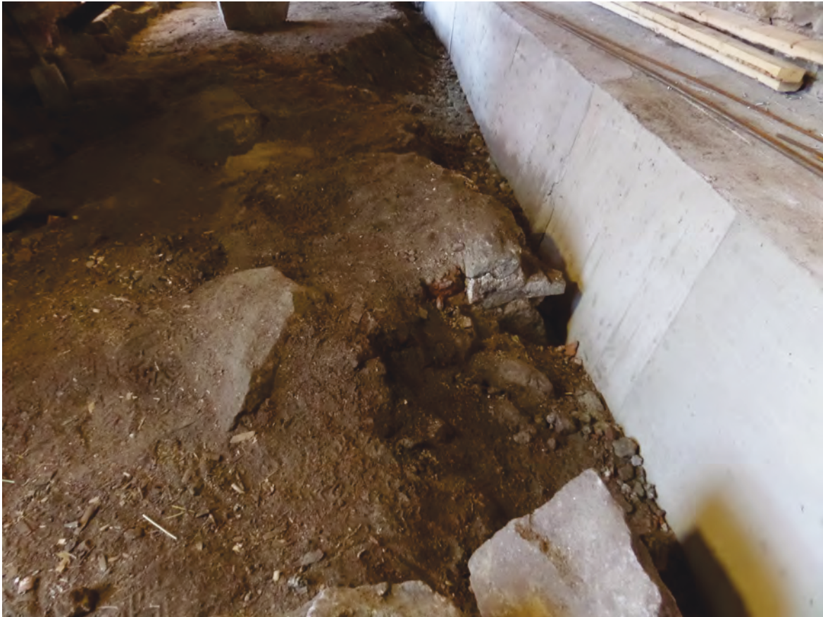
DT2014:72: 118R017 rakennuksen 2 huoneessa B. Kuvattu lounaasta. JP 10.4.2014.
