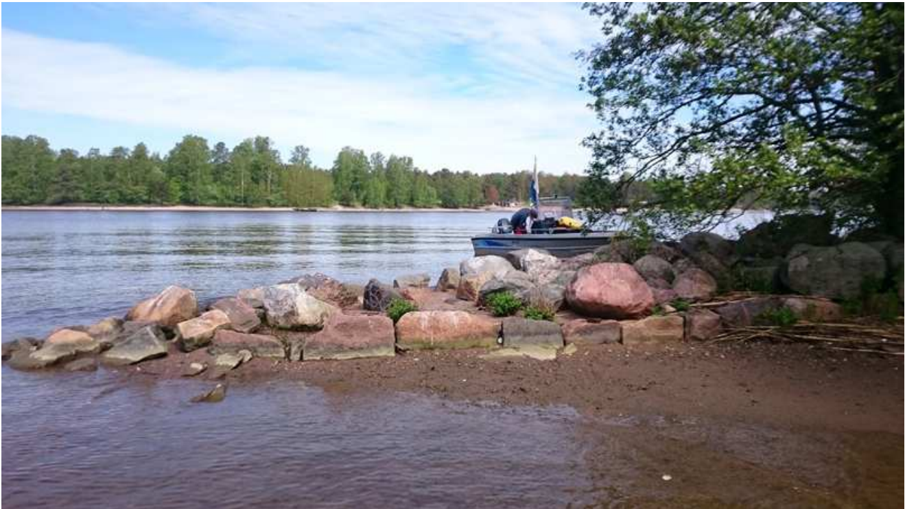
Kuva 8. Kuva laiturille johtaneen tienpohjan ja laiturin perustuksista Palosaaren rannassa. Kuvattu kohti Mustikkamaata, koilliseen.
