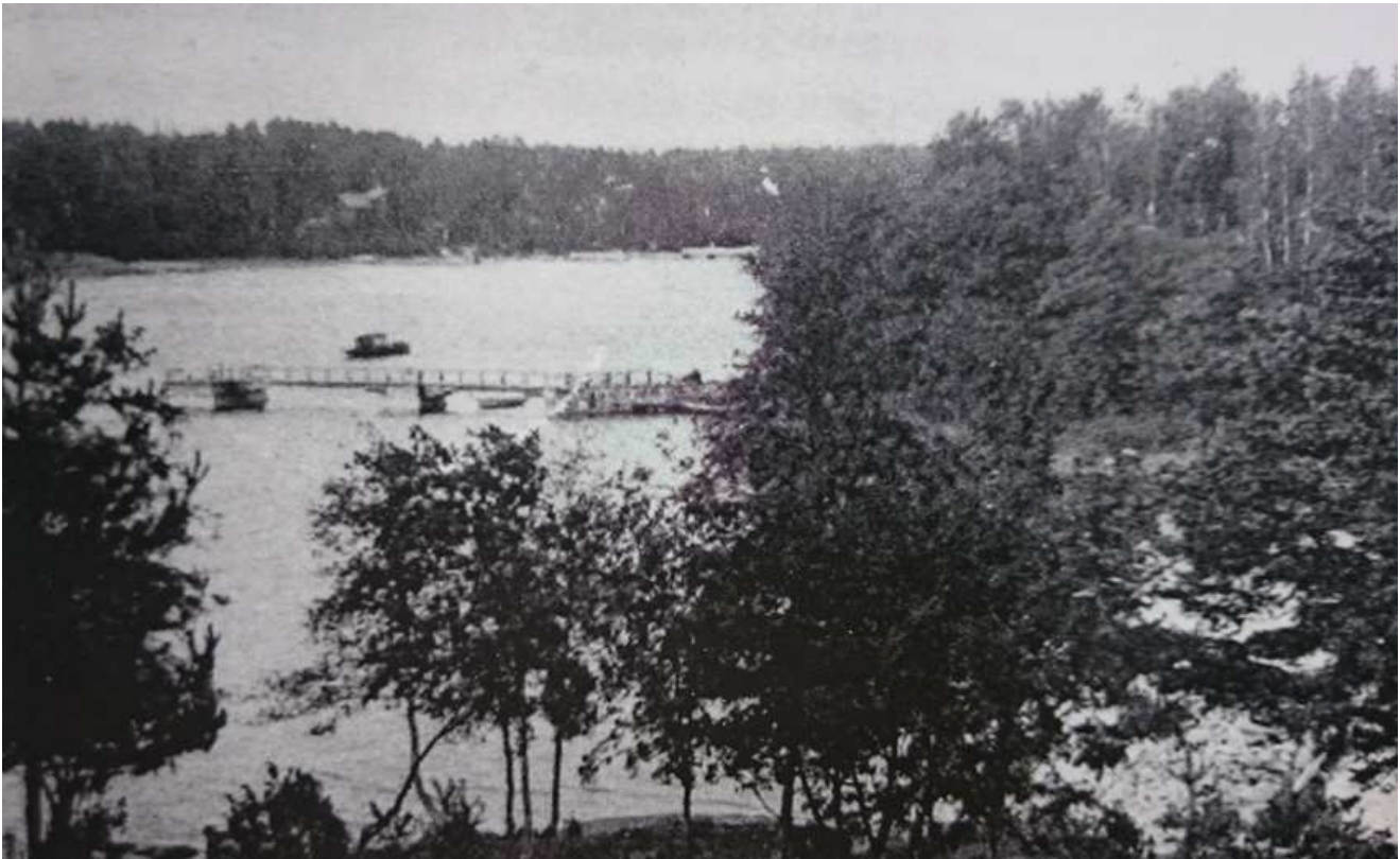
Kuva 3. Ote kuvasta, jossa näkyy Palosaaren laivalaituri vuonna 1904. Kuvassa näkyy hyvin laiturin kaksi erillistä arkkuperustusta. Kuvattu Korkeasaaresta. Lähde: Museoviraston kuva-arkisto.
