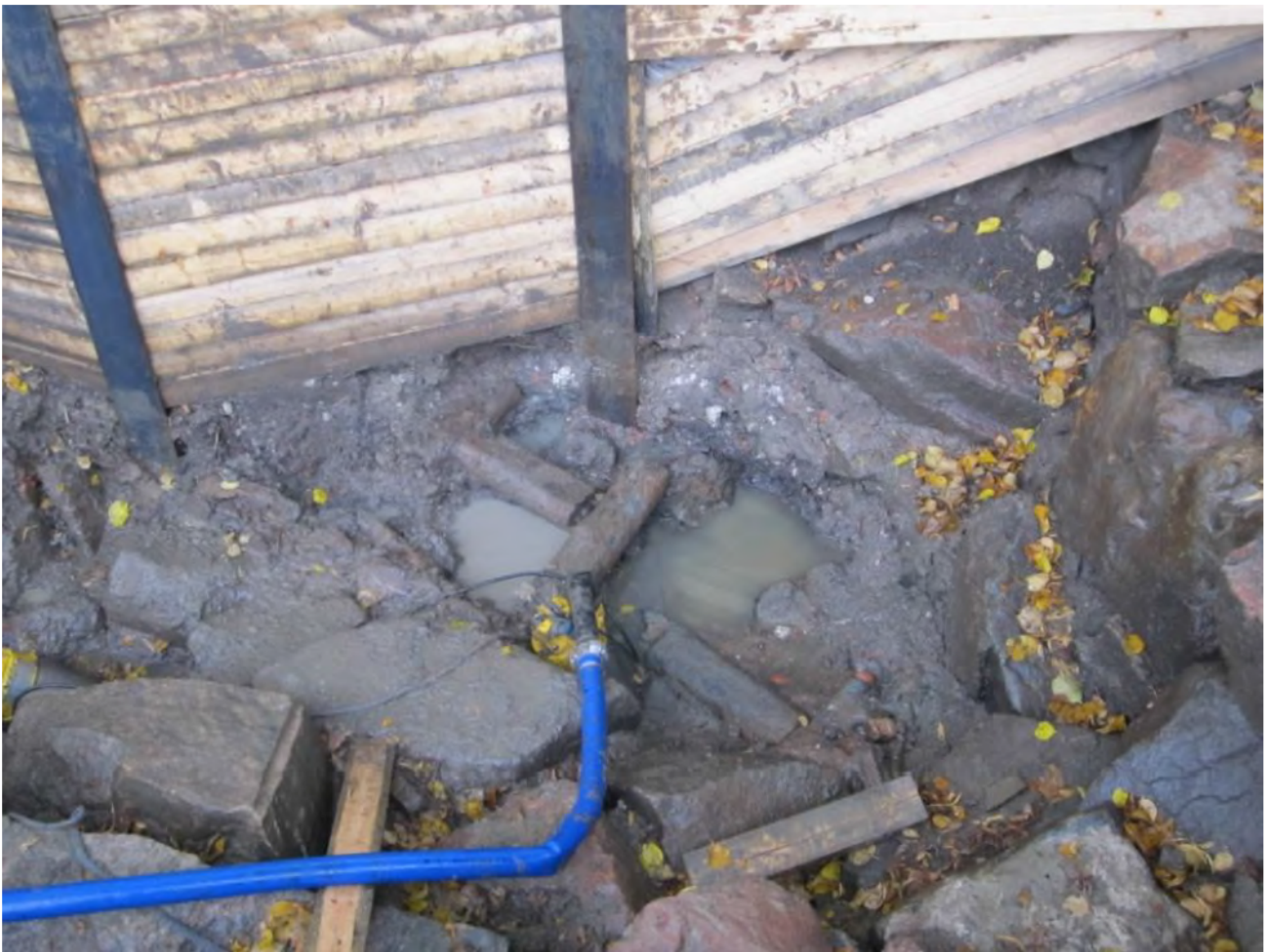
Kuva 29. DT2013_15_308: Salvosrakenne R155 in situ pohjoisluoteesta kuvattuna . Kuvaaja Virva Lompolo
