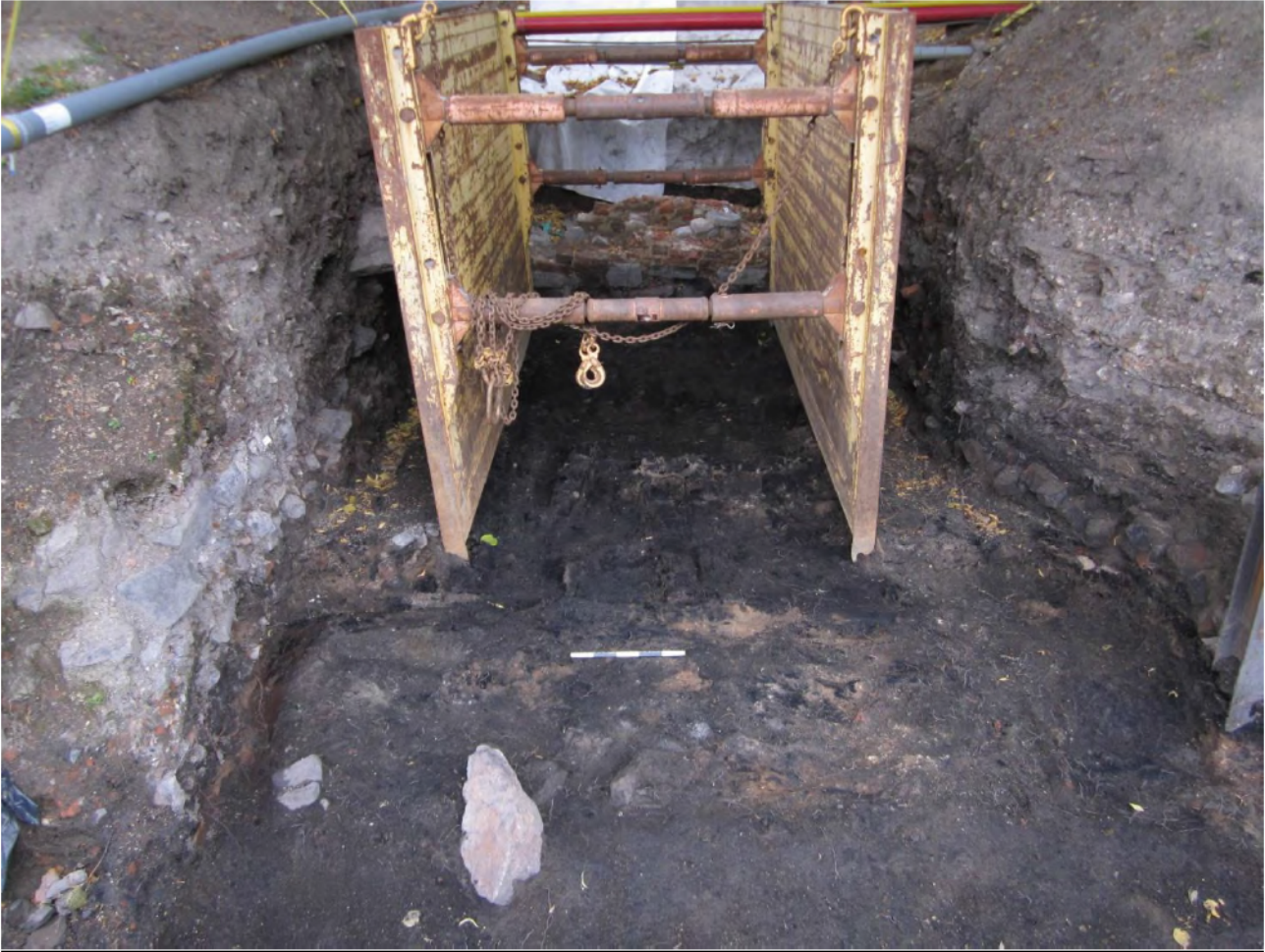
Kuva 26. DT2013_15_280: Palanut puutason fragmentti R142. taustalla näkyy kellarin seinämuraus R095. Kuvattu luoteesta. Kuvaaja Elina Saloranta.
