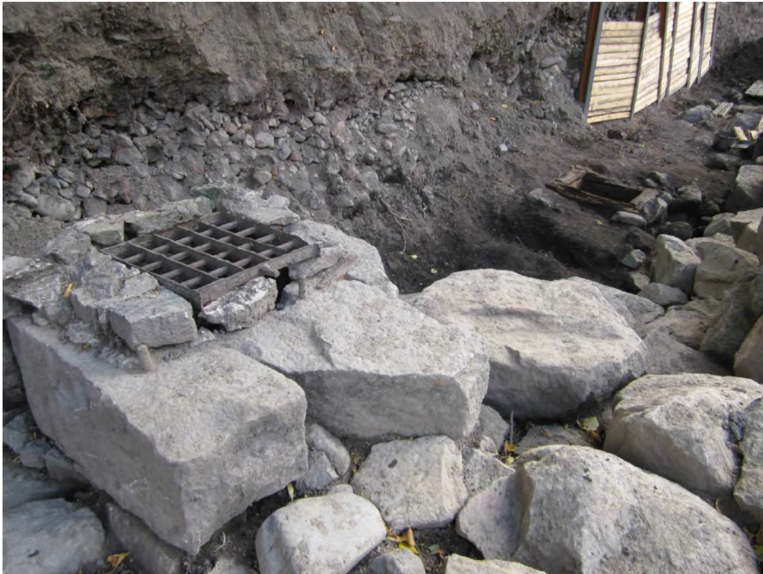
Kuva 6. DT2013_15_279: Sadevesikaivot R109 etualalla ja vanhempi R129 taustalla. Kuvattu pohjoisesta. Kuvaaja Elina Saloranta.
