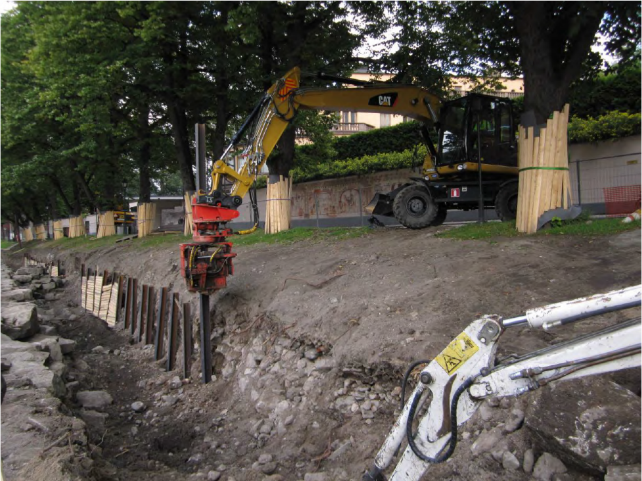
Kuva 2: Rautaista H-palkkia painetaan täryyttävällä kaivinkoneella maahan. Taustalla näkyy rakennettua settiseinää. Kuvattu länsiloumaasta. Kuvaaja Elina Saloranta.
