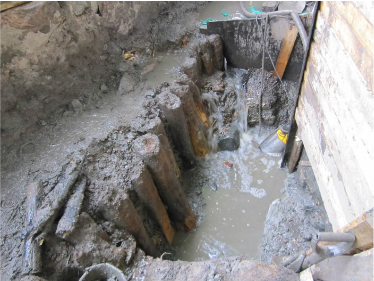
Kuva 3. DT2013_15_181: 0-tason alapuolelle tehty kaivanto H, johon jokivesi pulppuaa. Kaivannon reunassa näkyy vanha paalutus. Oikealla on rannanpuoleisen profiilin peittävä settiseinä, vasemmalla näkyy nykyisen laiturin taustakiveystä. Kuvattu etelälounaasta. Kuvaaja Virva Lompolo.
