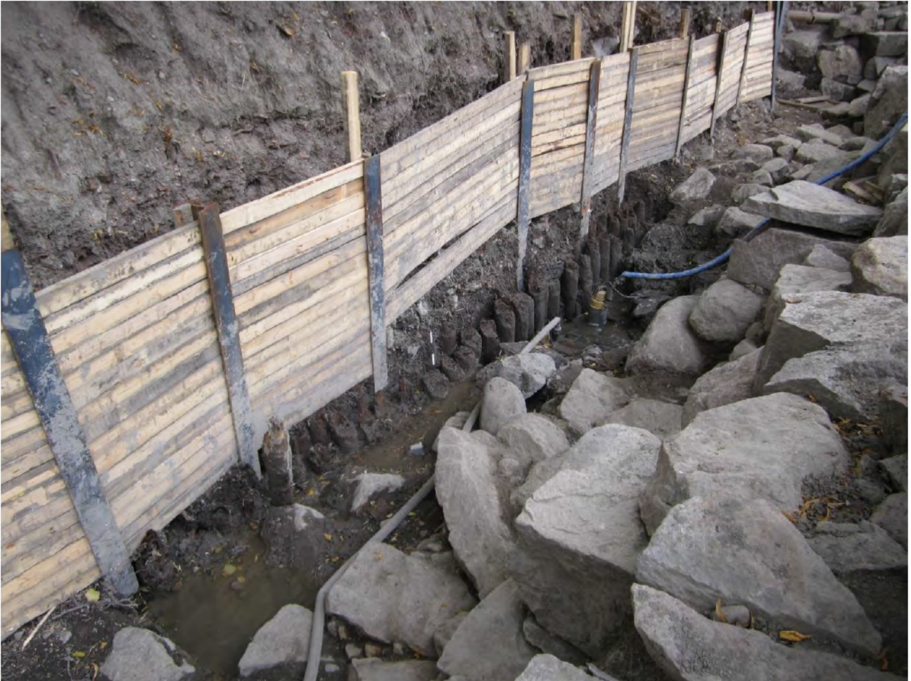
Kuva 38. DT2013_15_270: Paalutusta R137 alueen III kaakkoisreunassa. Oikealla näkyy nykyinen laiturijäsen alaosassa vanhemmaksi tulkittu laiturikiveys R136. Kuvattu pohjoisesta. Kuvaaja Elina Saloranta.
