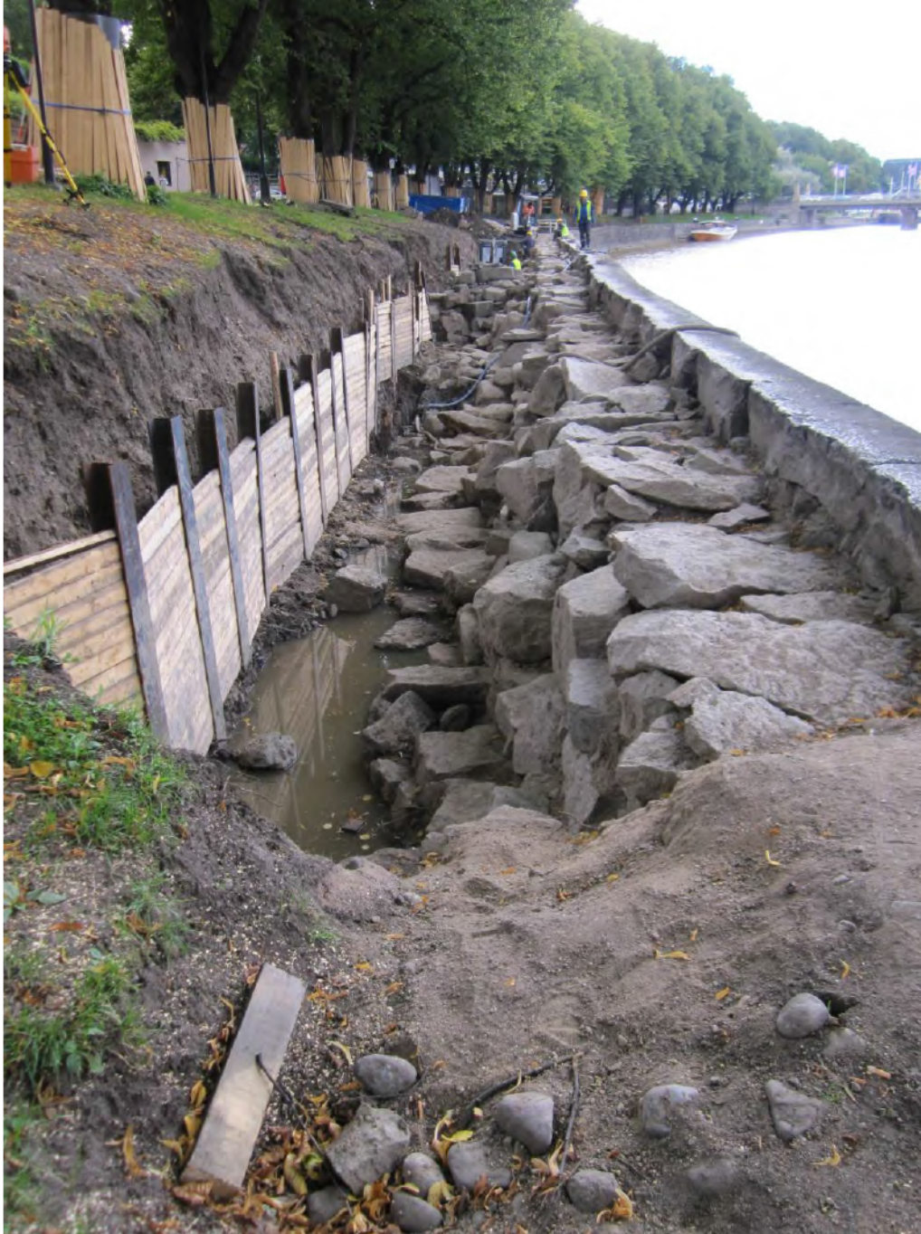
Kuva 8. DT2013_15_269: Laiturin perustuskivet pillkistävät taustakivien alta. Kuvattu koillisesta. Kuvaaja Elina Saloranta.
