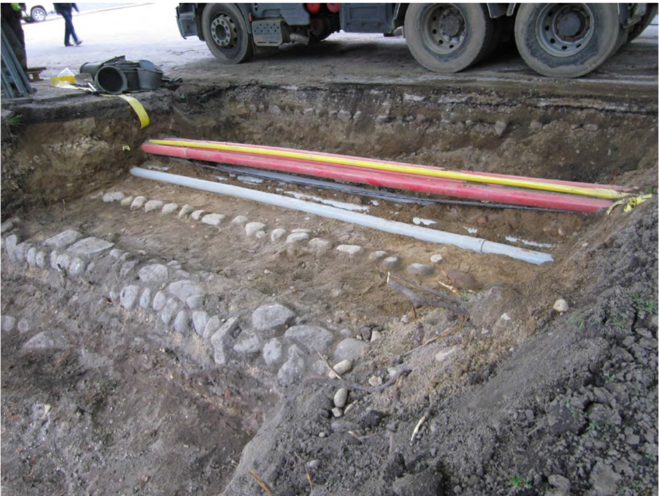
Kuva 5. DT2013_15_034: 1800-luvun katukiveyksen fragmentti R015 kaapelikaivannon L030 leikkaamana alueen II kaakkoisreunassa. Profiilin yläosassa, asfaltin alla näkyy 1900-luvun katukiveys. Vasemmassa reunassa pilkottaa vuoden 1827 paloa edeltävä kiveys. Kuvattu lännestä. Kuvaaja Elina Saloranta.
