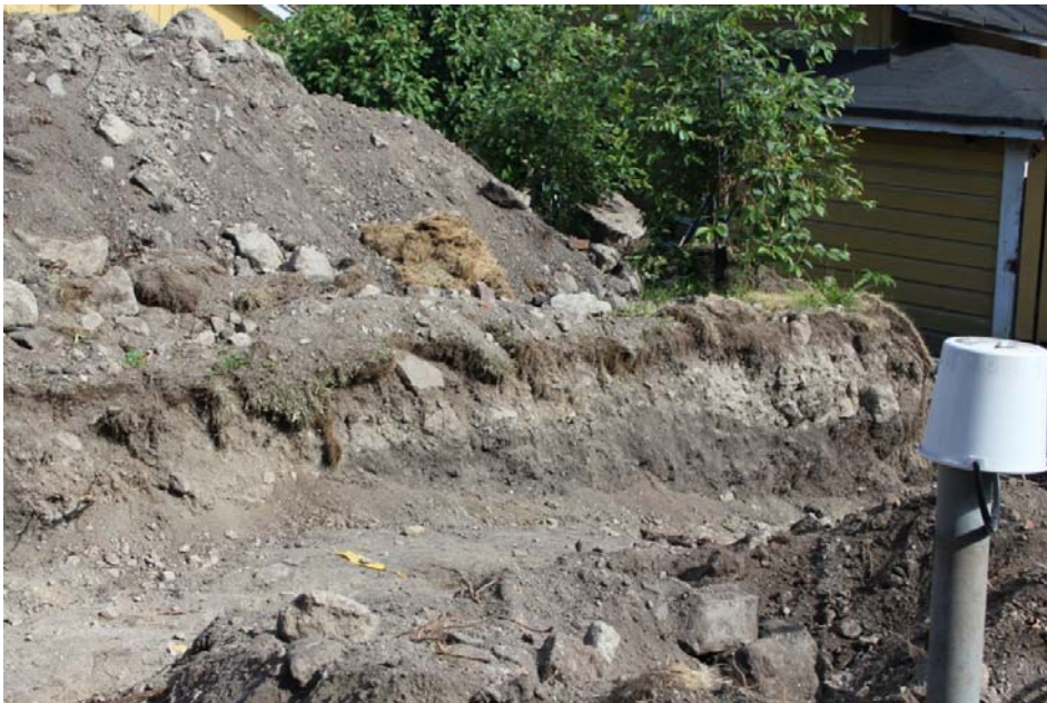
Kuva 7. Kaivannon luoteisprofiilin täyttökerrokset (DT2014:119:5).
