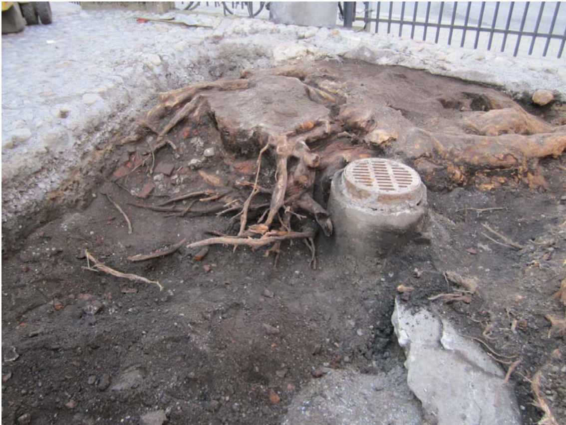
Kuva 2. Kaivanto kuvattuna NE-suunnasta ennen kannon jyrkimisen aloittamista. Jalavan juurien joukossa näkyy tiilen- ja laastinpaloja, jotka viittaavat siihen, että kannon alla saattaa olla säilyneitä kulttuurikerroksia. Etuoikealla näkyy kaivantoon jäävä betonilaatta. Kuvaaja: Sonja Hukantaival (DT2015:32:4).
