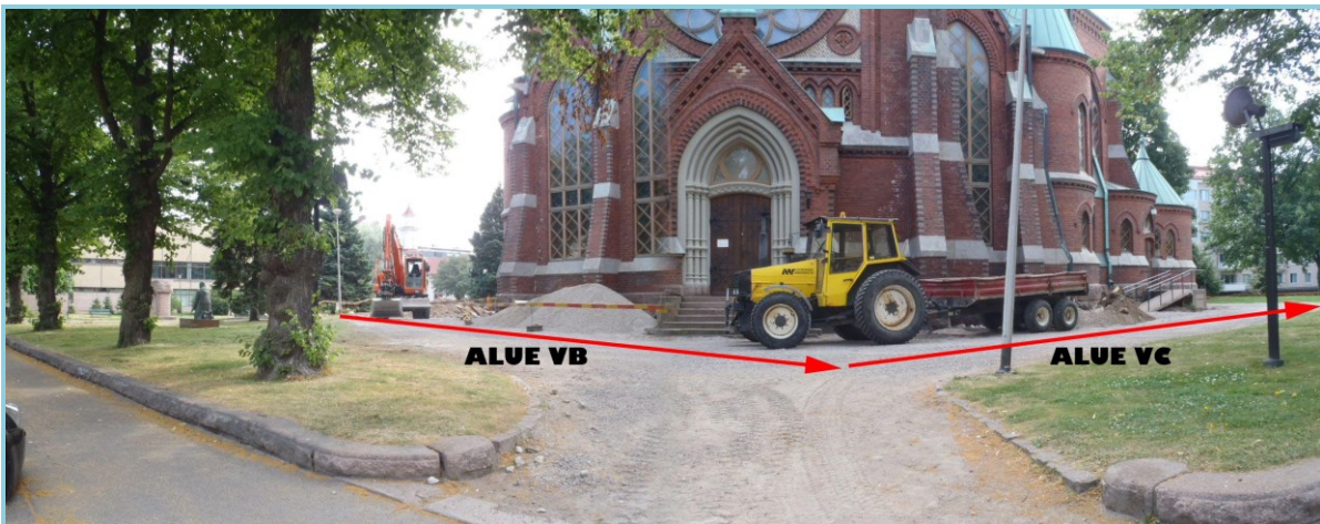
Kuva 8: Alue VB oli liitosa VA:n läntinen jatke, jonka alueelta paljastui kahden kiveyksen (R1-R2) jäännökset. Sen jatkeeksi kaivetulta alueelta VC löytyi tiili- ja kivirakenteita (R3-R11), jotka olivat peräisin Ruotsinsalmen aikaisen insinöörikomennuskunnan talosta. SW. Kuva: KyM/M. Kykyri.
