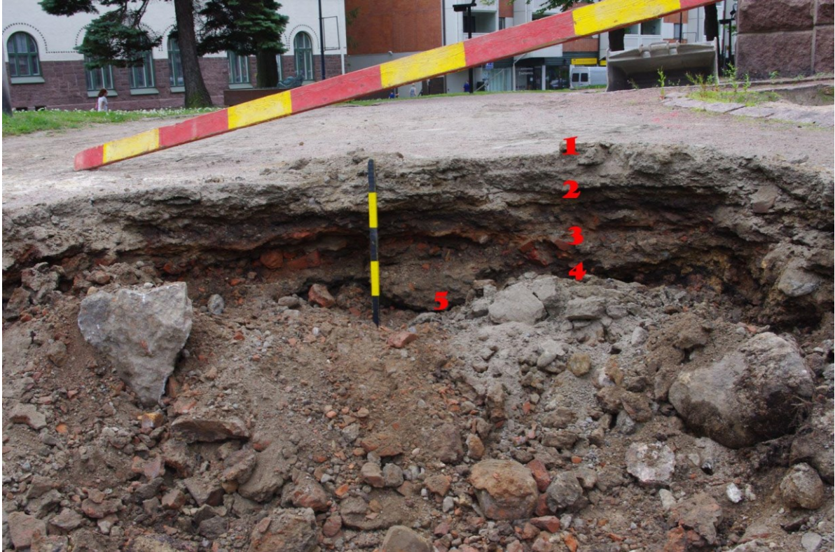
Kuva 64: Puistokäytävän poikittaisleikkaus maapilari MP8:n W-puolella, missä kerrokset olivat samat kuin kaivannon E-seinämästä dokumentoidussa maapilarissakin N. Kuva: KyM/M. Kykyri.
