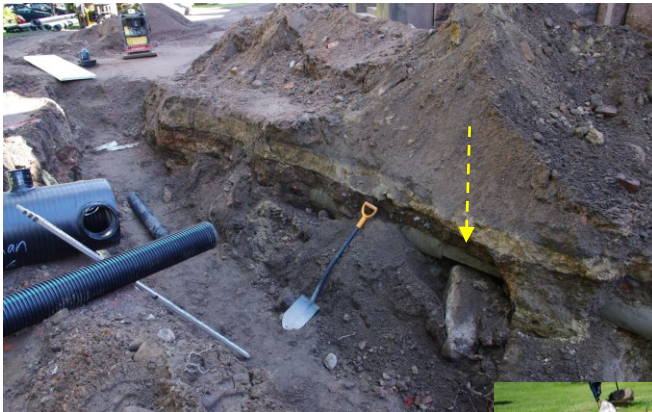
Kuva 27 (vas.): Alueen E-seinämän kerroksia viemärikaivannon N-päässä. Alueelle kaivettu kirkon sähkön pääsyöttökaapeli (keltainen nuoli) oli kaivettu alueen halki ja tuettu alapuolelta isoilla kivillä. Betonisen kaapelin suojakourun alapuolella sijaitsee tiilen-, kiven- ja laastinsekainen purkujätekerros ja sen yläpuolella resenttejä täyttökerroksia. SW. Kuva: KyM/M. Kykyri.
