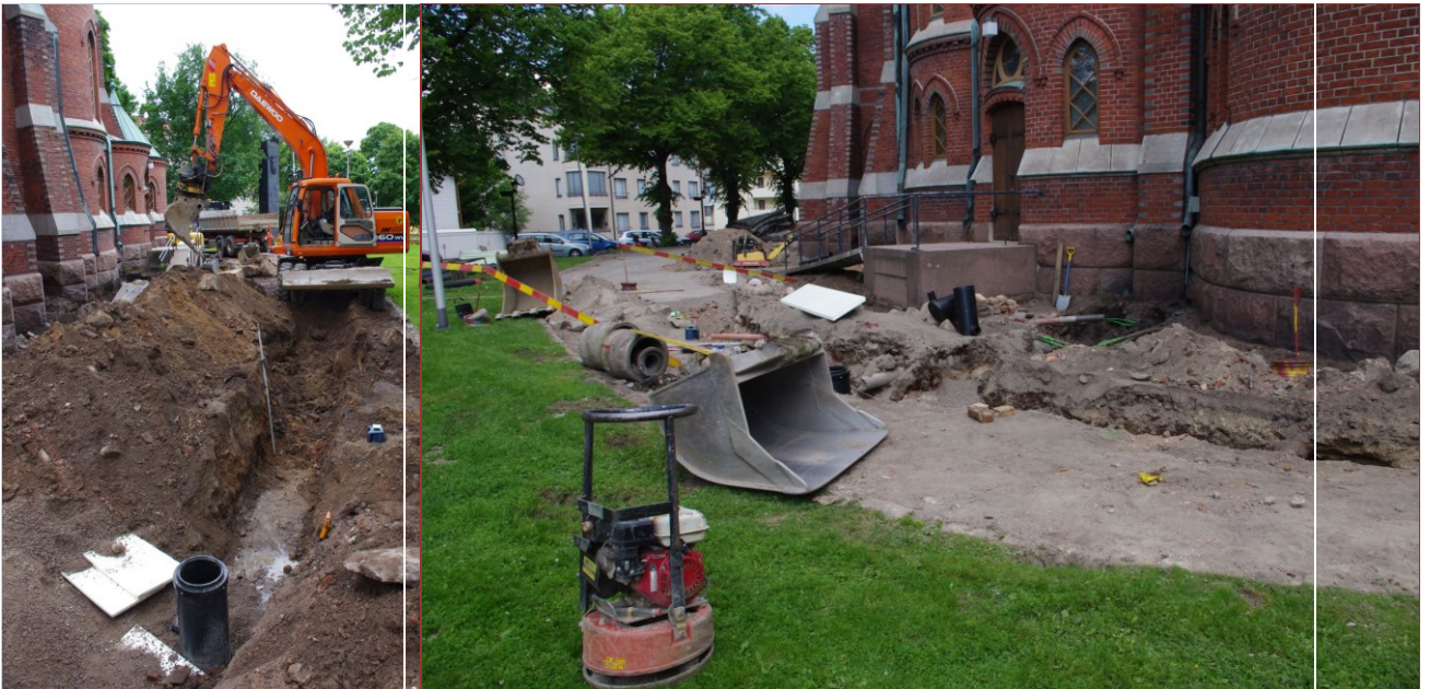
Kuvat 25-26: Vasemmalla kaivetaan alueen VC N-päätä. N. Oikealla edellinen alue peitettynä ja alueen S-pää pohjaan kaivettuna. S. Kuvat: KyM/M. Kykyri.
