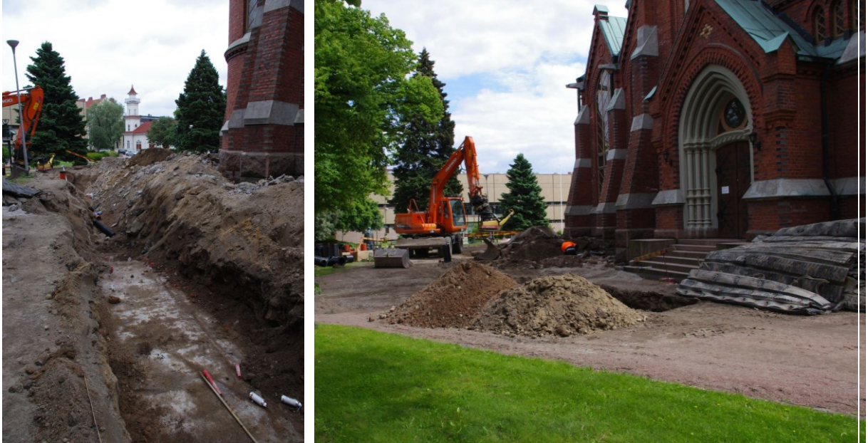
Kuvat 15-16: Vasemmalla alueen VB NE-pää kallion pintaan kaivettuna ja osittain räjäytettynä. SW. Oikealla alueen SW-osaa ennen viemärikaivannon syventämistä. SW. Kuvat: KyM/M. Kyyri.
