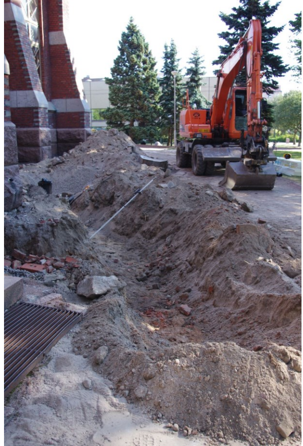
Kuvat 62-63: Vasemmalla kirkon E-sivustaa kallion räjäytyksen jälkeen pohjaan kaivettuna. NW. Oikealla alue VE:n SE-pää pohjasyvyydessä ennen viemäriputkien asentamista. SW. Kuvat: KyM/M. Kyyri.
