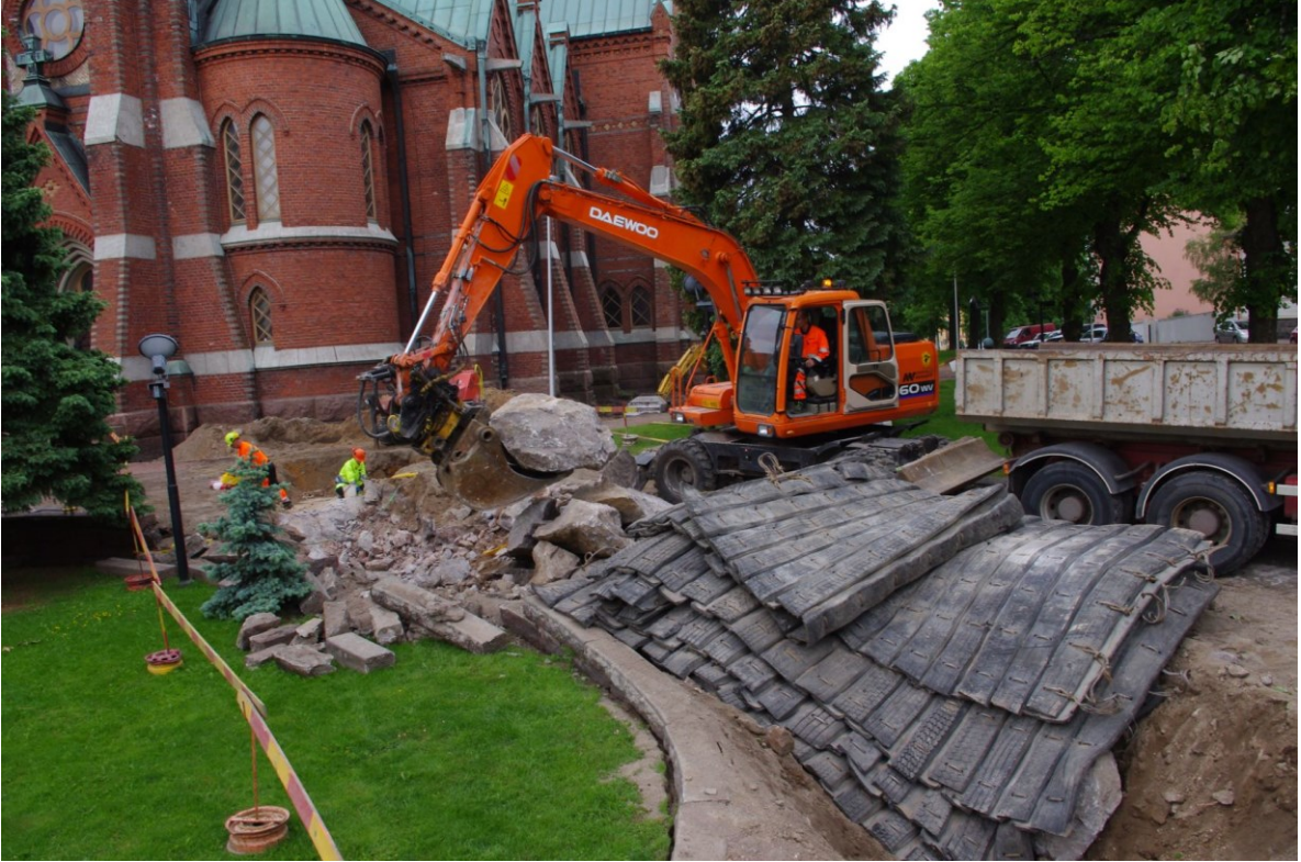
Kuva 4: Räjätettyä kalliota poistetaan alueen VA lounaispäästä ennen räjäytystöiden jatkumista alueelle VB. NE. Kuva: KyM/M. Kykyri.
