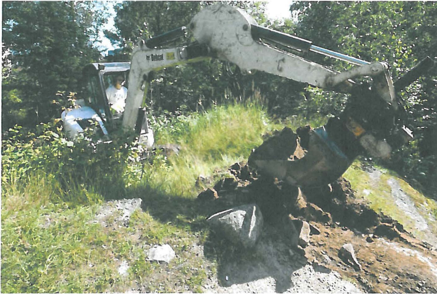
AKDG 4269:12. Koeojaa 5 kaivetaan koneella. Kuva pohjoisesta. Kuvaaja: Vesa Laulumaa/ARKE.
