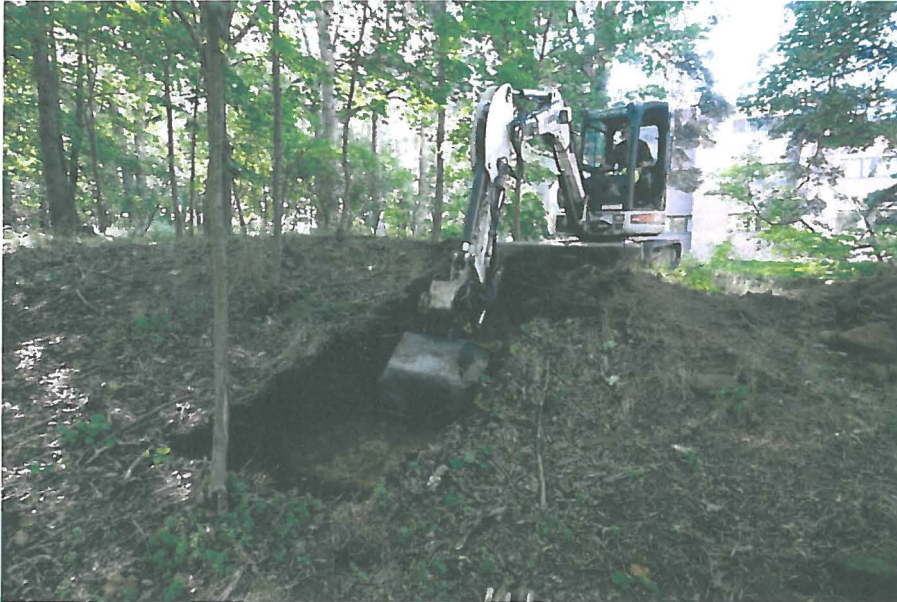
AKDG 4269:4. Työkuva. Koeojaa 1 kaivetaan koneella, kuva pohjoisesta. Kuvaaja: Vesa Laulumaa/ARKE.
