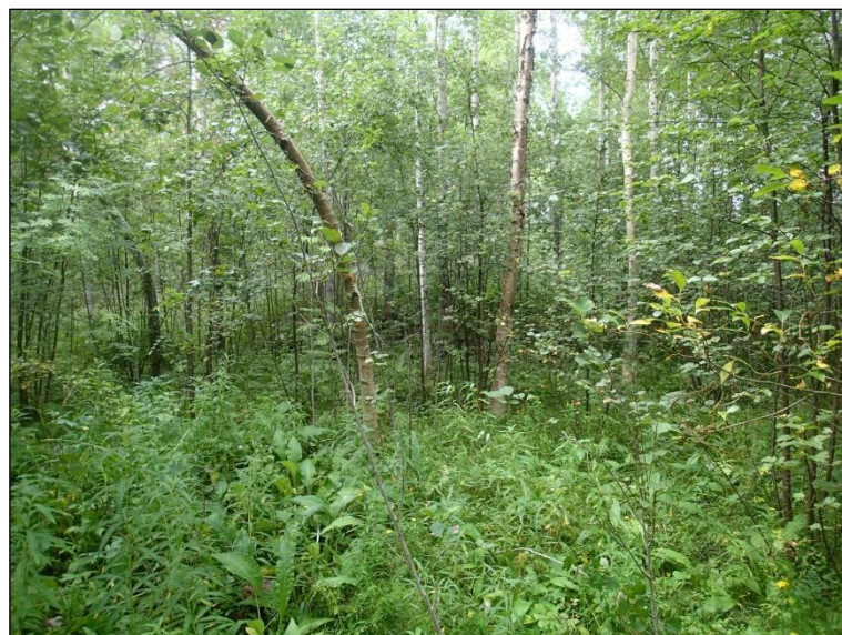
Kuvassa pusikon täysin peittämä rakennuksen perustus (alakohte c). Pohjoiseen.
