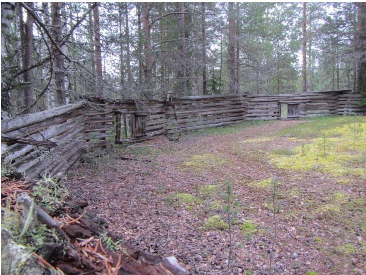
Ruostejänkän erotusaitaa kuvattu lännestä. Kuva I. Nieminen.
