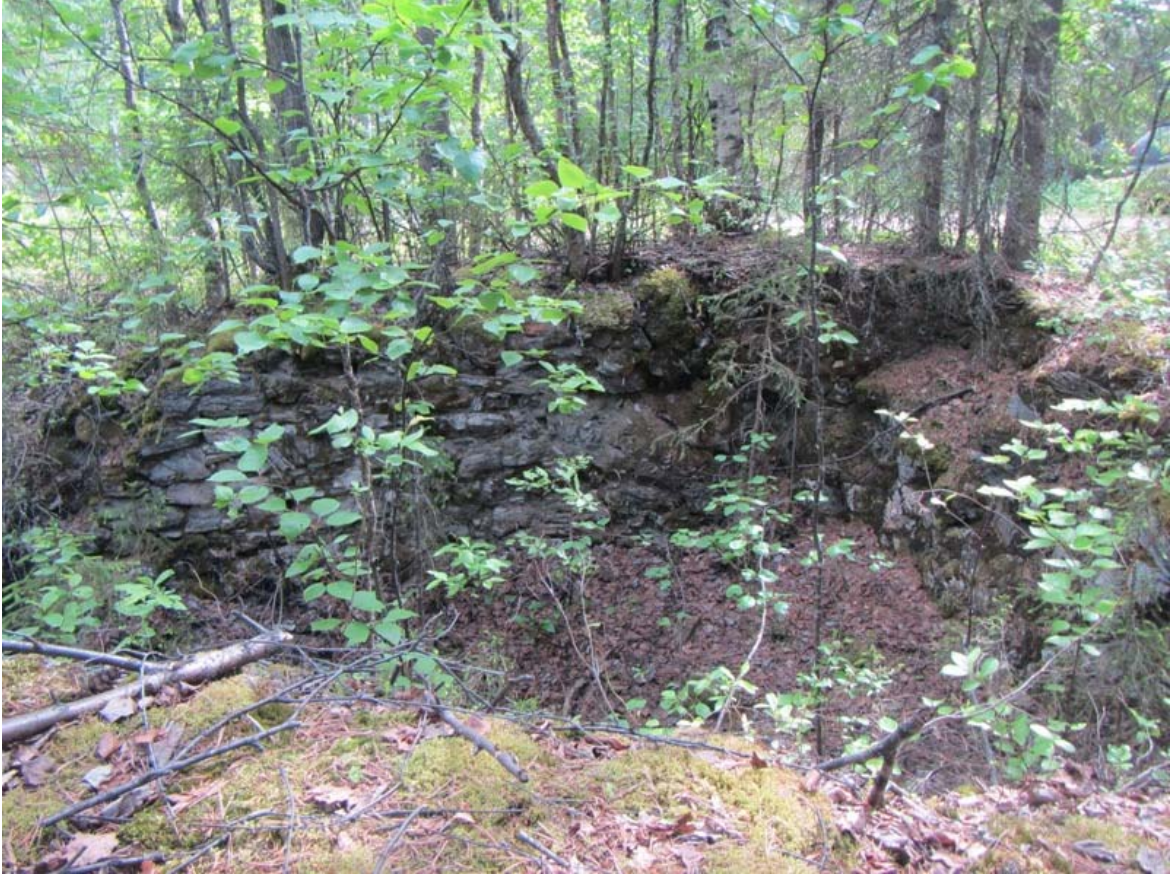
Kalkkitörmä kalkkiuuni a kuvattu pohjoisesta. Kuva I. Nieminen.
