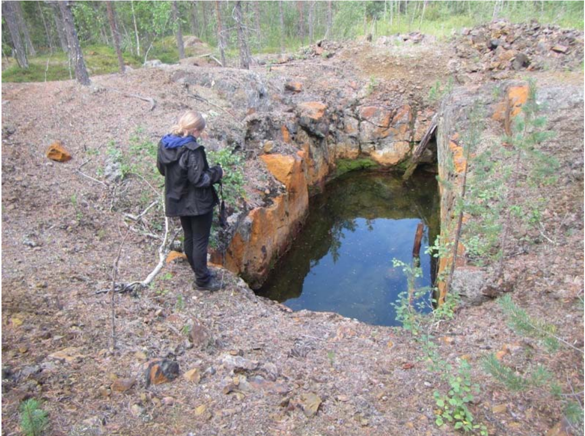
Kuva 4. Juvakaisenmaan kaivanto 5 on peittämättömänä vaarallinen.
