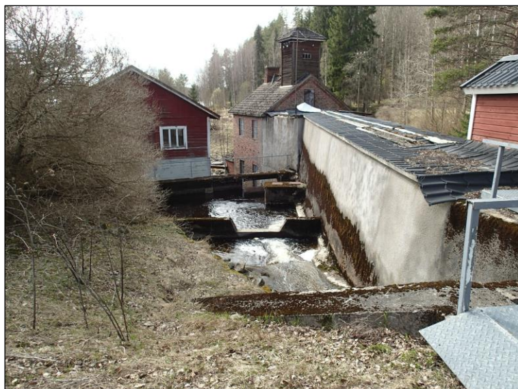
Betonirakenteita koskessa. Pohjoisesta kosken suulta.
