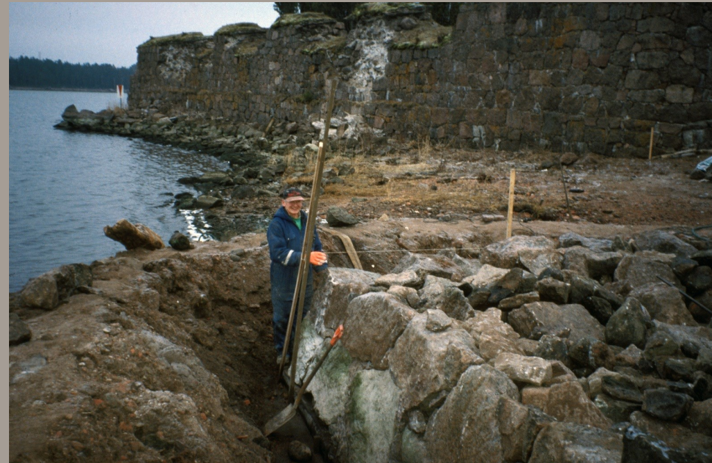
Ahti Nieminen muuraamassa Svartholman pohjoisrannan hirsarkkulaiturin maatukea. Ammattitaitoiset muurarit ovat olleet tärkein restauroinnin onnistumisen edellytys.
