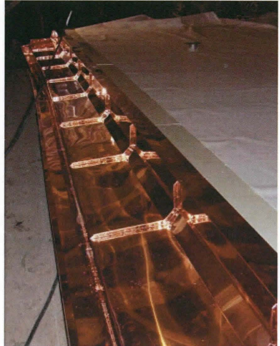
Kuva 4 räystäään pellitys pystysaumalla Valokuva TK
