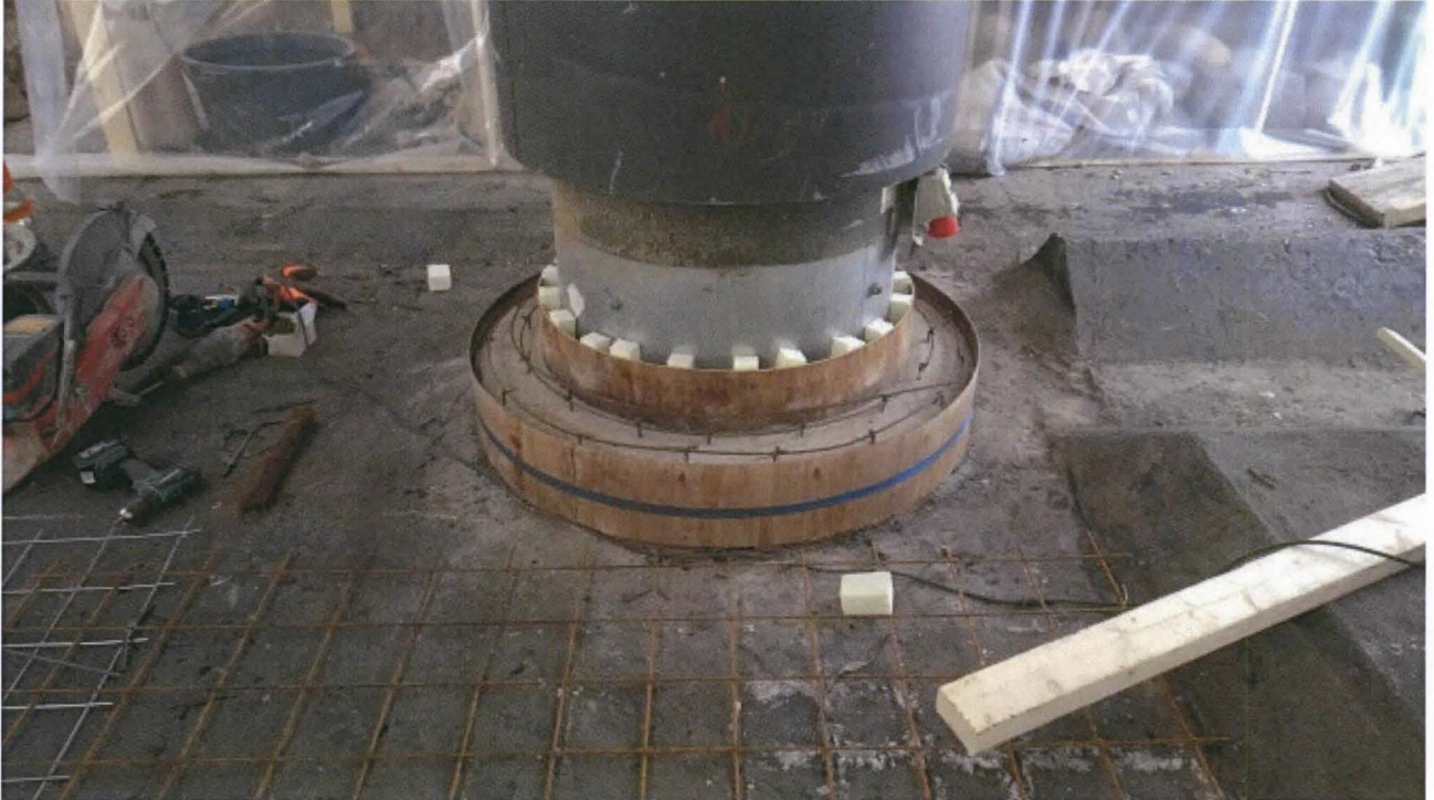
Kuva 6 savunpoistohormi työn aikana. Raudoitukset ja muotit korotusta varten asennettu Valokuva TK
