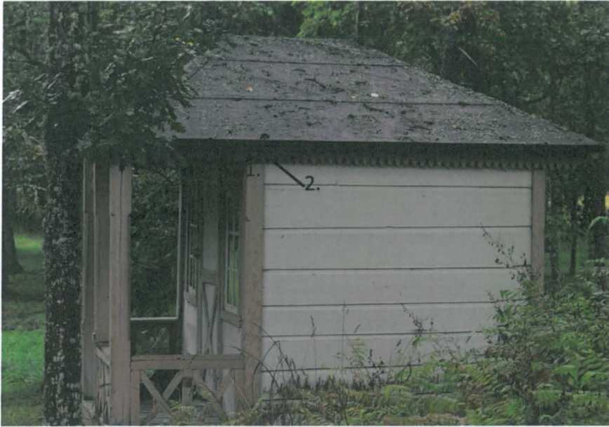
KUVA3. Leikkimökin oikea sivuseinä ja merkinnät tutkimuskohdista.
