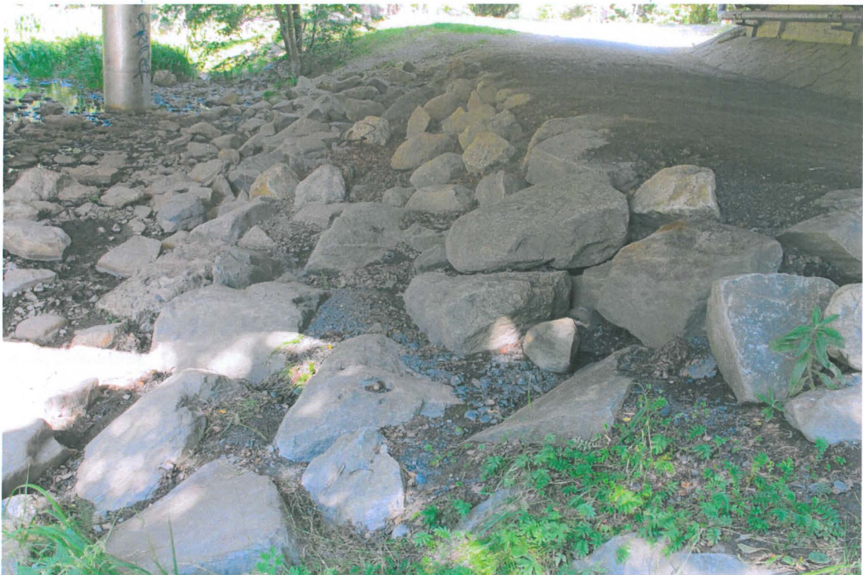
Kuva 1. Hamarintiensillan alla epämääräistä kivikkoa, joen itäpuolelta alajuoksulle kuvattuna. Mukana myös vanhoja kiviä, joissa sisään porattuina metallitankoja.
