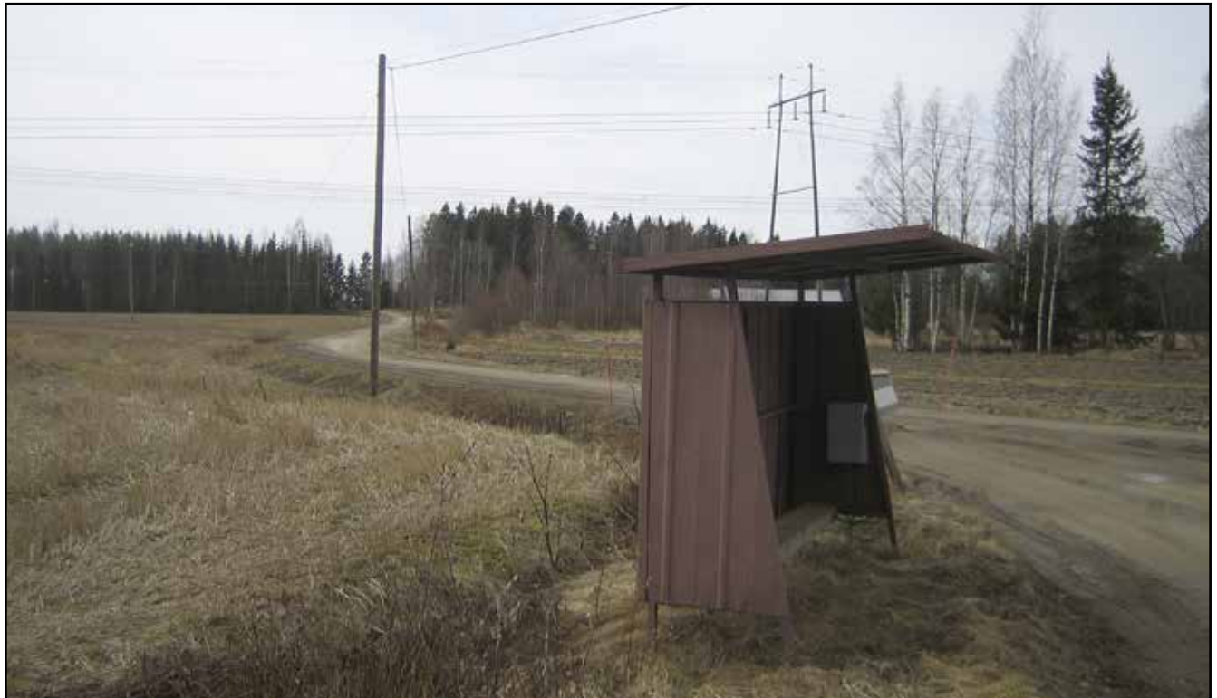
Kuva 7. Eteläisen sähköaseman paikka sähkölinjan alapuolella. Pelto on käännetty vain tien länsipuolella. Kuvattu koillisesta.
