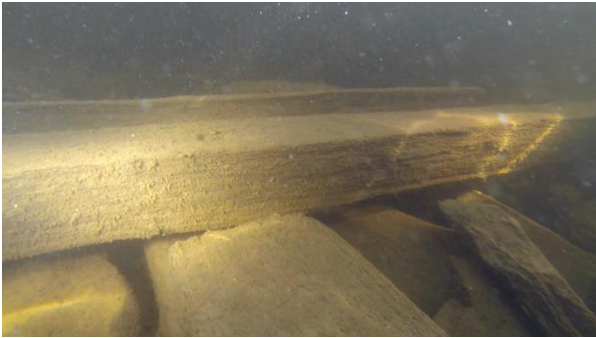
Kohde 3. Idänpuoleisen hirren ulkoreunaan on kiinnitetty lauta kenties ohjuriksi.
