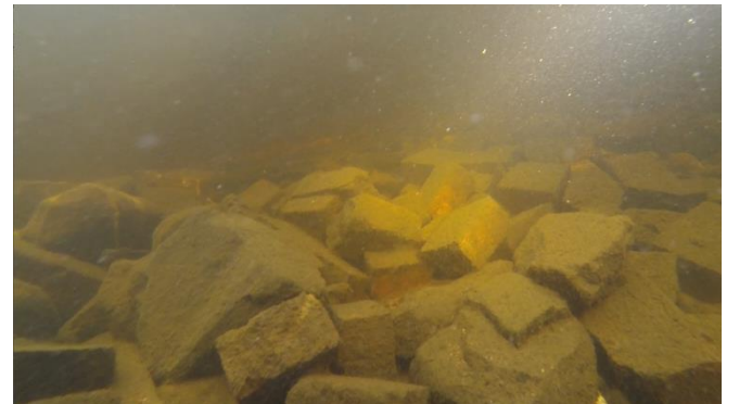
Kohde 2. Laiturin 3 lohcareperustus, jonka päällä ja läheisyydessä on rakennustiiliä.
