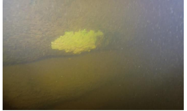
Kohde 4. Hirsiarkun massiivista seinämää.
