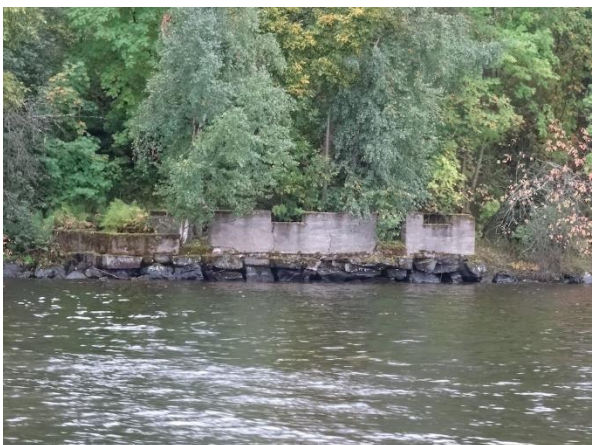
Laiturin 3 edessä oleva betoninen kivijalka rannassa.
