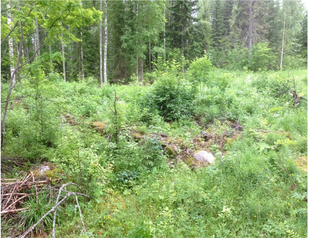
Kuva 182813_3 Pieksämäki Leväniemen virkatalo. Tallirakennuksen kivijalkaa kasvillisuuden seassa.
