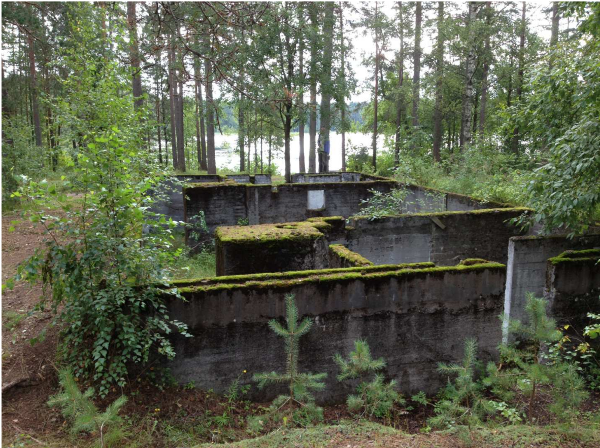
Kuva 182919_6 Virolahti Valkjärvi. Rakennuksen kellarin sisärakennetta.
