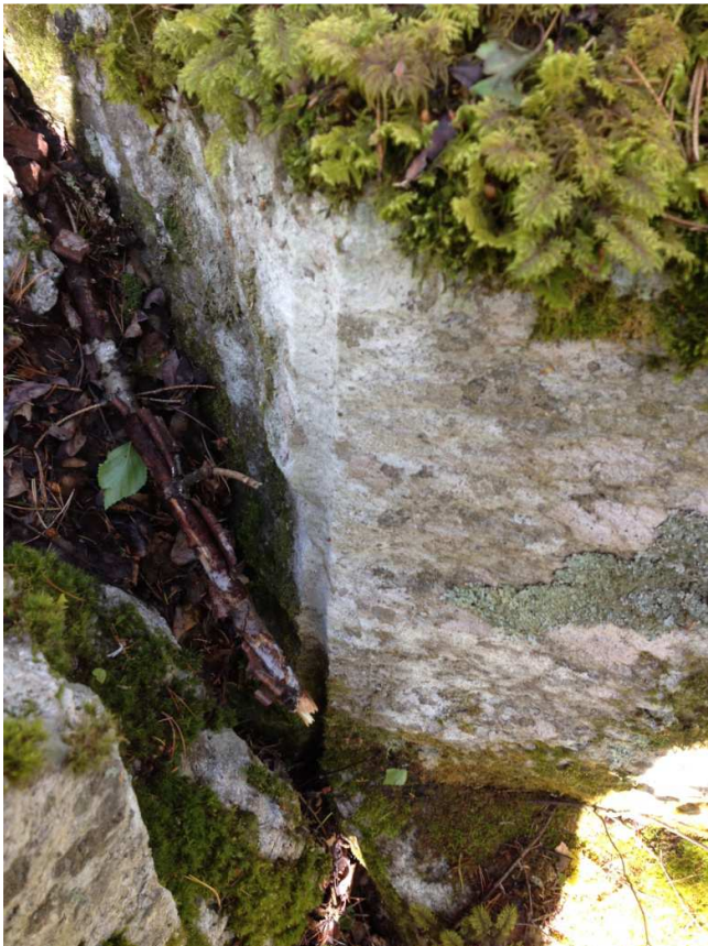
Kuva 182661_2 Mikkeli Karjalampi 1. Kivilouhos. Yksityiskohta porausjäljestä.
