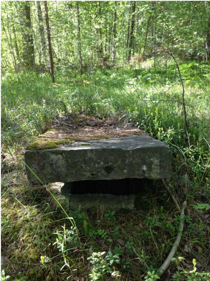
Kuva 183538_2 Mikkeli Karjalampi 2. Varaston ilmahormi.
