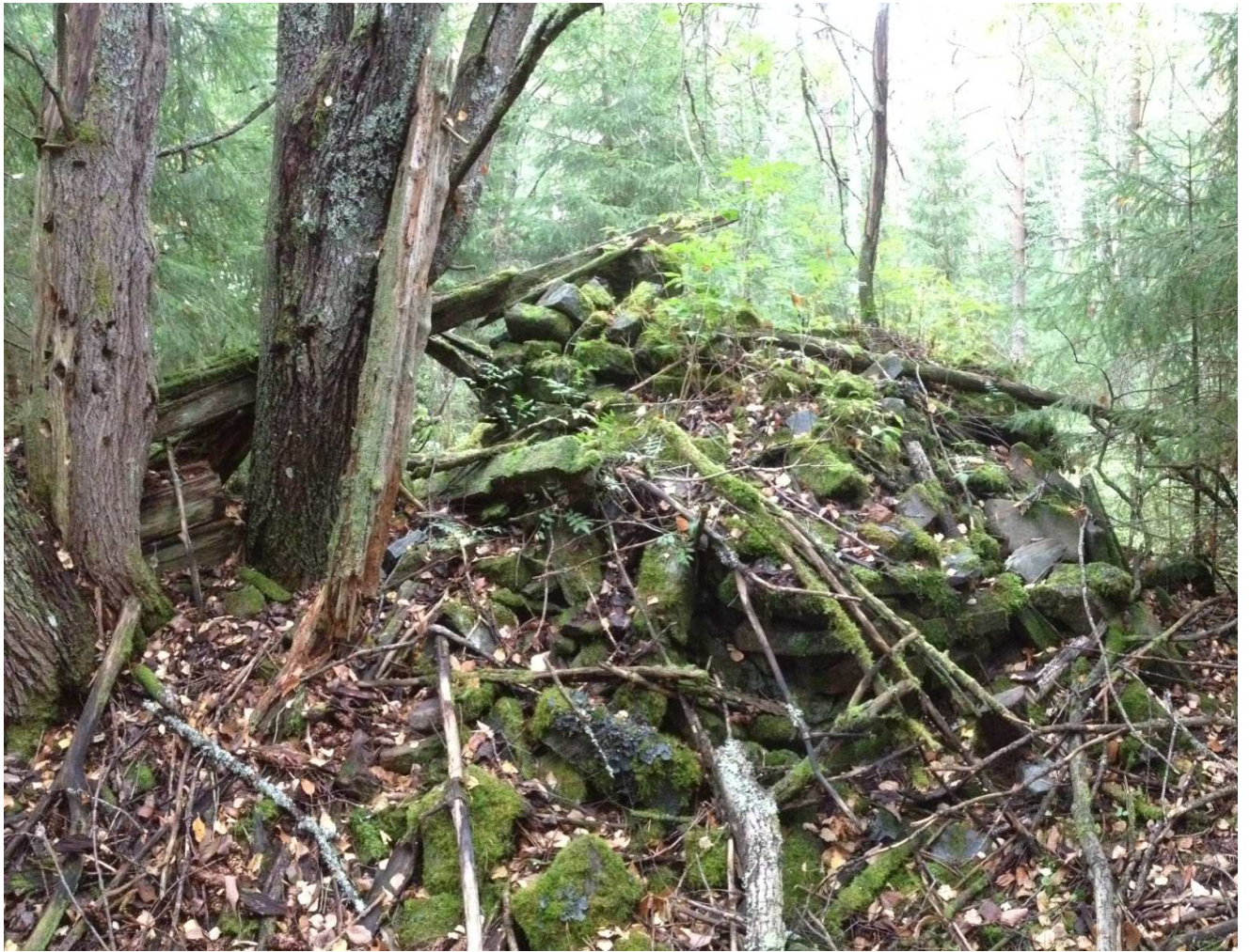
Kuva 182682_3 Mäntyharju Pyyniemi. Rakennuksen uuni.
