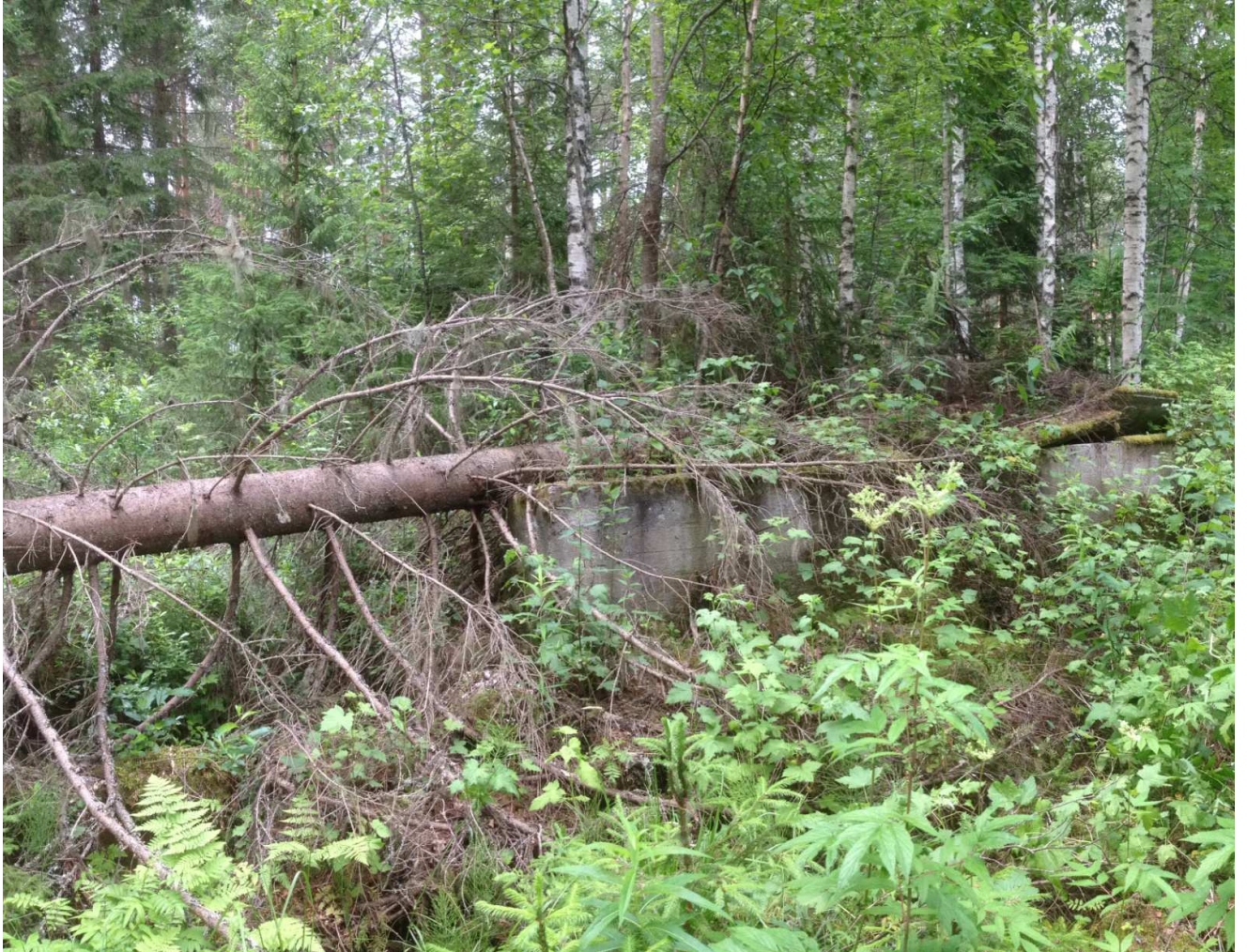
Kuva 182808_3 Pieksämäki Soleikon virkatalo. Sivurakennuksen valettua perustusta tien pohjoispuolella.
