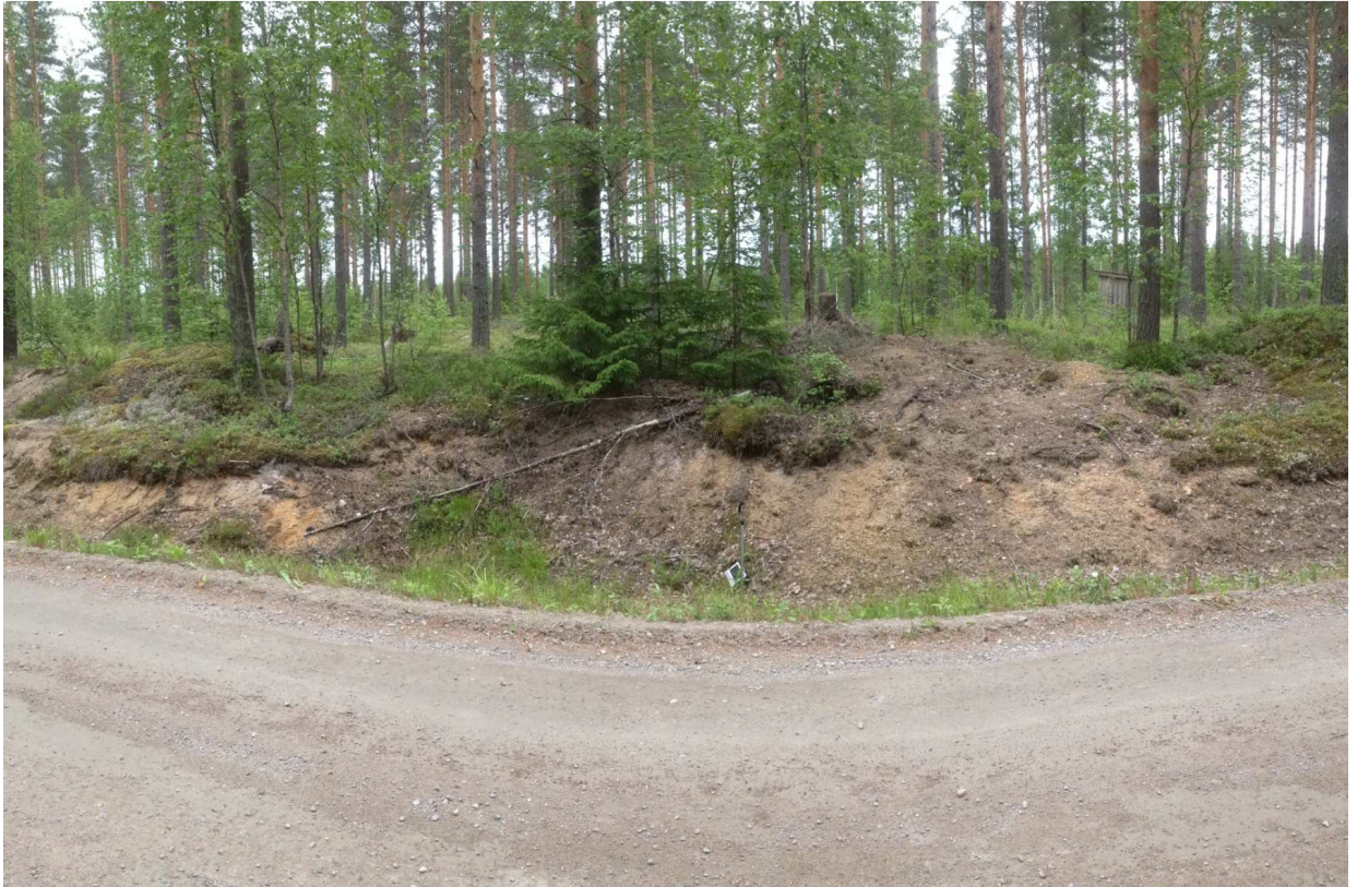
Kuva 182458_1 Joroinen Niilonmaa 1. Hiilimiilu erottuu vaivoin leikkauksessa.
