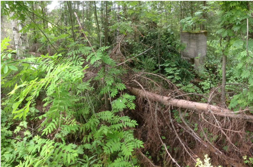
Kuva 182808_2 Soleikon virkatalo. Sivurakennuksen valettua perustusta pilkottaa puiden alta.
