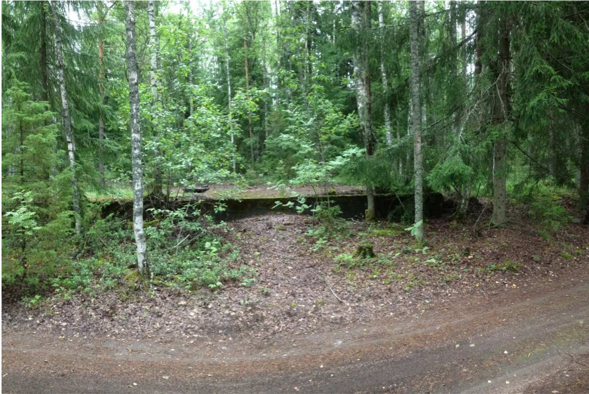
Kuva 182631_1 Lemi Lieslahti. Betoninen kivijalusta. Lännestä.
