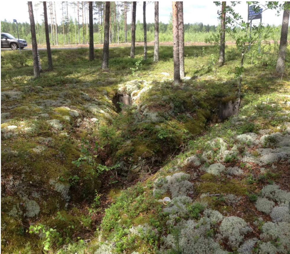
Kuva 183549_8 Savitaipale Kupulankangas. Betonilla suojatut tuliasemat alueen luoteisnurkassa.
