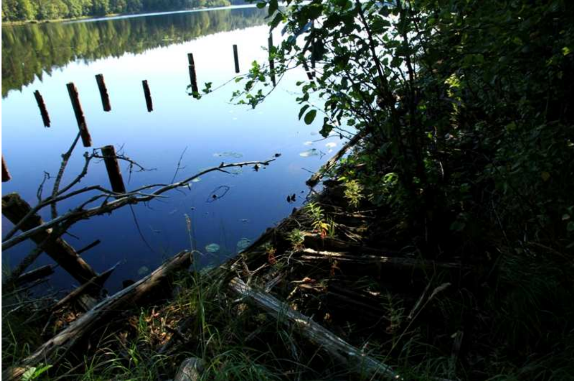
Kuva 182249_4. Laiturin rakennetta vedessä, kuvattu luoteesta.
