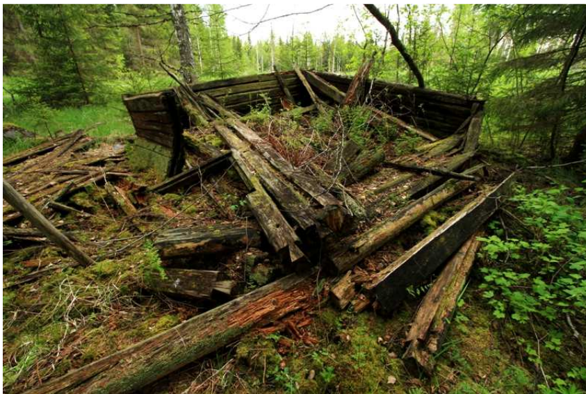
Kuva 180991_1. Rakennus 3, kuvattu kaakosta.
