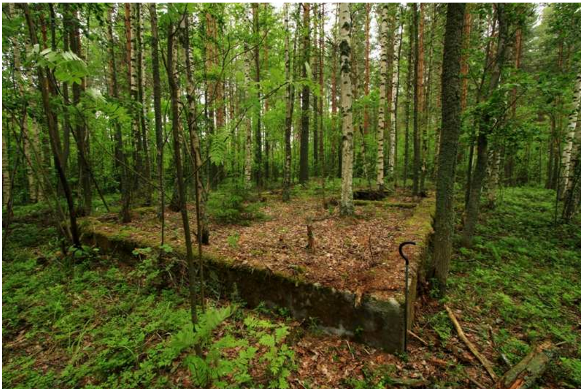
Kuva 182571_2. Rakennuksen I perustus. Kuvattu kaakosta.
