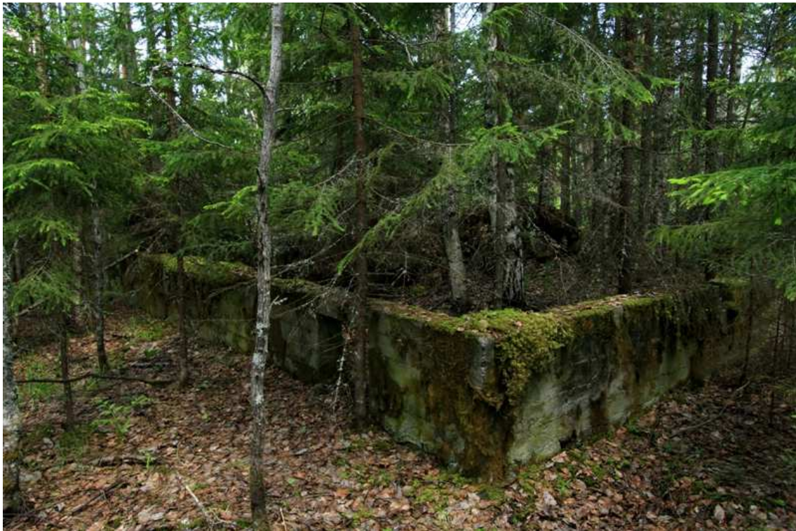
Kuva 180057_1. Kämpän pohjoisnurkka, kuvattu pohjoisesta.
