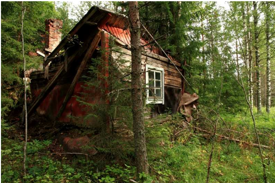
Kuva 181181_1. Päärakennus, kuvattu lännestä.
