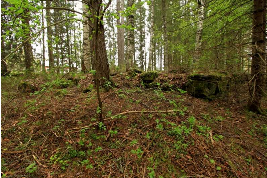
Kuva 179930_2. Rakennuksen 1 kaakkoisnurkkaa, kuvattu kaakosta.
