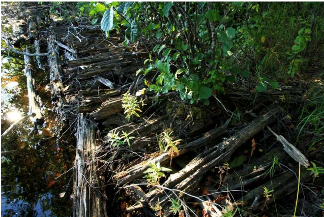
Kuva 182249_5. Laiturin rakennetta rannassa, kuvattu luoteesta.
