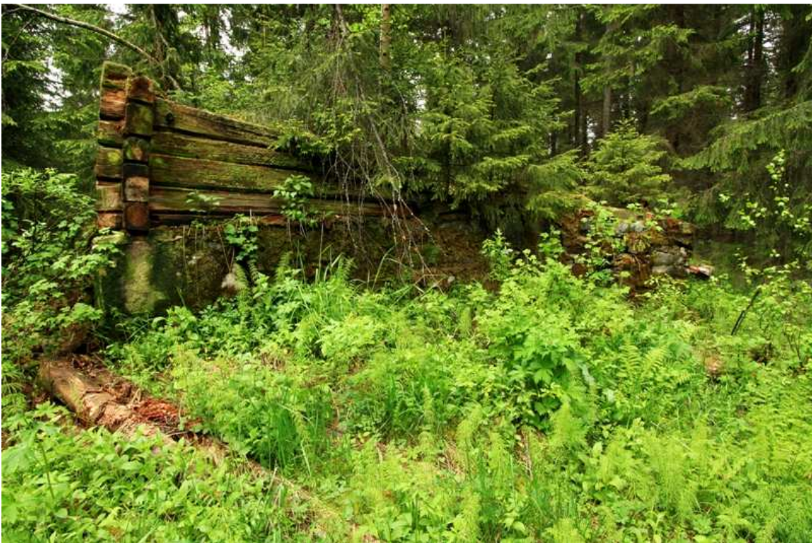
Kuva 180054_4. Rakennus 2, kuvattu kaakosta.
