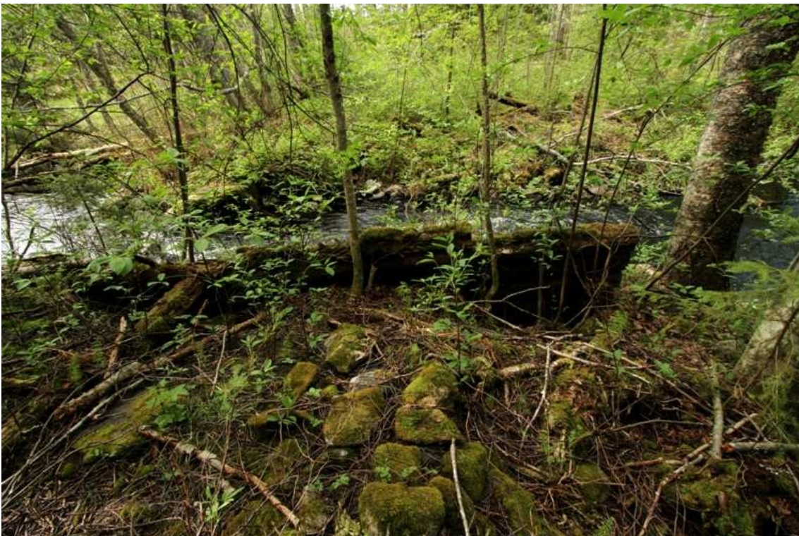
Kuva 180033_9. Rannassa säilyneitä puurakenteita, jotka kuuluvat mahdollisesti patoon. Kuvattu koillisesta.
