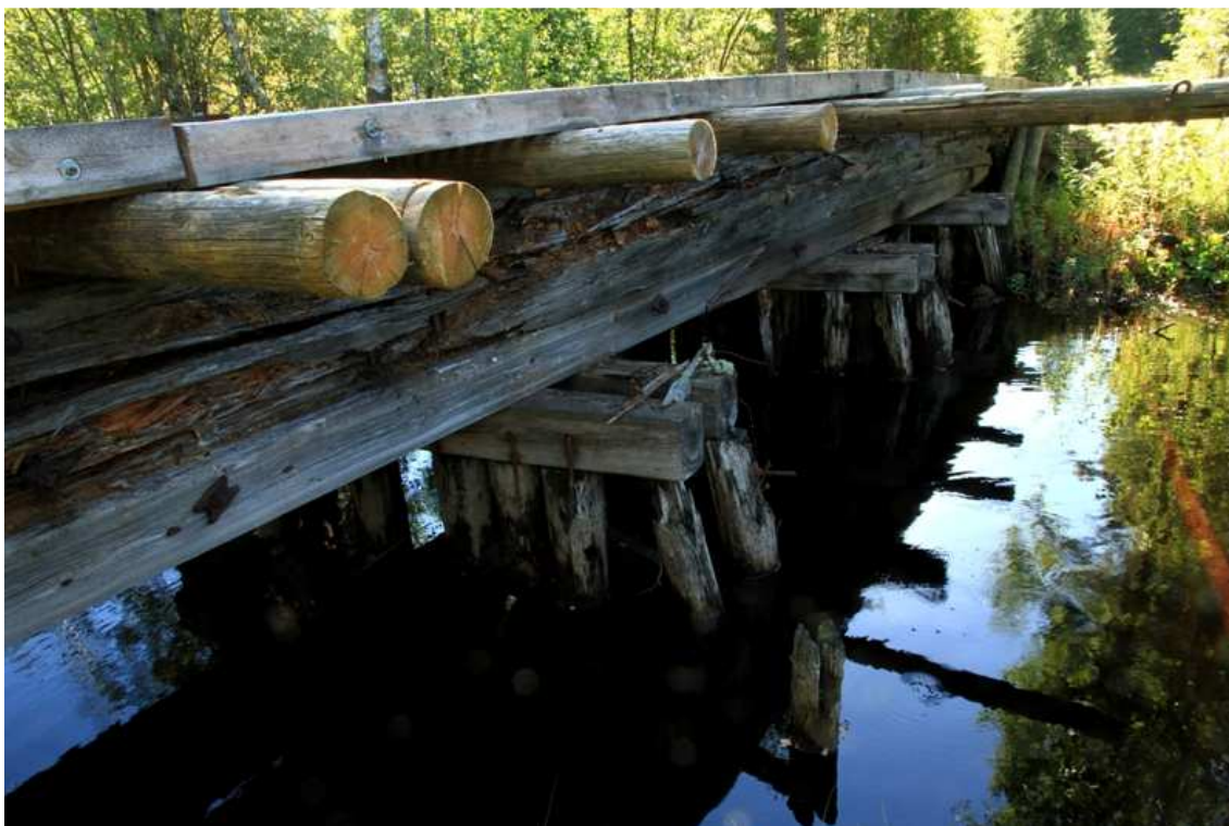
Kuva 182249_3. Sillan alkuperäistä rakennetta uusitun kannen alla.
