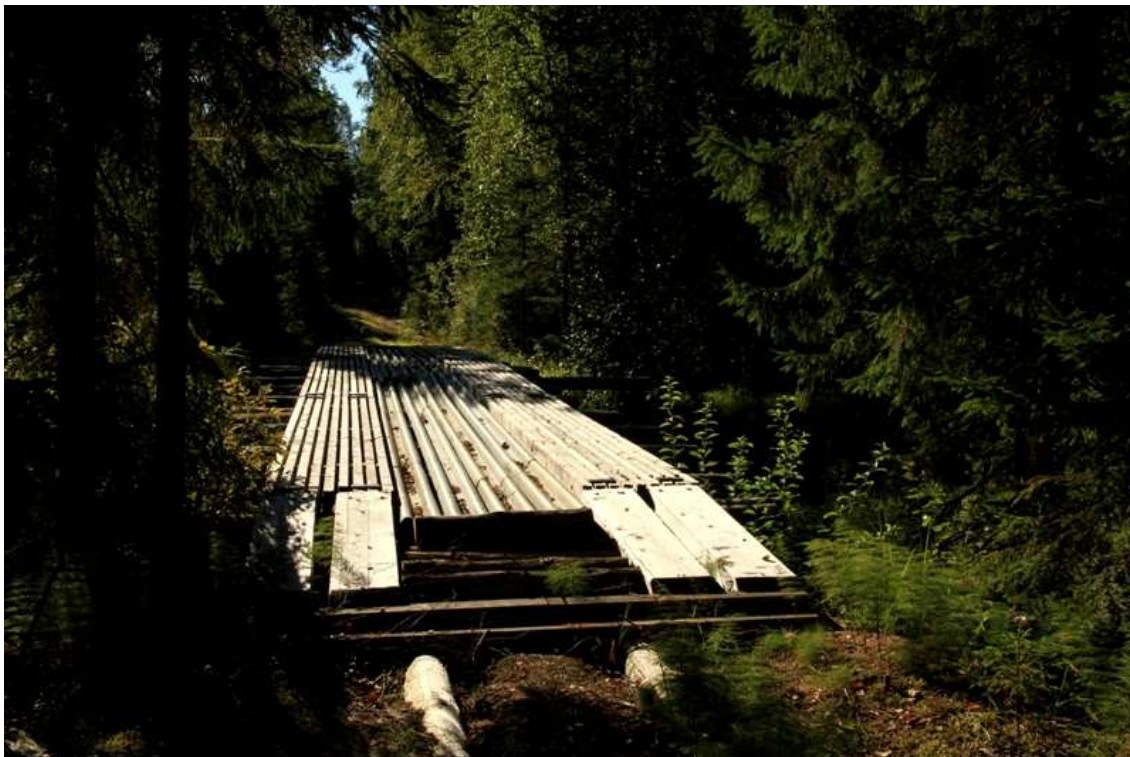
Kuva 182249_2. Korjattu silta ja radanpohjaa. Kuvattu luoteesta.
