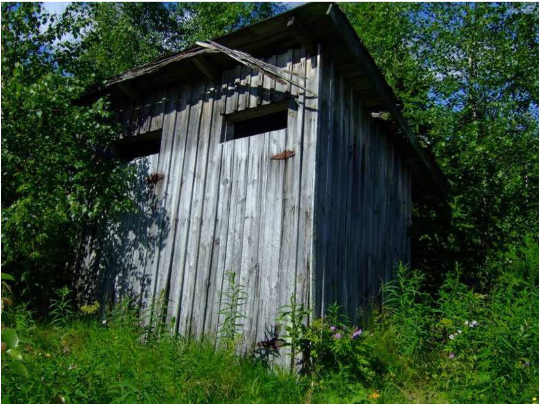
Kuva 109. Käymälä, kuvattu kaakosta.
