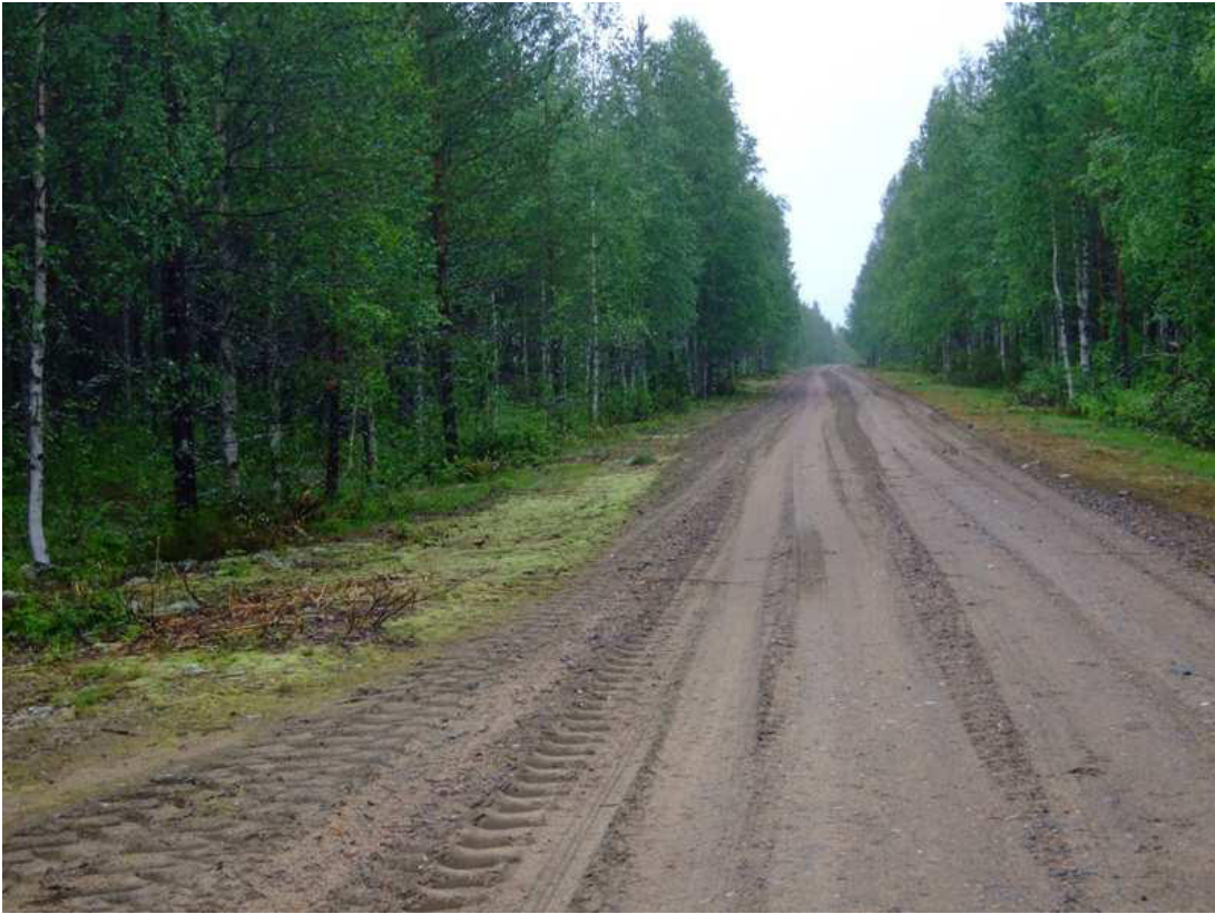
Kuva 113. Kiitorata, kuvattu kaakosta.
