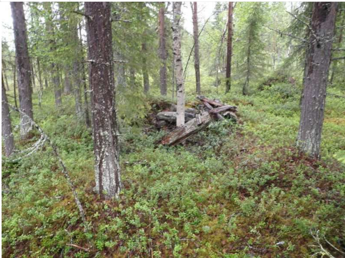
Rakennuksen lahonneita hirsirakenteita.
