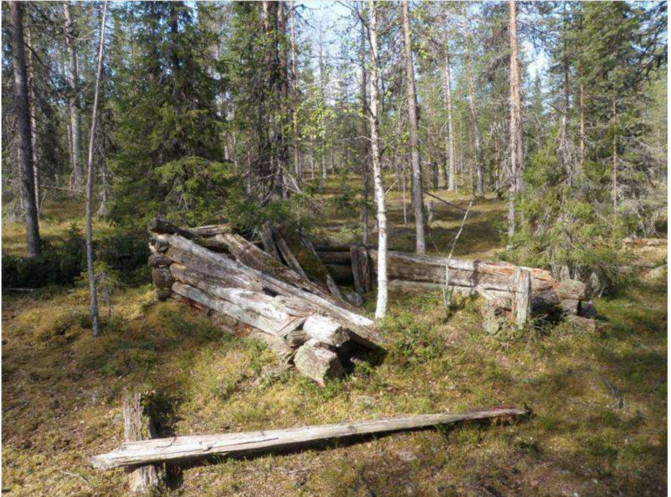
Kämpän 1 seinähirret. Kämpä 2 on vanhempi ja sen rakenteet ovat huonommin säilyneet.
