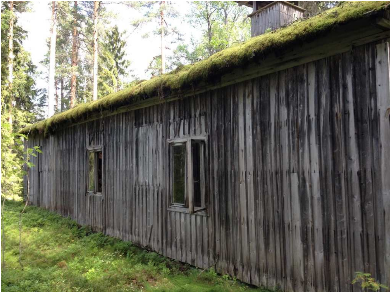
Kuva 7. Kalliolammen kämpän tallin seinää. Rakennus lienee vanhempi kämpärakennus josta on myöhemmin tehty talli.
