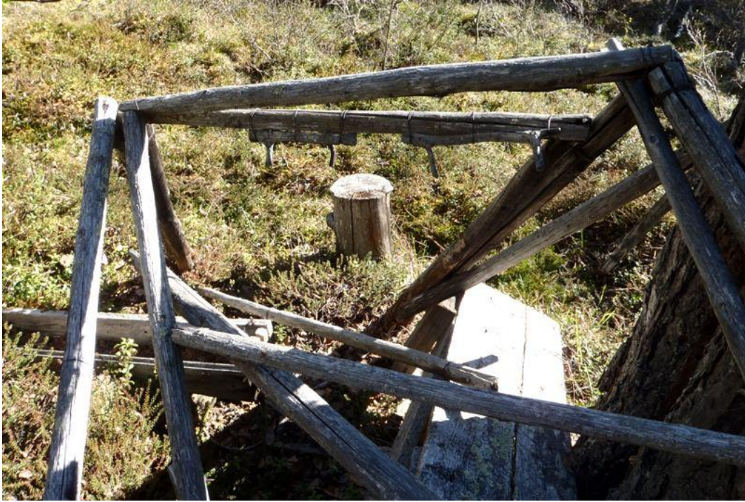
Kuva 86. Puurakenteen puiset koukut. Kuvattu etelälounaasta.
