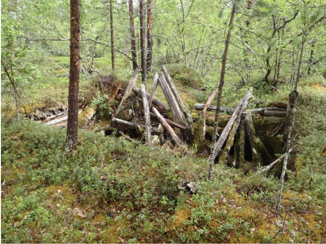
Kuva 91. Korsi on kaivettu maahan ja rakennettu pyöreistä puista, joiden kiinnittämiseen on käytetty nauvoja ja rautalankaa. Sen katto on romahtanut. Kuvattu etelälounaasta.
