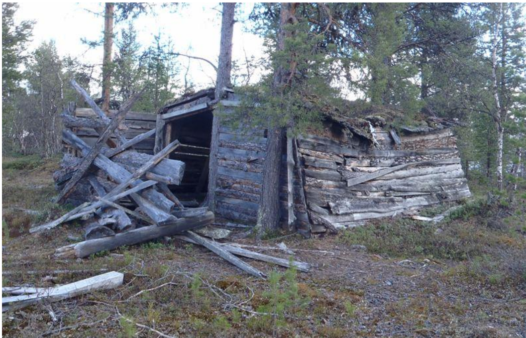
Kuva 42. Yleiskuva porosuojusta. Kuvattu länsilounaasta.
