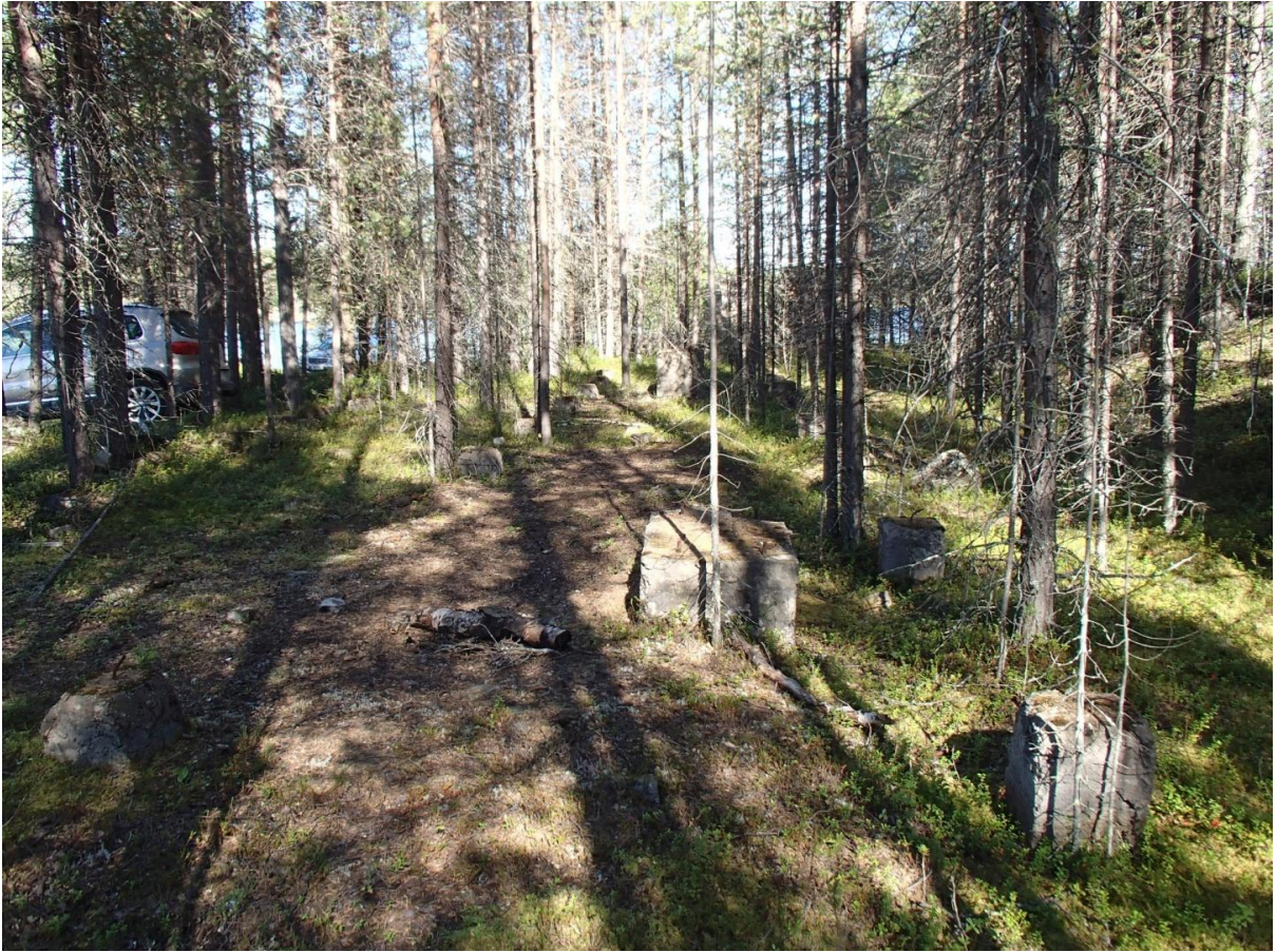
Betonirakenteita rakennuksen 1 eteläpäässä pohjoiseen.
