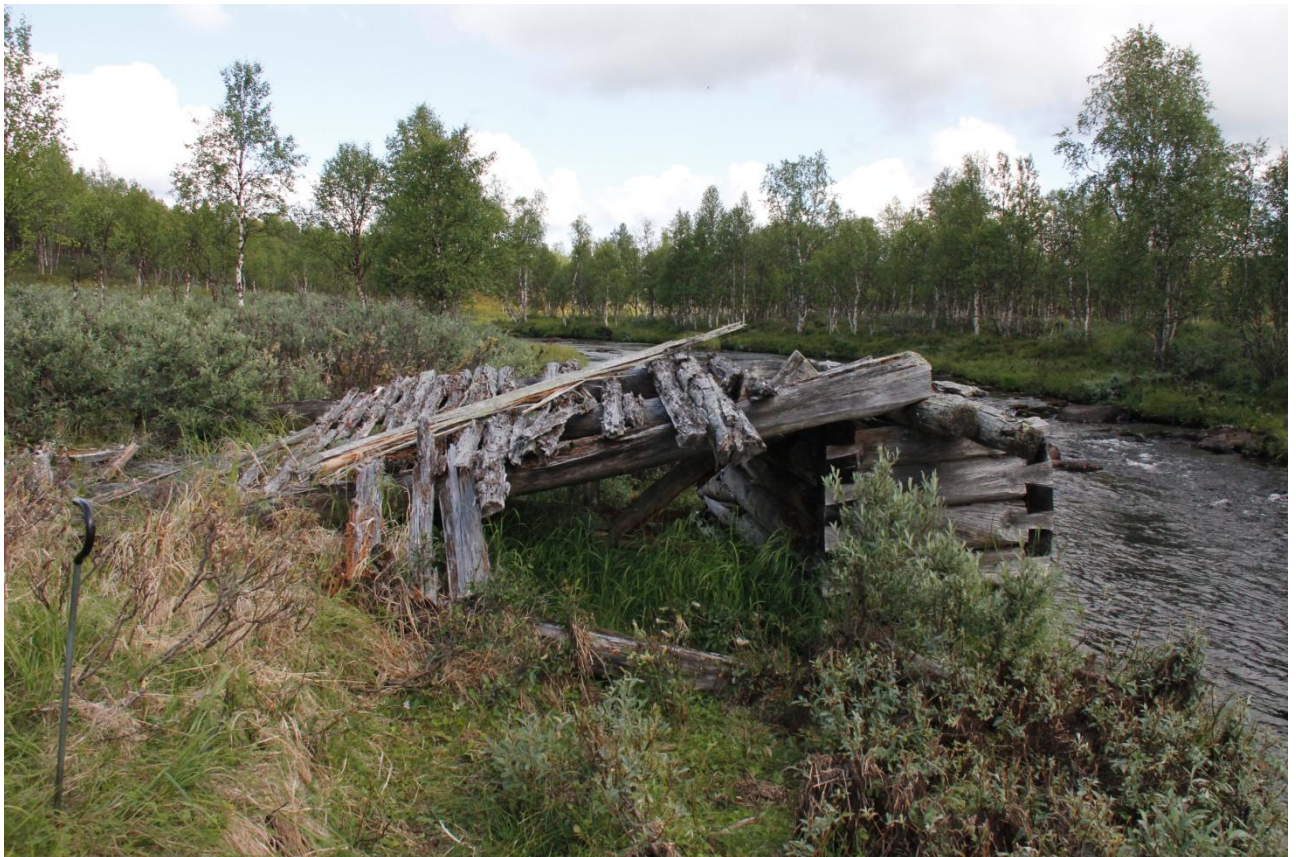
Sillan jäännös pohjoiseen.
