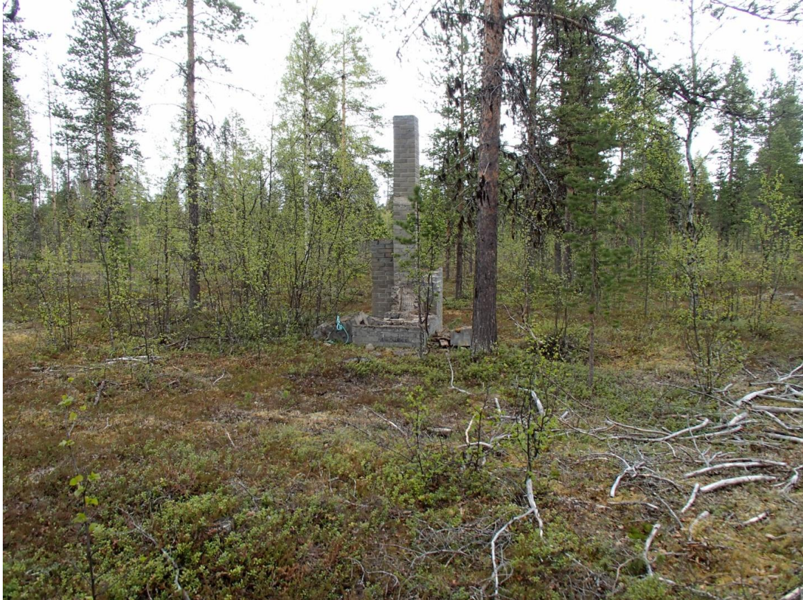
Rakennelma 1, betonitiilistä muurattu piippu koilliseen.
