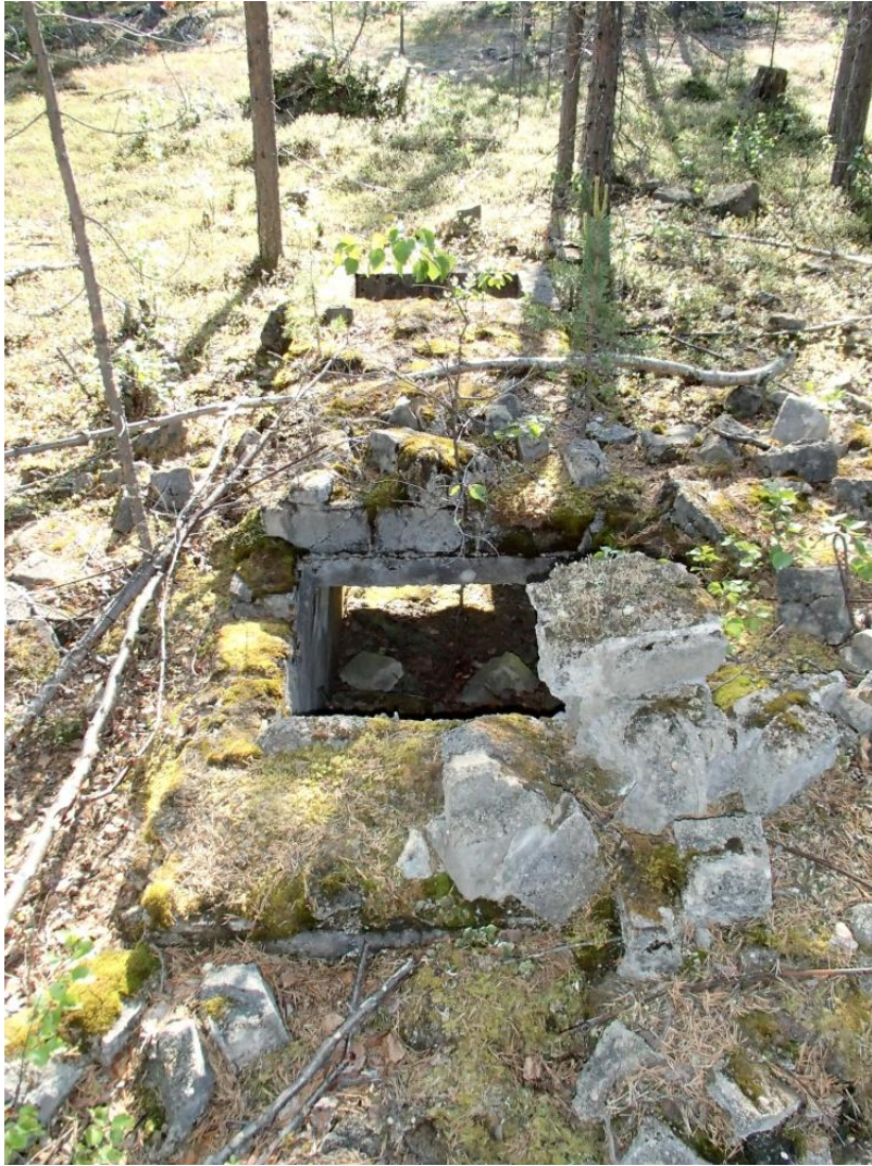
Rakennelma 19, kaksi aukkoa betonirakenteessa, kuvattu itään.
