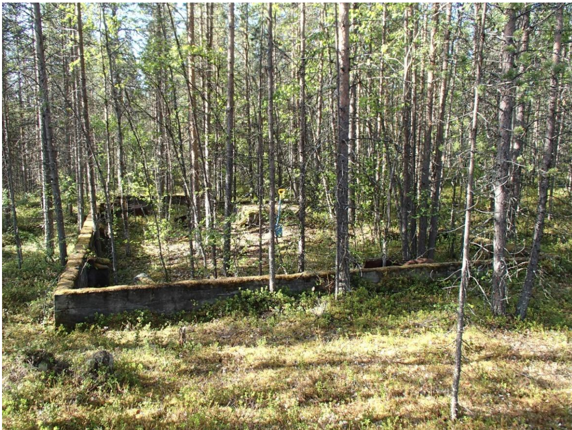
Betoninen kivijalka etelään.
