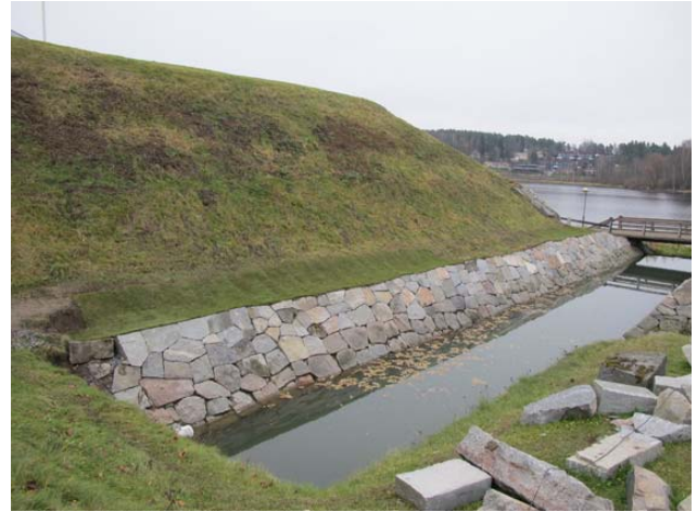
Kuva: 5. puolibastionin eskarppimuurin oikean sivun takaa poistettiin maata ennen korotustöiden aloittamista. Korotettun muurin taustalle laitettiin siirtonurmea ja keskellä on koealue, jossa on nurmikuntaa. Päivi Hakanpää, Museovirasto. AKDG4222:85 ja :87.
