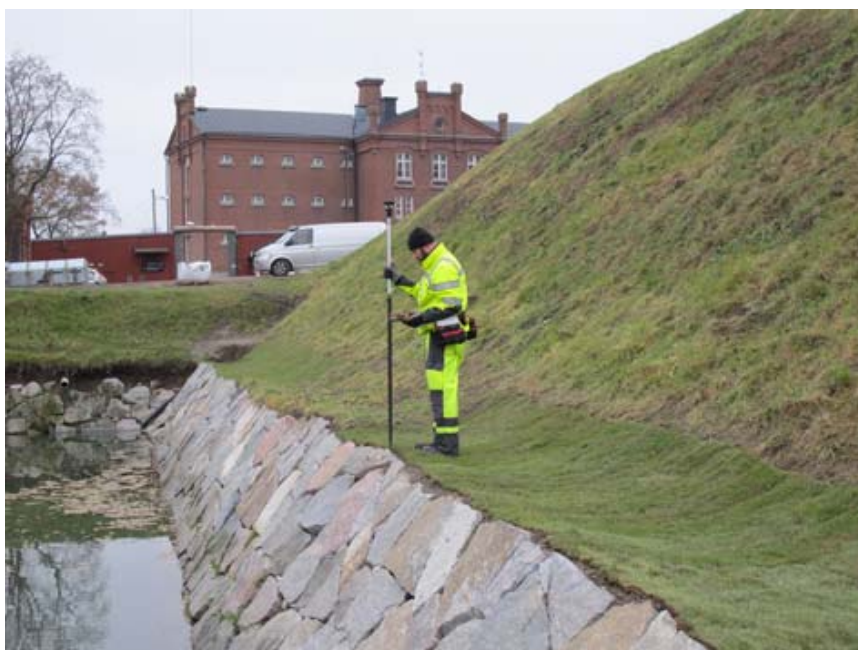
Kuva: Janne Hymylä on mittaamassa 5. puolibastionin eskarppimuurin korotuksia. AKDG4222:103, Päivi Hakanpää, Museovirasto.
