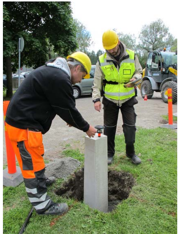
Kuvat: Jari Kaseva ja Ville Nieminen asentavat tolppaa kuoppaan. Betonitolpan paikkaa ovat tarkistamassa Jari Kaseva ja Janne Hymylä. AKDG4222:9-10, Päivi Hakanpää, Museovirasto.
