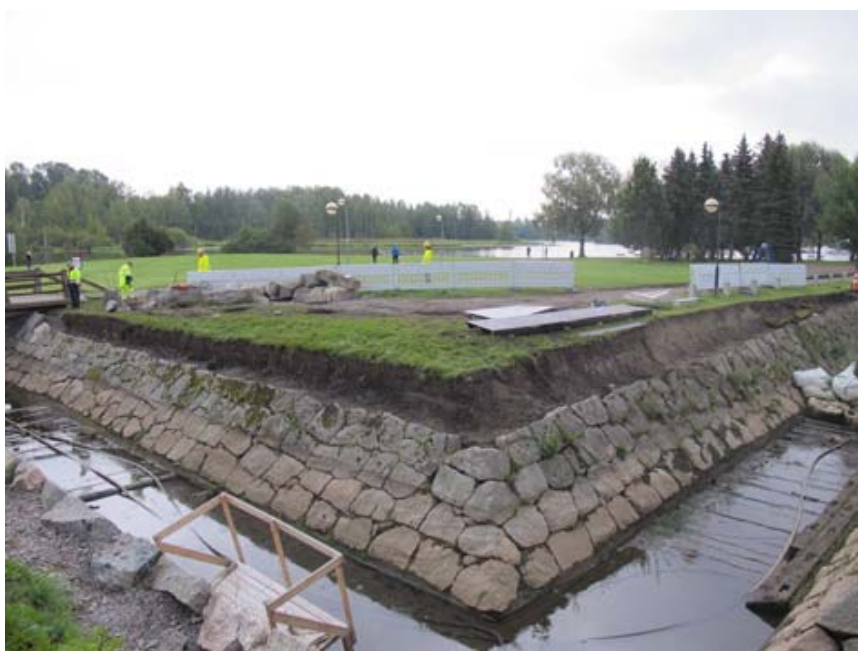
Kuva: 5. ja 4. puolibastionien kontreskarppimuurien taustat avattuina elokuussa 2014. AKDG4222:92, Päivi Hakanpää, Museovirasto.
