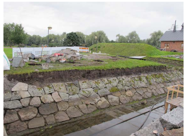
Kuva: 5. puolibastionin oikean sivun kontreskarppimuuri ennen korottamista. Muurin takaa poistettiin maata ennen korotustöiden aloittamista. Päivi Hakanpää, Museovirasto. AKDG4222:89 ja :91.
