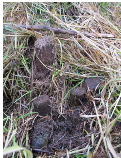
Kuvat: Paalujen päät oli sahattu ja osa puupaaluista oli kasvillisuuden peittämiä. AKDG4222:69–70, Janne Hymylä ja Päivi Hakanpää, Museovirasto.
