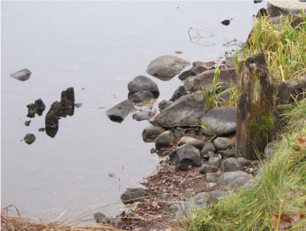
Kuva: Itäosassa paalut olivat vedessä. Etualalla näkyy iso paalu, joka todennäköisesti on puretun puusillan perustuksia. AKDG4222:74 Museovirasto, Janne Hymylä.
