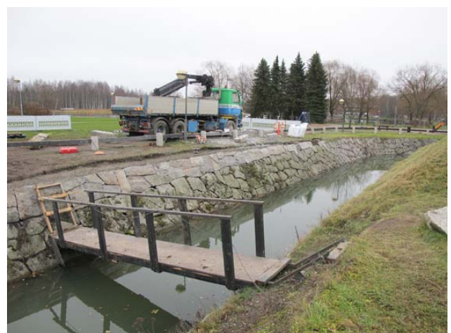
Kuva: 5. puolibastionin kontreskarppimuurin korotus ja aita valmiina, sekä 4. puolibastionin kontreskarppimuurin vasemman sivun eteläosan korotus on valmis Päivi Hakanpää, Museovirasto. AKDG4222:93 ja :99.
