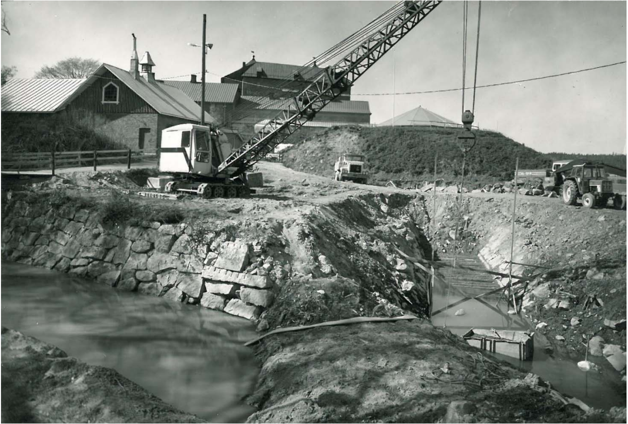
Kuva: Vuonna 1987 kaivettiin esiin 4. puolibastionin purkamiselta säästyneitä eskarppi- ja kontreskarppimuurin osia sekä vallihautaa. Maavallit oli tasattu jo 1800-luvun lopulla. RHO 8982, Museovirasto, Hämeen linna.
