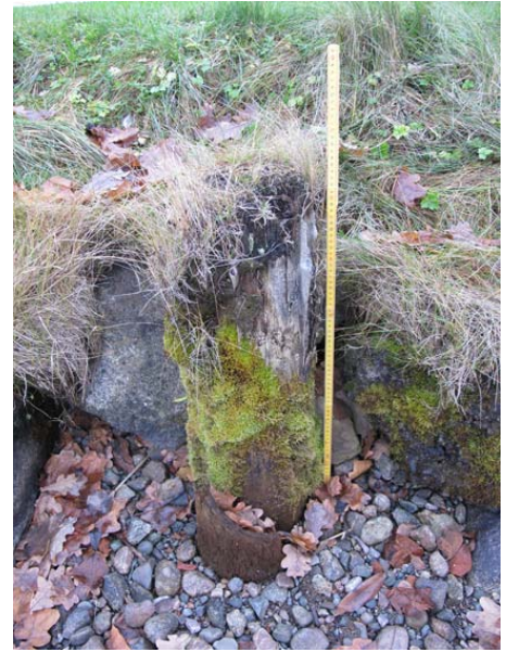
Kuvat: Eteläpuolen itäosassa oli kolme paalua rinnakkain. Rantatörmällä oli halkaisijaltaan 24 cm:n kokoinen paalu. Se lienee kuulunut puretun puusillan rakenteisiin AKDG4222:77 ja :76, Museovirasto, Janne Hymylä.
