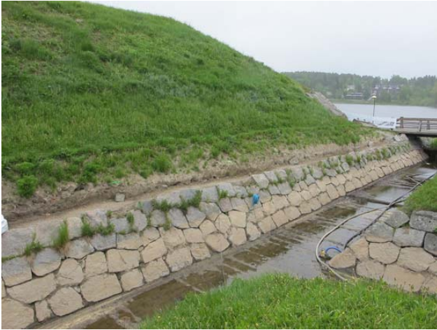
Kuva: 5. puolibastionin eskarppimuurin oikean sivun takaa poistettiin maata ennen korotustöiden aloittamista. Korotettun muurin taustalle laitettiin siirtonurmea ja keskellä on koealue, jossa on nurmikuntaa. Päivi Hakanpää, Museovirasto. AKDG4222:85 ja :87.
