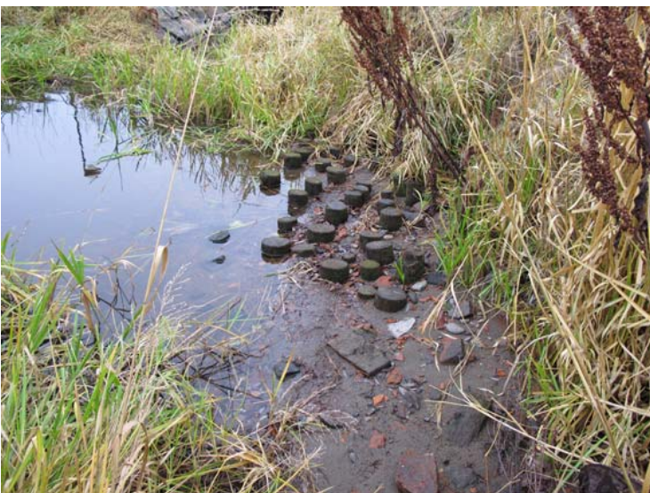
Kuvat: Paalujen päät oli sahattu ja osa puupaaluista oli kasvillisuuden peittämiä. AKDG4222:69–70, Janne Hymylä ja Päivi Hakanpää, Museovirasto.
