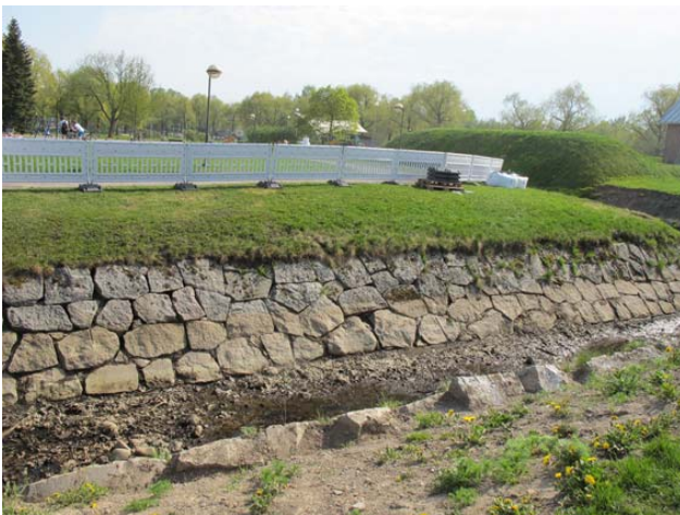
Kuva: 5. puolibastionin oikean sivun kontreskarppimuuri ennen korottamista. Muurin takaa poistettiin maata ennen korotustöiden aloittamista. Päivi Hakanpää, Museovirasto. AKDG4222:89 ja :91.
