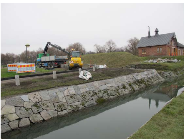
Kuva: 5. puolibastionin kontreskarppimuurin korotus ja aita valmiina, sekä 4. puolibastionin kontreskarppimuurin vasemman sivun eteläosan korotus on valmis Päivi Hakanpää, Museovirasto. AKDG4222:93 ja :99.
