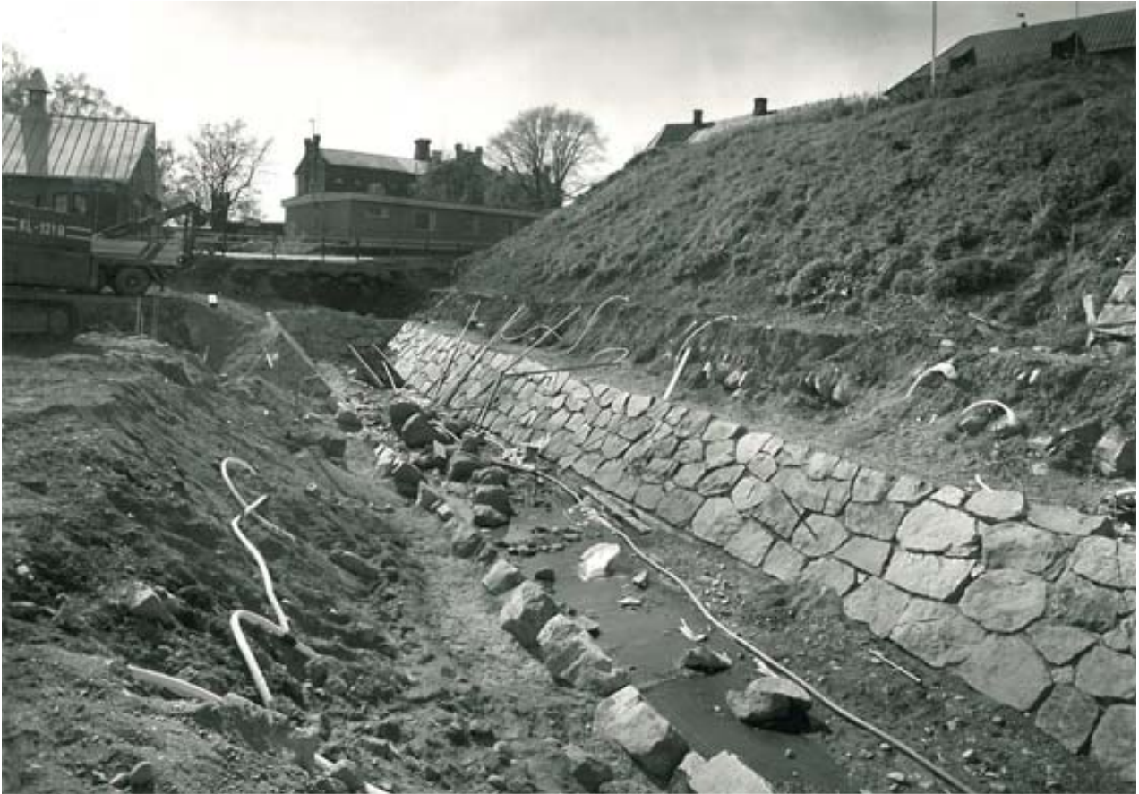
Kuva: Vuonna 1987 otetussa valokuvassa näkyy 5. puolibastionin uudelleen ladottua eskarppimuuria ja salaojaputkia, joita asennettiin muurikivien taakse. RHO 8981, Museoviraston arkisto, Hämeen linna.
