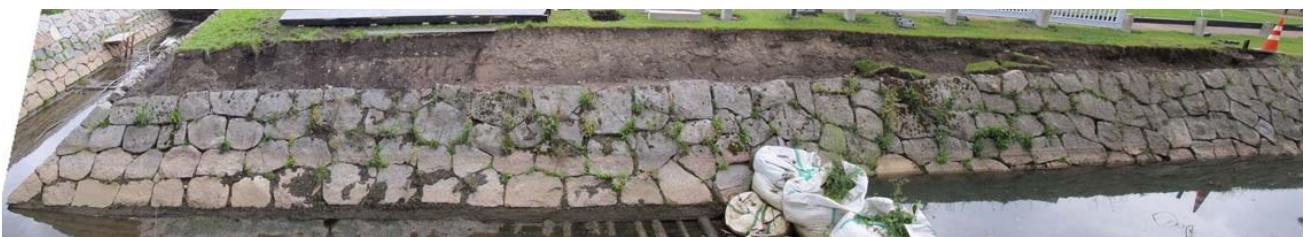
Kuva: 4. puolibastionin vasemman sivun kontreskarppimuurin taustalta on poistettu täyttömaata, jotta muurin korotukset voitiin tehdä. Päivi Hakanpää, Museovirasto. AKDG4222:95-97.
