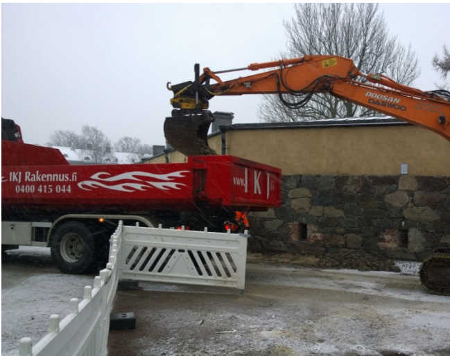
AKDG 4604:2. Kiveyksen poistoa rakennuksen C31 edustalta, etelään. Kuvaaja: Petro Pesonen.
