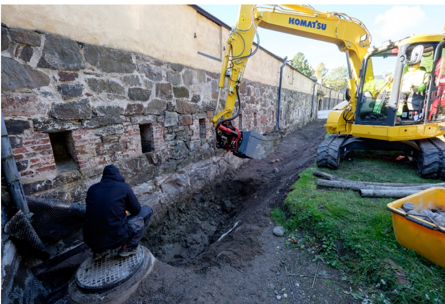
AKDG 4604:31. Täyttömaan poistoa läntisestä putkikaivannosta. Kuva idästä. Kuvaaja: Vesa Laulumaa.
