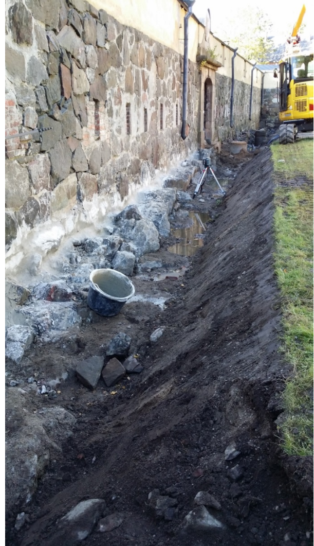
AKDG 4604:43. Valmista puhdistettua läntistä kaivantoa, seinää on tiivistetty betonilla, länteen. Kuvaaja: Johanna Seppä.
