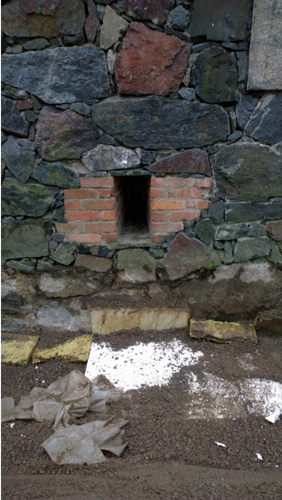
AKDG 4604:8. Kerrosjärjestys kiveyksen alla rakennuksen C31 seinustalla, lounaaseen. Kuvaaja: Petro Pesonen.
