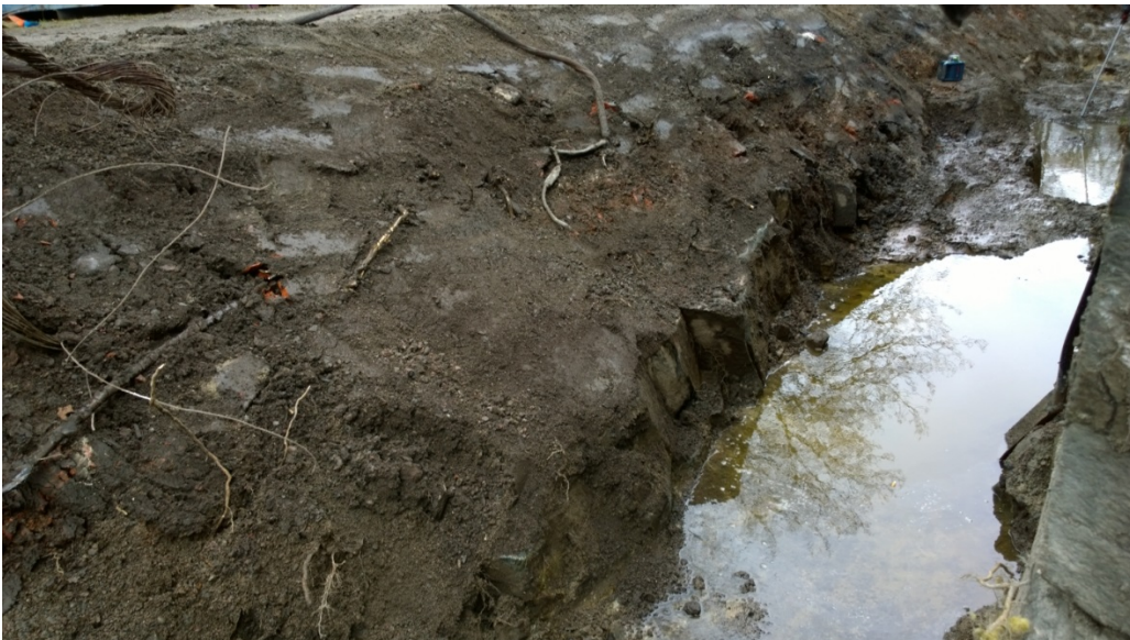
AKDG 4604:28. Itäisen ojan länsipäätä - vaikuttaa siltä, että kiviä/kalliota on lohkottu, itään. Kuvaaja: Petro Pesonen.
