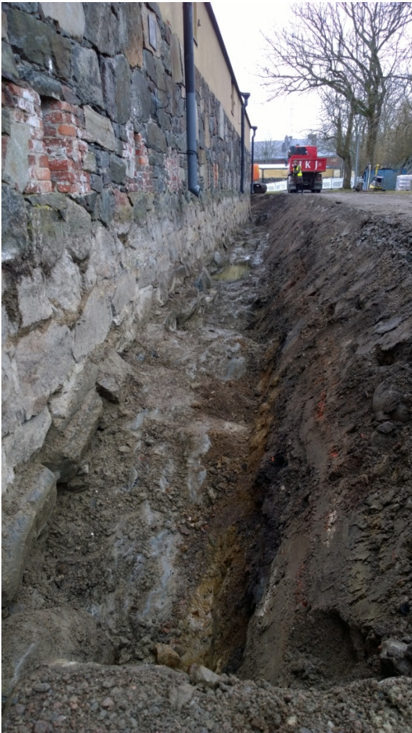
AKDG 4604:22. Itäinen kaivanto pohjaan kaivettuna, luiskassa syväälle ulottuva kulttuurikerros, länteen. Kuvaaja: Petro Pesonen.
