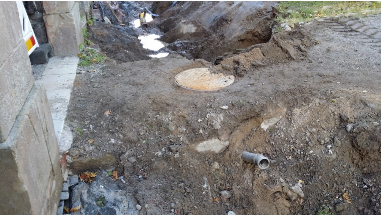
AKDG 4604:40. Kruununlinnan porttikäytävän edusta ennen kaivamista, länteen. Kuvaaja: Johanna Seppä.
