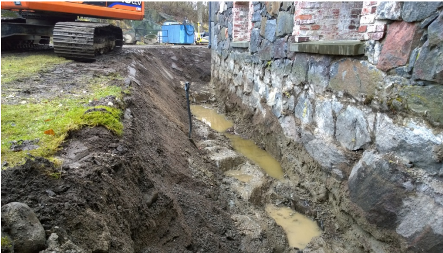
AKDG 4604:20. Itäisen kaivannon lyhyt seinämäosuus pohjaan kaivettuna, koilliseen. Kuvaaja: Petro Pesonen.
