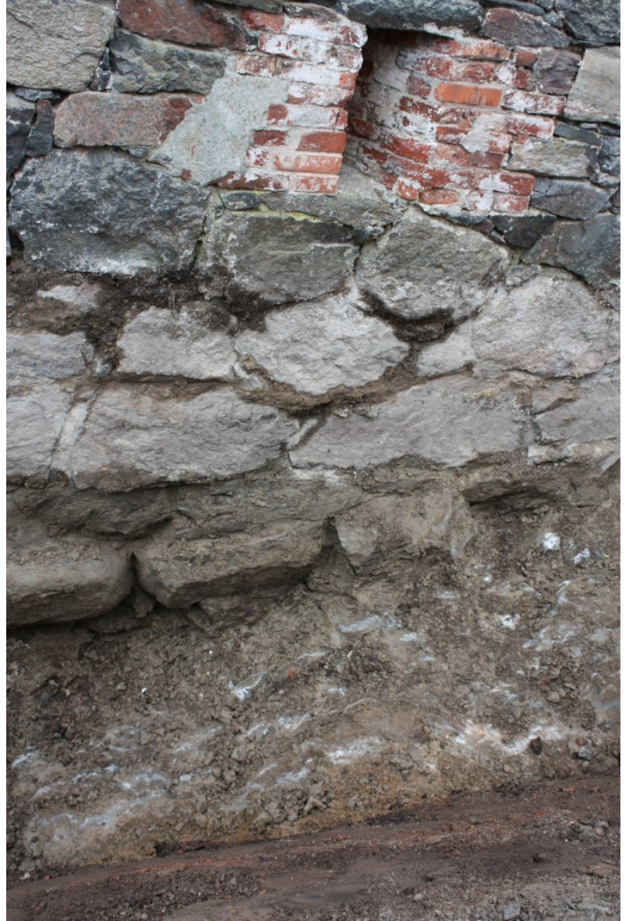
AKDG 4604:14. Rakennus C31 on perustettu kalliolle, kuva seinän perustuksista itäisen kaivannon kohdalla. Kuvaaja: Johanna Seppä.
