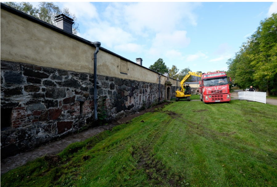
AKDG 4604:29. Pintakiveyksen poistoa seinän vierestä kaivinkoneella, läntinen kaivanto. Kuva idästä. Kuvaaja: Vesa Laulumaa.
