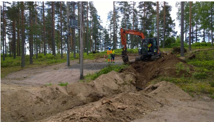
AKDG 4497:5. Kaivu etenee puistomuuntamon TP 1 kohdalle, kaakkoon. Kuvaaja: P. Pesonen.
