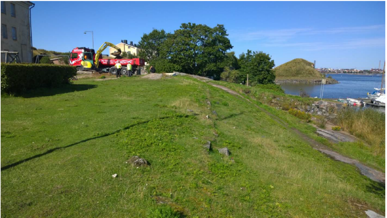
AKDG 4606:7. Kaivu käynnissä, etualalla muurin jäännöksiä, luoteeseen. Kuvaaja: Petro Pesonen.
