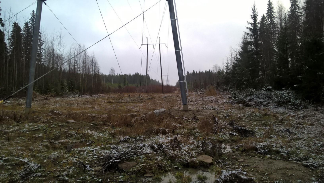
Kuva 2. Voimajohtolinjaa Jysinahontien länsipuolella Kiuruvedellä. Kuvattu lännessä. Voimajohtolinja kulkee pääosin soistuneessa maastossa. Etualan pylvään ympäristö oli voimakkaasti muokattua savimaata. Kivikautinen asuinpaikka Kiuruvesi Korkeakangas sijaitsee tästä noin 300 metriä pohjoiseen. Kuva Esa Mikkola, Arkeologiset kenttäpalvelut.
