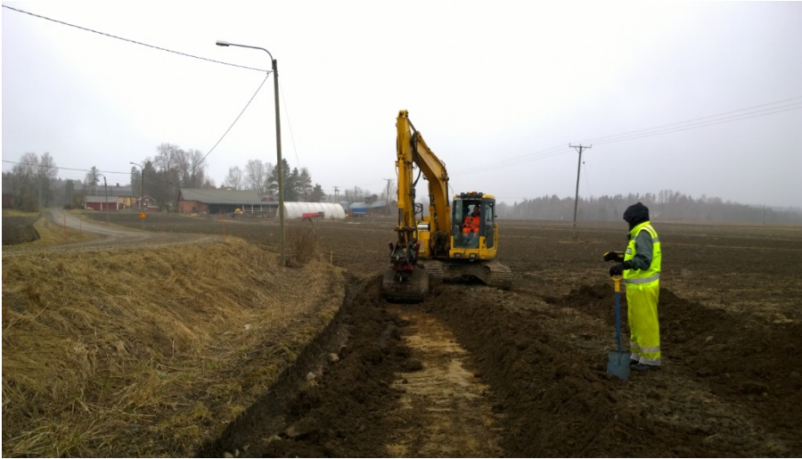
AKDG 4501:15. Unnaanmäentie. Peltokerrosta kuoritaan kaapelilinjalla, lounaaseen. Kuvaaja: P. Pesonen.
