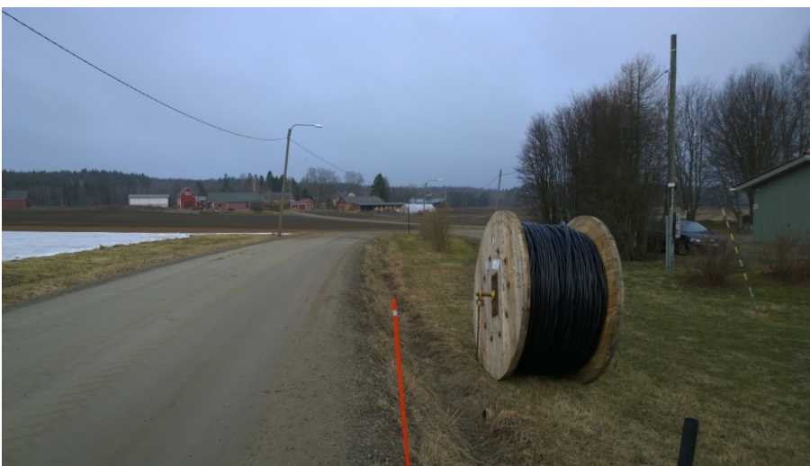
AKDG 4501:13. Unnaanmäentie. Kaapelikela odottaa asennusta Unnaanmäentien varrella, taustalla Ahtilan tila, lounaaseen. Kuvaaja: P. Pesonen.
