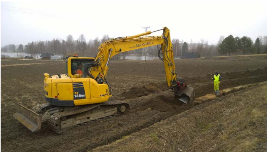
AKDG 4501:16. Unnaanmäentie. Peltokerrosta kuoritaan kaapelilinjalla, pohjoiseen. Taustalla Kylälönjoki. Kuvaaja: P. Pesonen.
