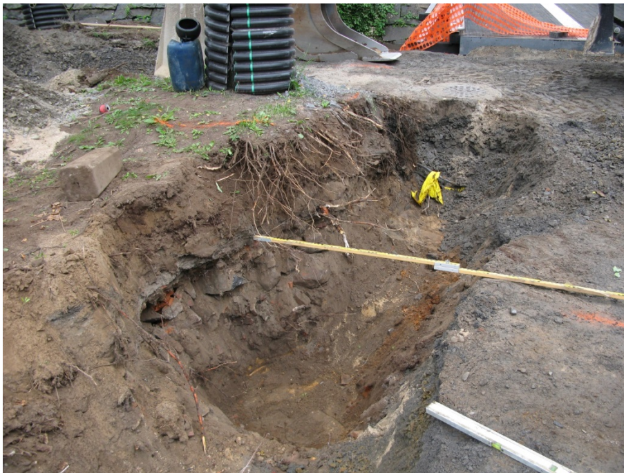
AKDG 4274_30. Kaivanto pylvään vieressä. Lounaaseen. Kuvaaja: Terhi Tanska.
