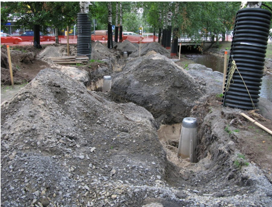
AKDG 4274_26. Yleiskuva - Kaupunginojan pohjoispuolella oleva kaivanto. Kaakkoon. Kuvaaja: Terhi Tanska.
