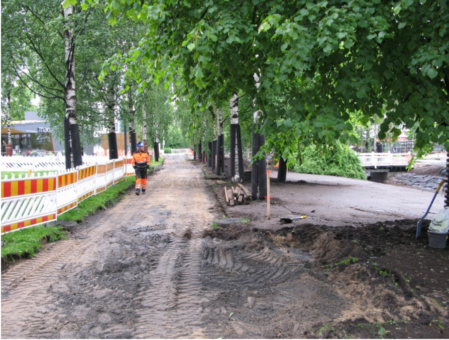
AKDG 4274_15. Yleiskuva, kaivun aloitus. Pohjoiseen. Kuvaaja: Terhi Tanska.
