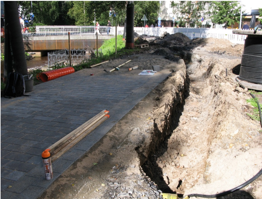
AKDG 4274_32. Kaapeli-kaivanto. Luoteeseen. Kuvaaja: Terhi Taipaleenmäki.
