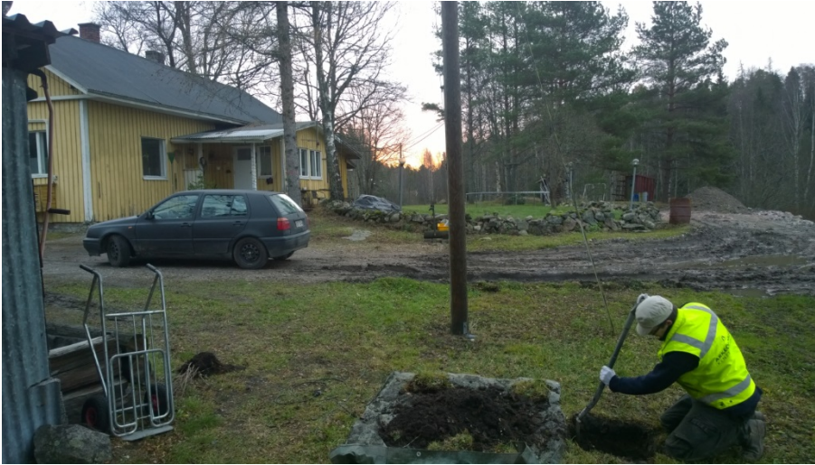
AKDG 4609:20. Koekuoppa 19 kaivetaan. Kuva pohjoisesta. Kuvaaja: Petro Pesonen.
