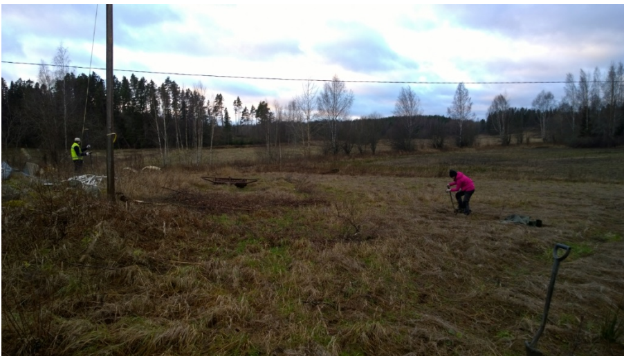
AKDG 4609:25. Koekuop- paa 24 kaivetaan pellolle. Kuva lännestä. Kuvaaja: Petro Pesonen.
