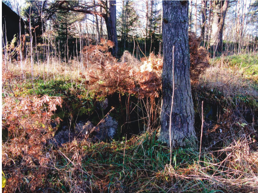
Perustuksen kylmämuurausta länteen.
