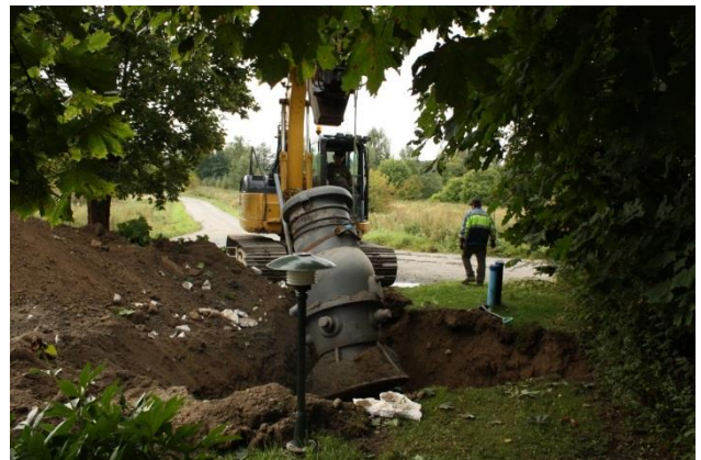
Kuva 11. Pumppaamon nosto, kuvattu koillisesta. AKDG 4666:12
