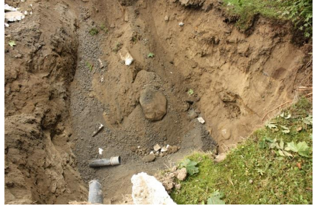
Kuva 15. Pumppaamon siirtoa varten kaivettu kaivanto, kuvattu koillisesta. AKDG 4666:13
