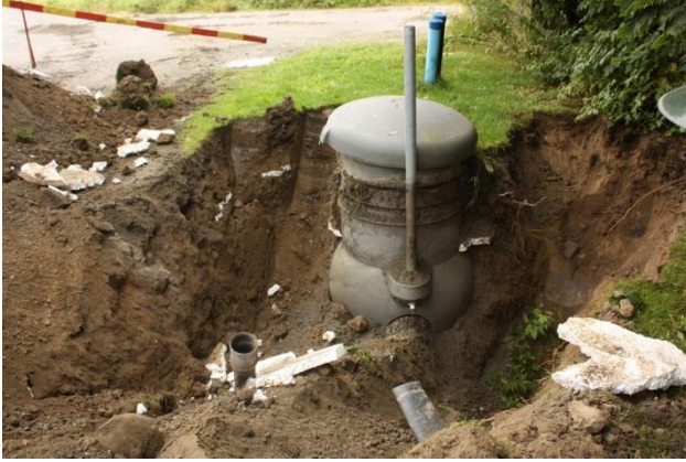
Kuva 14. Pumppaamo esille kaivettuna, kuvattu koillisesta. AKDG 4666:11
