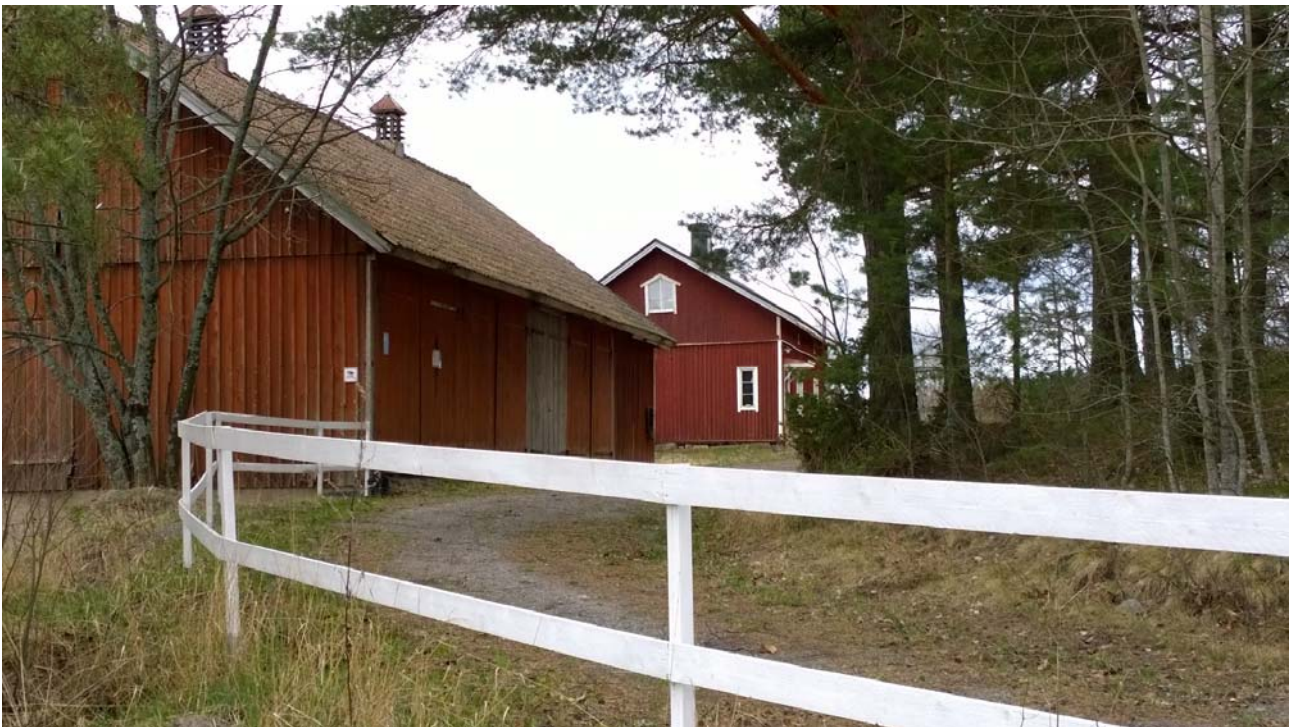
AKDG 4234:2. Vadjon rakennuksia, taustalla muonamiehen asuinrakennus, idästä. Kuvaaja: Petro Pesonen.
