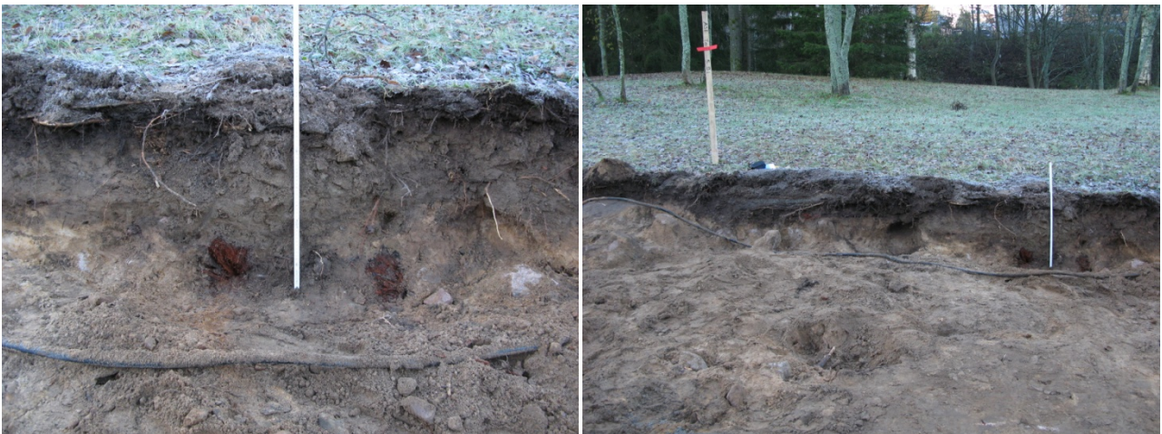
R12 kaivannon profiilissa. AKDG4493:29 ja 30.
