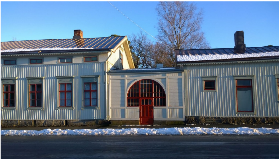
AKDG 4528_47. Yksityiskohta Kirkkokadun varren taloista, kiinteistö 89300202020045. Kuvaaja: P. Pesonen.
