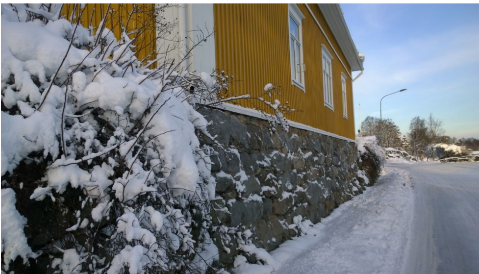
AKDG 4528_132. Jykevää kivijalkaa talon perustana, kiinteistö 89300606090030. Kuvaaja: P. Pesonen.
