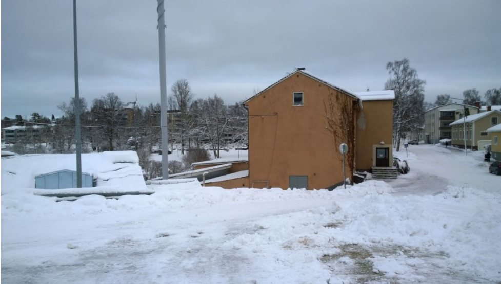
AKDG 4528_70. Voimalaitoksen rakennus, jossa on nykyään mm työväenopisto, kiinteistö 89300299030000. Kuvaaja: P. Pesonen.
