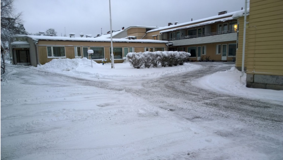
AKDG 4528_61. Kiinteistön sisäpihaa, kiinteistö 89300202030063. Kuvaaja: P. Pesonen.
