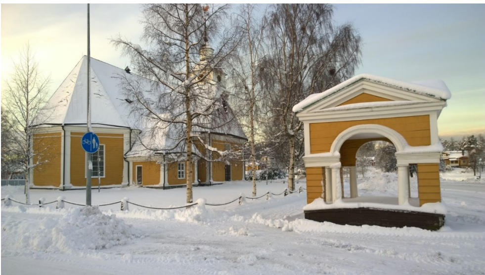
AKDG 4528_15. Kirkon koillispuolella oleva vanha porttirakennus, kiinteistö 89300101020001. Kuvaaja: P. Pesonen.
