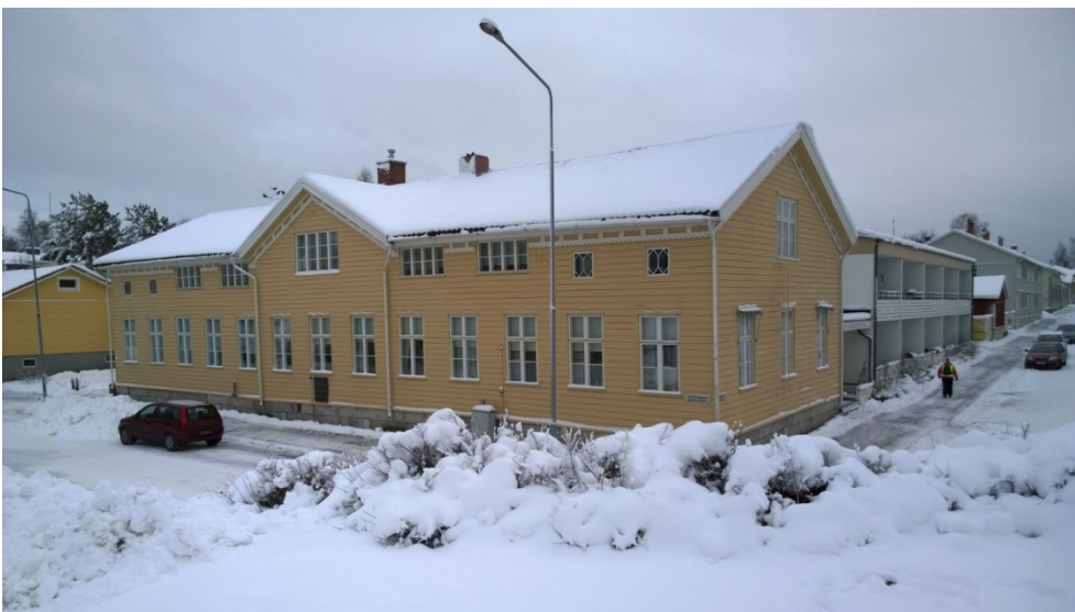
AKDG 4528_60. Lybeckin talon kiinteistö, kiinteistö 89300202030063. Kuvaaja: P. Pesonen.
