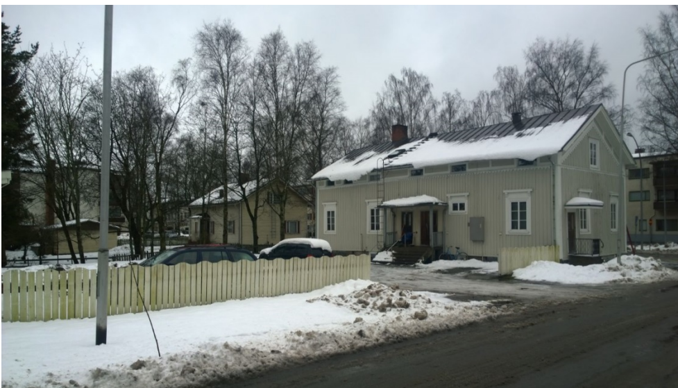
AKDG 4528_90. Vanha asuinrakennus, kiinteistö 89300404130066. Kuvaaja: P. Pesonen.
