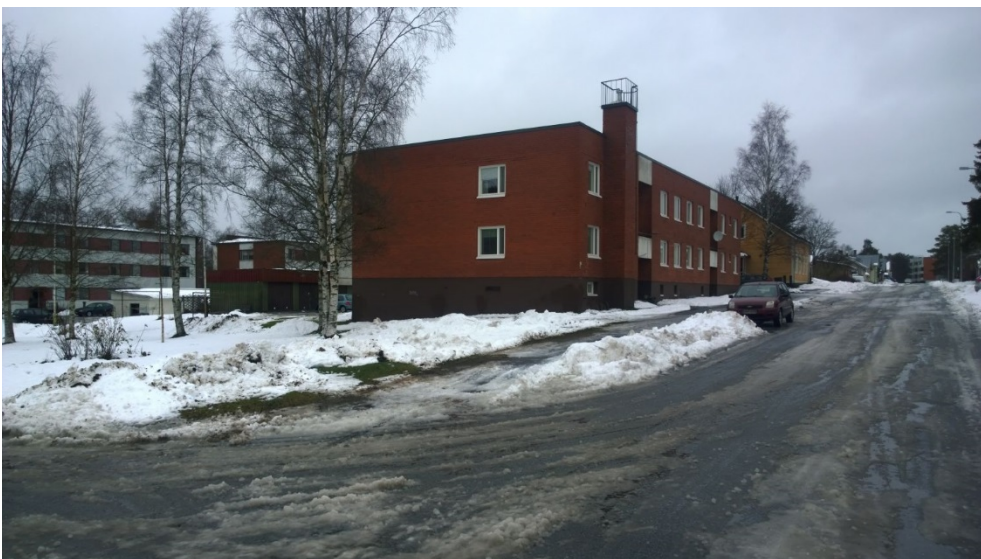
AKDG 4528_105. Matala tiilikerrostalo, kiinteistö 89300505010078. Kuvaaja: P. Pesonen.
