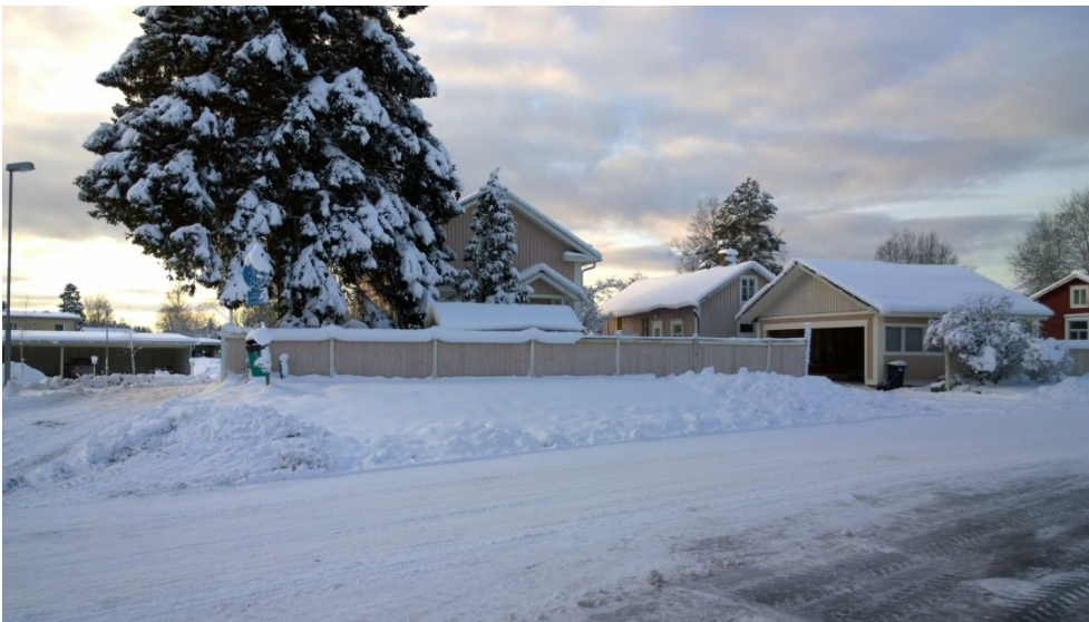
AKDG 4528_146. Uusi asuinrakennus osoitteessa Ratakatu 5, kiinteistö 89301111020006. Kuvaaja: P. Pesonen.
