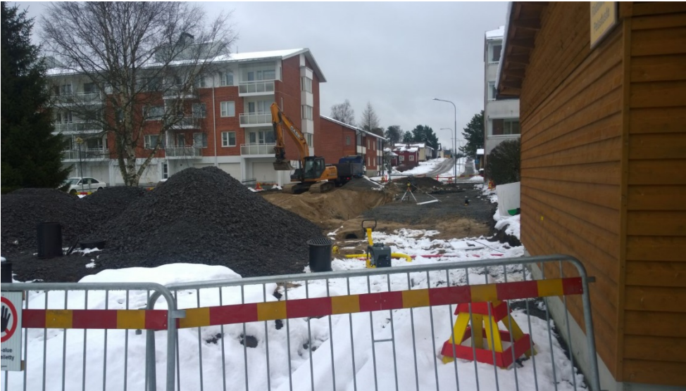
AKDG 4528:155. Katutyö käynnissä Porvarinkatu 6 kohdal- la. Kuvaaja: P. Pesonen.
