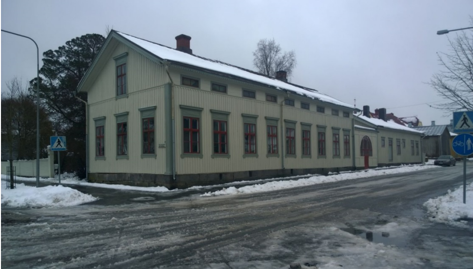
AKDG 4528_46. Peräkkäiset asuinrakennukset Kirkkokadun varrella, kiinteistö 89300202020045. Kuvaaja: P. Pesonen.
