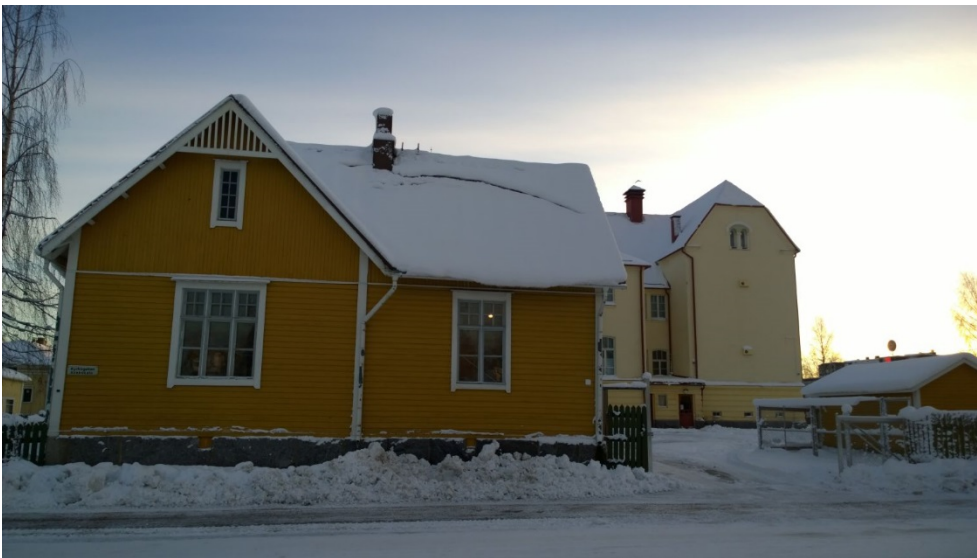
AKDG 4528_20. Koulutalon kanssa samalla tontilla oleva vanha asuinrakennus, kiinteistö 89300101030001. Kuvaaja: P. Pesonen.
