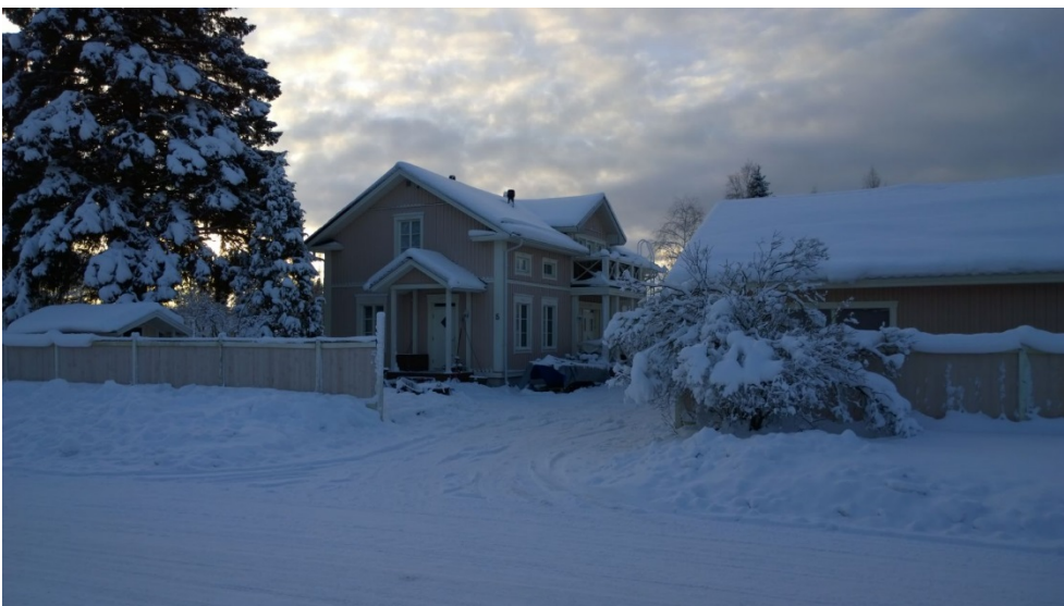
AKDG 4528_147. Uusi asuinrakennus osoitteessa Ratakatu 5, kiinteistö 89301111020006. Kuvaaja: P. Pesonen.
