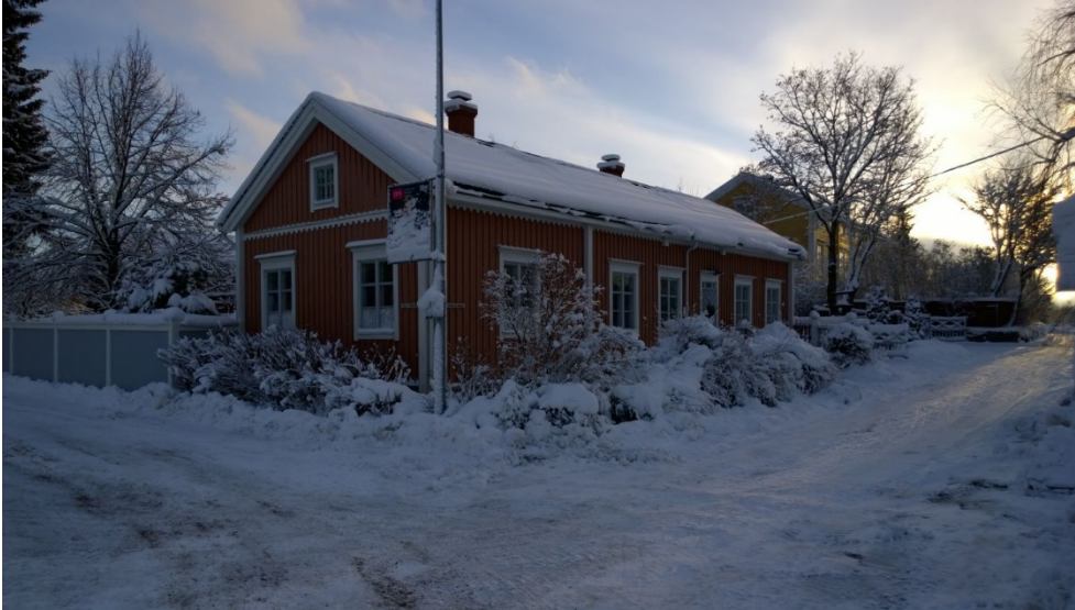
AKDG 4528_10. Vanhan tullitalon tontti, kiinteistö 89300101010002. Kuvaaja: P. Pesonen.
