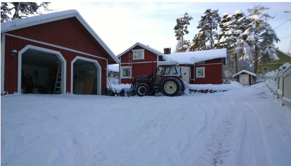
AKDG 4528_138. Etualalla autotalli, taempana asuinrakennus, kiinteistö 89300606130004. Kuvaaja: P. Pesonen.
