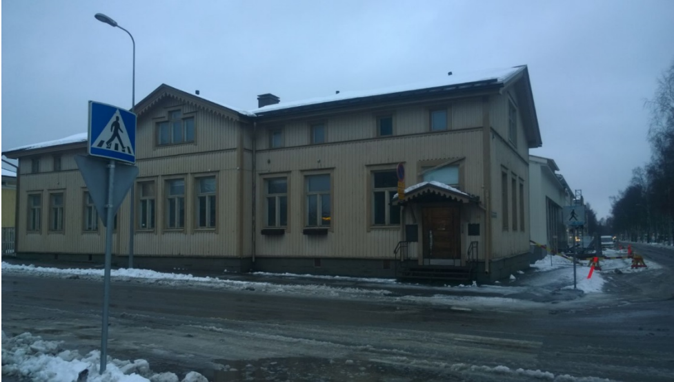
AKDG 4528_37. Kiinteistöllä oleva vanha asuinrakennus, kiinteistö 89300202020040. Kuvaaja: P. Pesonen.
