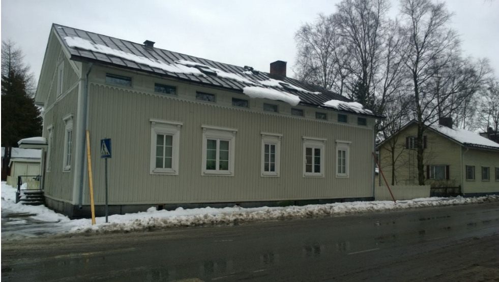
AKDG 4528_91. Vanha asuinrakennus, kiinteistö 89300404130066. Kuvaaja: P. Pesonen.
