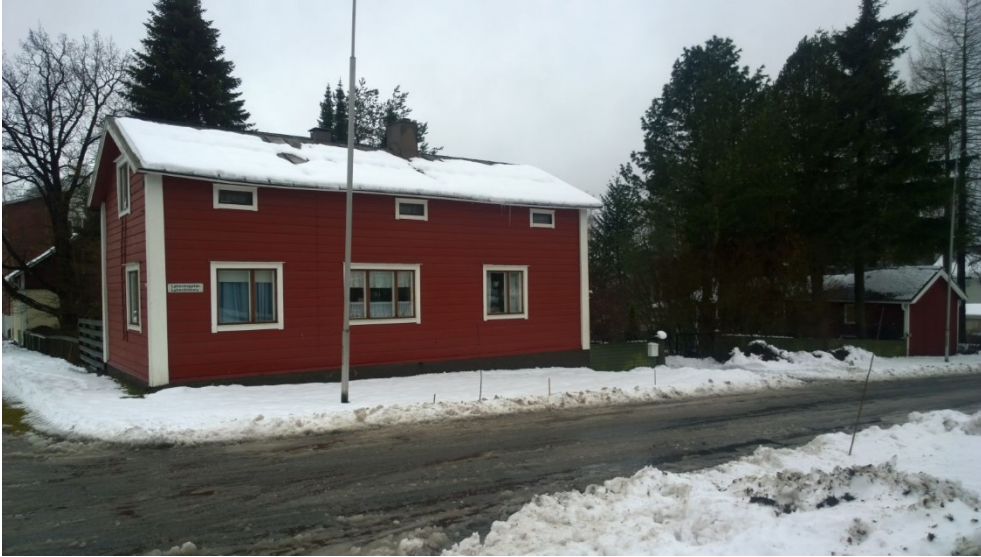
AKDG 4528_94. Toinen tontin omakotitaloista, kiinteistö 89300404130067. Kuvaaja: P. Pesonen.
