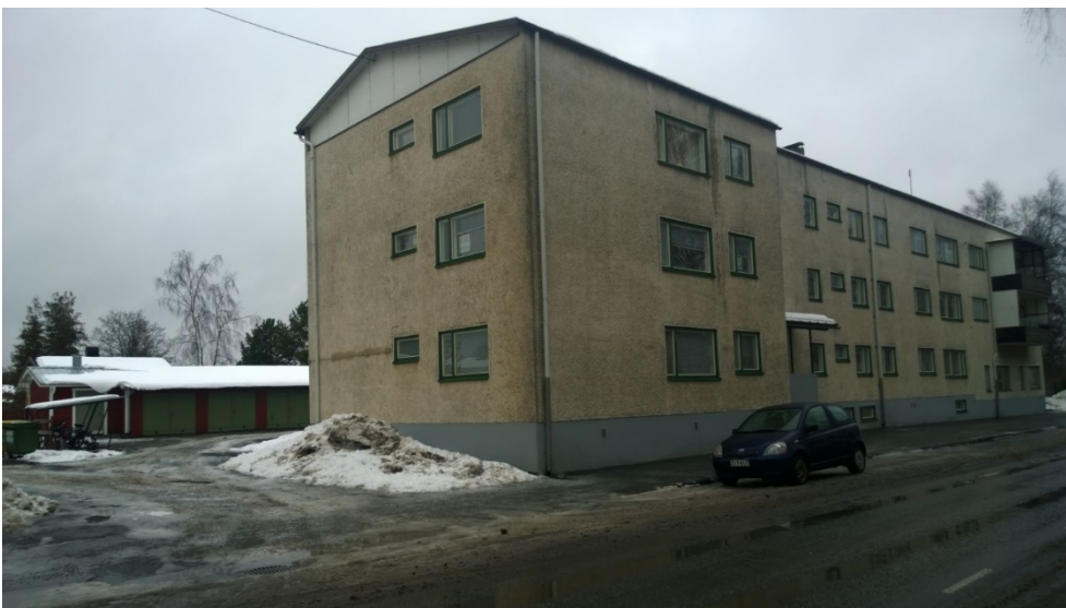
AKDG 4528_66. Rapattu kerrostalo, kiinteistö 89300202030065. Kuvaaja: P. Pesonen.
