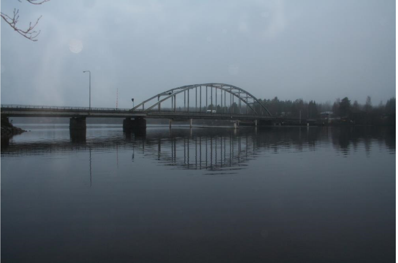
Kuva 009. Jännevirran silta kuvattuna lossilaiturilta.
