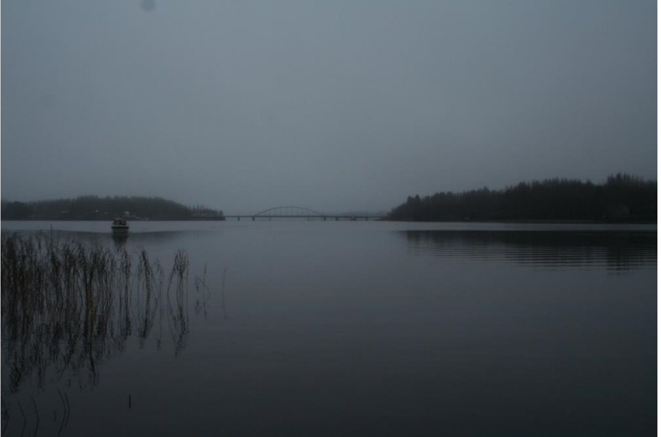
Kuva 017. Näkymä Jänneniemestä Jännevirran sillan suuntaan.
