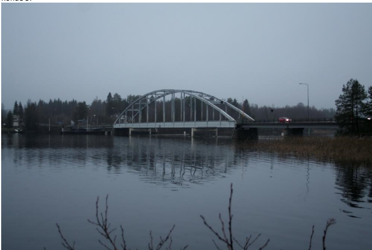
Kuva 002. Jännevirran vuonna 1951 valmistunut silta.
