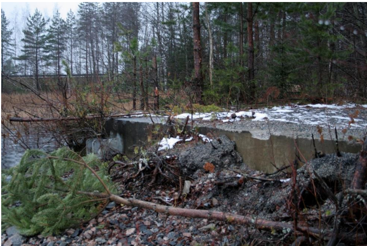
Kuva 001. Sillan korjauksen (1980-l.) aikaisen pioneerilaiturin itäpää lossarin ja siltavahdin talojen rannassa. Kohde 5.
