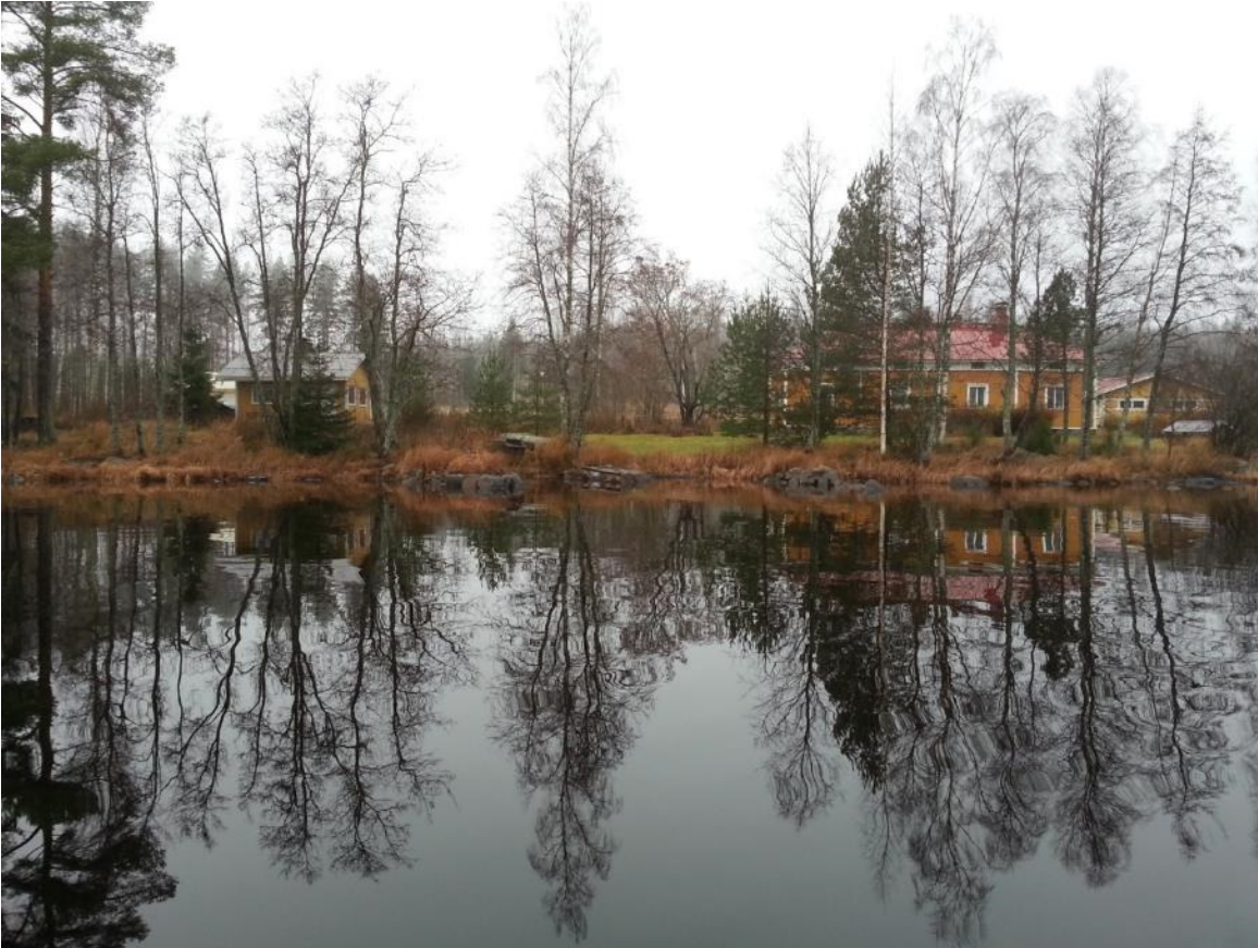
Kuva 032. Kolmen pienen kivilaiturin perustukset Koivurannan talon kohdalla, Jännevirran sillasta etelään Rissalan puolella. Kohde 6.
