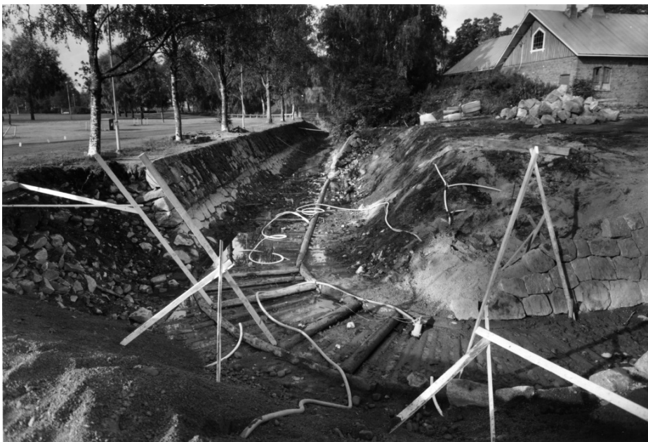
Kuva: Vuonna 1987 otetussa valokuvassa näkyy puolibastionin kärjen eskarppimuurin alla olevat hirret liitoskohtiin. RHO 8980, Museoviraston arkisto, Hämeen linna.
