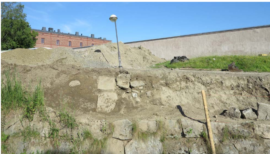
Kuva: 1. puolibastionin oikean sivun kontreskarpimuuria korotettaessa paljastui maaleikkauksesta kivirakenne, joka todennäköisesti oli osa puretun raveliinin säilynyttä kivimuuria. AKDG4680:22 Päivi Hakanpää, Museovirasto.
