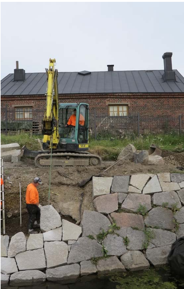
Kuva: Uusia kiviä asennetaan paikoilleen. AKDG4680:3 Päivi Hakanpää, Museovirasto.
