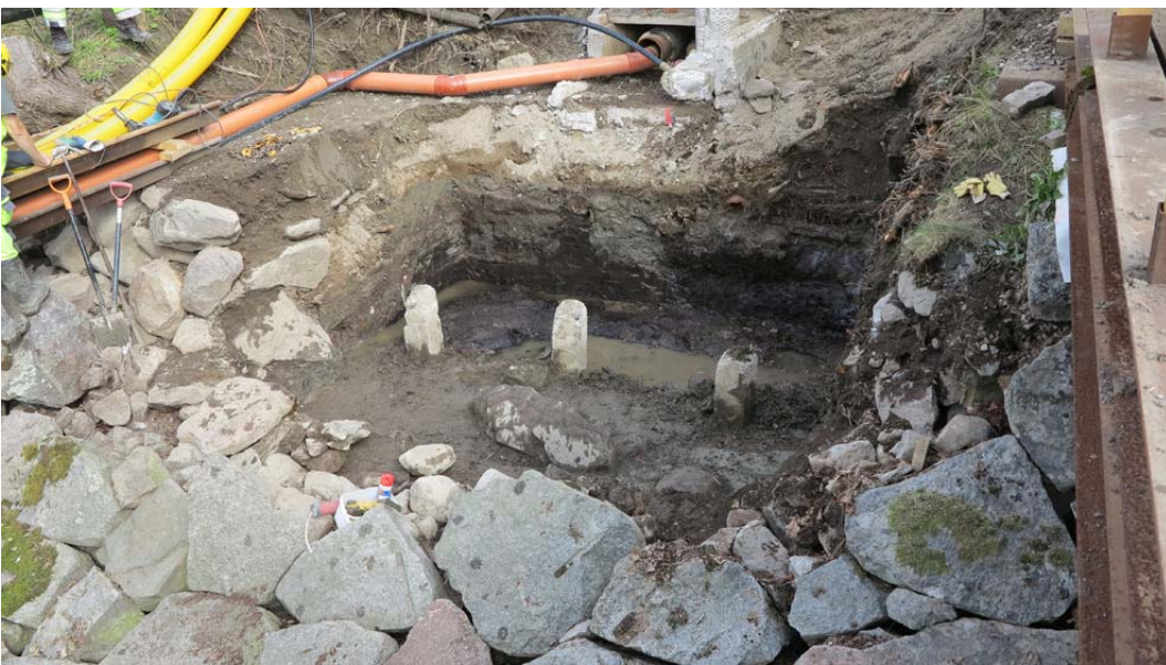
Kuva: Eskarppimuurin saveen ladotun kivirakenteen pohjaa sekä turvekerrosta. Betonipaalut liittyvät vanhan tekniikkasillan purettuun perustukseen. AKDG4680:79 Päivi Hakanpää, Museovirasto.
