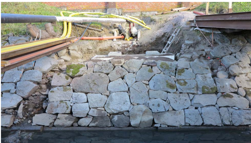
Kuva: Eskarppimuurin uudelleen ladonta on lähes valmis. AKDG4680:90 Päivi Hakanpää, Museovirasto.
