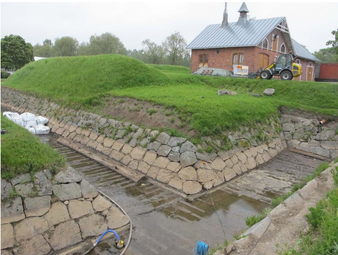
Kuva: 4. puolibastionin eskarpimuuri ja 5. puolibastionin länsiosan kontreskarpimuuri ennen muurin korotustöitä keväällä 2014. Vedestä tyhjennetyn vallihaudan puuperustukset ja puretun sillan rakenteet ovat näkyvissä. AKDG4680:43 Päivi Hakanpää, Museovirasto.
