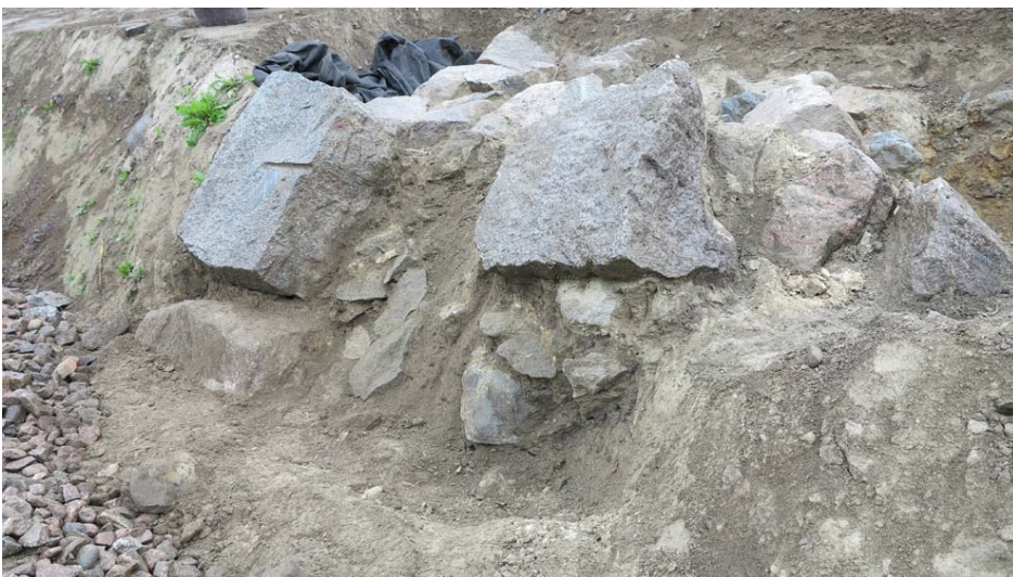
Kuva: Kivirakenteen päädyn kuorikivien saumat kaivettiin auki, jotta kivet voidaan kiinnittää laastilla. AKDG4680:31 Päivi Hakanpää, Museovirasto.
