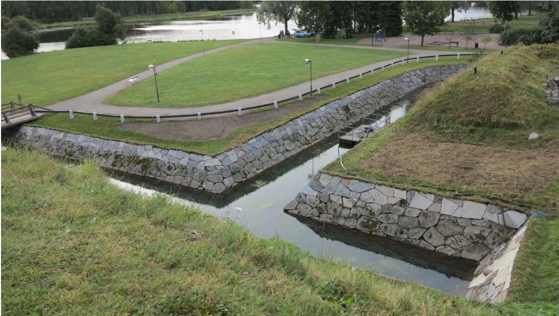
Kuva: Kivirakenne peitettiin muuten, mutta sen ylin kivi jätettiin näkyviin. Korotettujen muurien päälliset on peitetty nurmikuntalla ja tasanne niittojätteellä AKDG4680:42 Päivi Hakanpää, Museovirasto.
