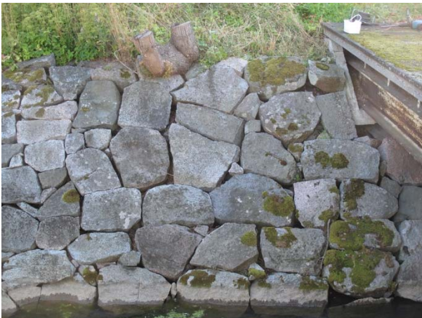
Kuva: Eskarppimuuri ennen kuorikivien poistoa. Kuorikivien taakse oli ladottu kivikerros ja tekniikkasillan rakentamisen yhteydessä taustalle oli valunut soraa. AKDG4680:73 ja :74 Janne Hymylä, Museovirasto.
