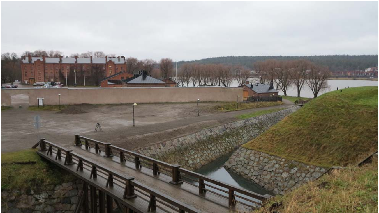
Kuva: Muurin korotustyöt valmistuivat marraskuun alussa. AKDG4680:6 Päivi Hakanpää, Museovirasto.
