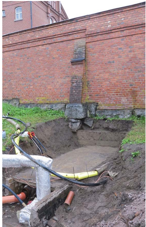
Kuva: Vankilan tiilimuurin perustuksia 3. puolibastionin oikean sivun kohdalla. Tiilimuuri on rakennettu puolibastionin maavallin päälle. AKDG4680:116 Päivi Hakanpää, Museovirasto.
