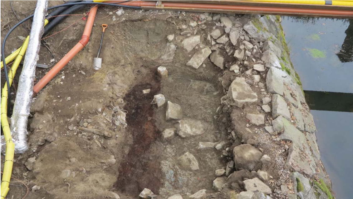
Kuva: Kontreskarppimuurin saveen ladotun kivirakenteen pohja sekä rakenteen takaa paljastunut turvekerros. AKDG4680:64 Janne Hymylä, Museovirasto
