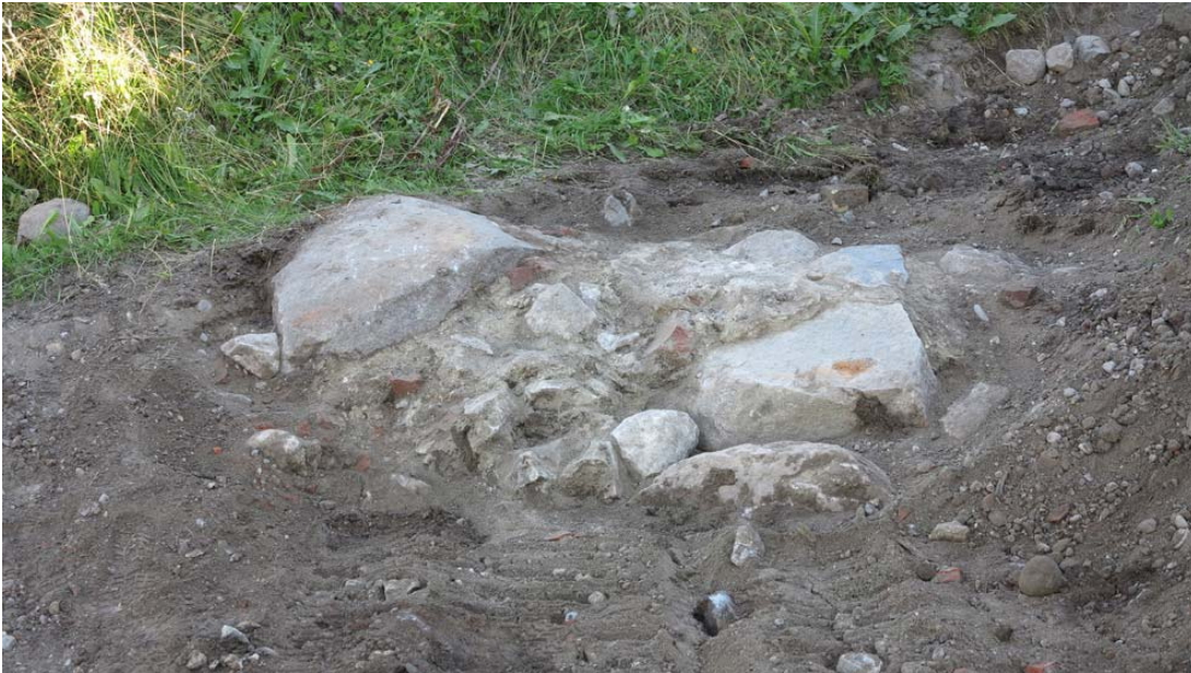
Kuva: 4. puolibastionin ennallistetun maavallin vierestä paljastui muurattu kivirakenne. AKDG4680:38 Päivi Hakanpää, Museovirasto.
