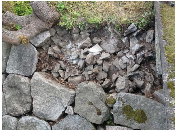
Kuva: Eskarppimuuri ennen kuorikivien poistoa. Kuorikivien taakse oli ladottu kivikerros ja tekniikkasillan rakentamisen yhteydessä taustalle oli valunut soraa. AKDG4680:73 ja :74 Janne Hymylä, Museovirasto.
