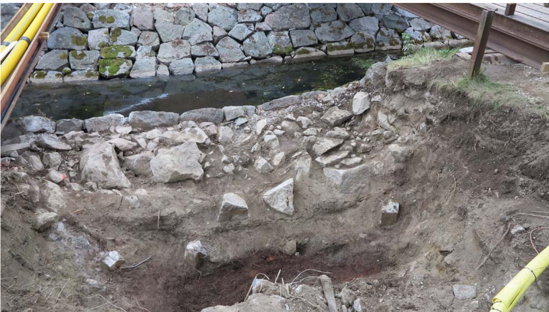
Kuva: Kontreskarppimuurin saveen ladottu kivirakenne esiin kaivettuna. AKDG4680:63 Päivi Hakanpää, Museovirasto.
