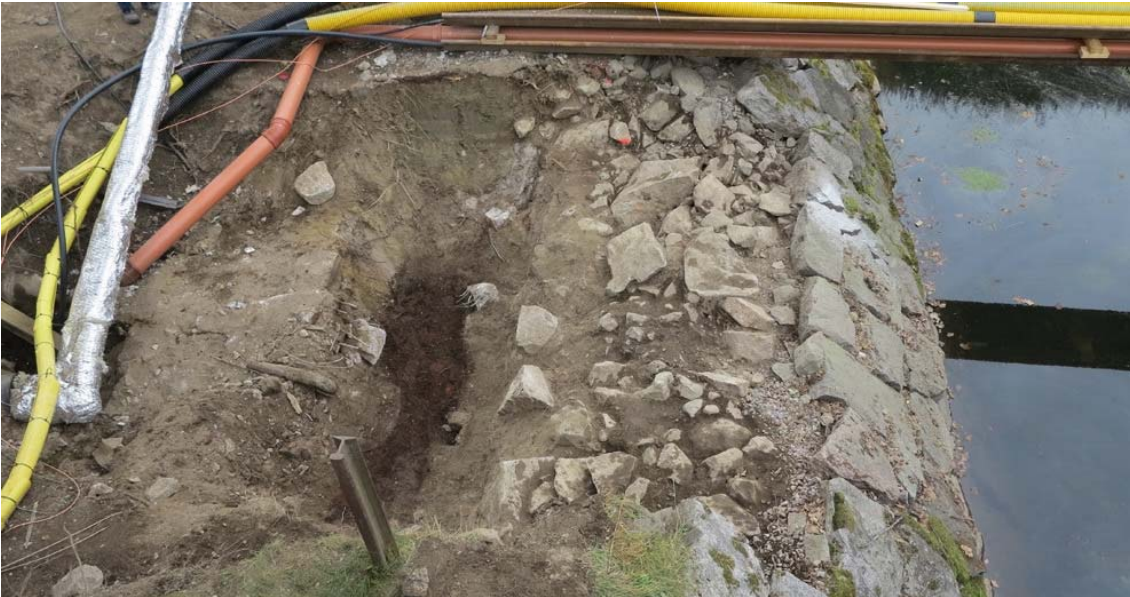
Kuva: Kontreskarppimuurin saveen ladottu kivirakenne esiin kaivettuna. AKDG4680:62 Janne Hymlä, Museovirasto.
