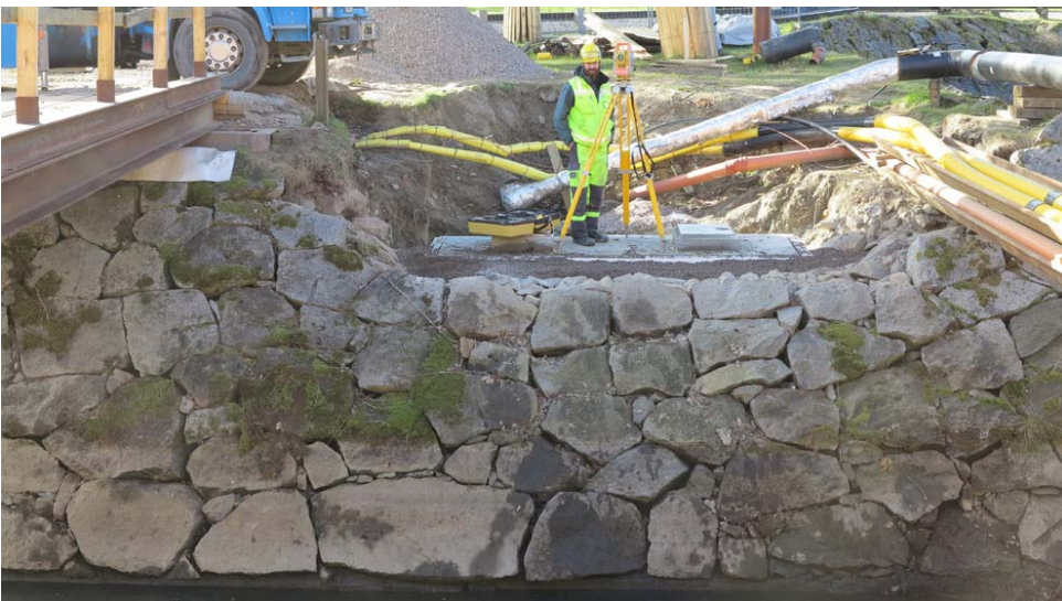
Kuva: Kontreskarppimuurin tausta on ennallistettu ja uuden sillan perustukset valettu. Kuvassa Janne Hymylä. AKDG4680:72 Päivi Hakanpää, Museovirasto.
