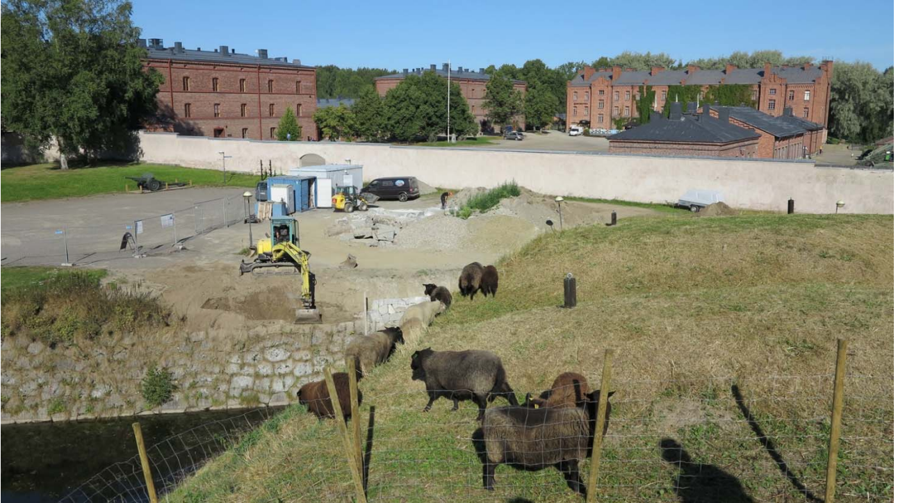
Kuva: Kontreskarpimuurin tausta kaivettiin esiin kaivinkoneella korotustöitä varten. 1. puolibastionin vallien kasvillisuuden hoitamiseksi kokeiltiin laidunnusta. AKDG4680:4 Päivi Hakanpää, Museovirasto.
