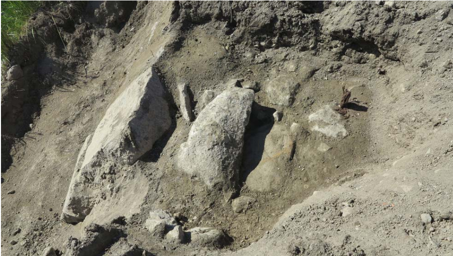
Kuvat: Kuorikivien takaa paljastui valumuurirakenne ja puupaalu. AKDG4680:24 Päivi Hakanpää, Museovirasto.
