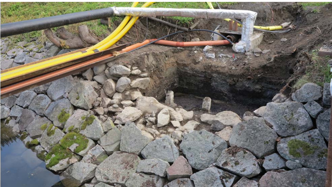
Kuva: Eskarppimuurin kuorikivien ja kivikerroksen takana oli saveen ladottu kivirakenne. AKDG4680:77 Päivi Hakanpää, Museovirasto.
