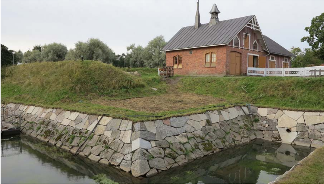
Kuva: 4. ja 5. puolibastionien länsiosan korotettujen muurien vesieristykset on peitetty nurmikuntalla ja niiden välinen madallettu tasanne niittojäteteellä. AKDG4680:52 Päivi Hakanpää, Museovirasto.
