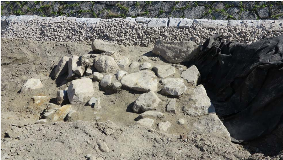
Kuva: Kivirakenne osittain esiin kaivettuna. Todennäköisesti rakenne oli purkamiselta säästynyttä raveliin oikean siiven kontreskarpimuuria. AKDG4680:28 Päivi Hakanpää, Museovirasto.
