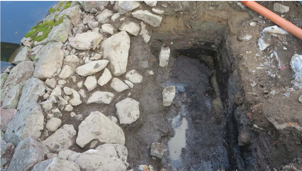
Kuva: Eskarppimuurin kuorikivien ja kivikerroksen takana oli saveen ladottu kivirakenne. AKDG4680:76 Päivi Hakanpää, Museovirasto.
