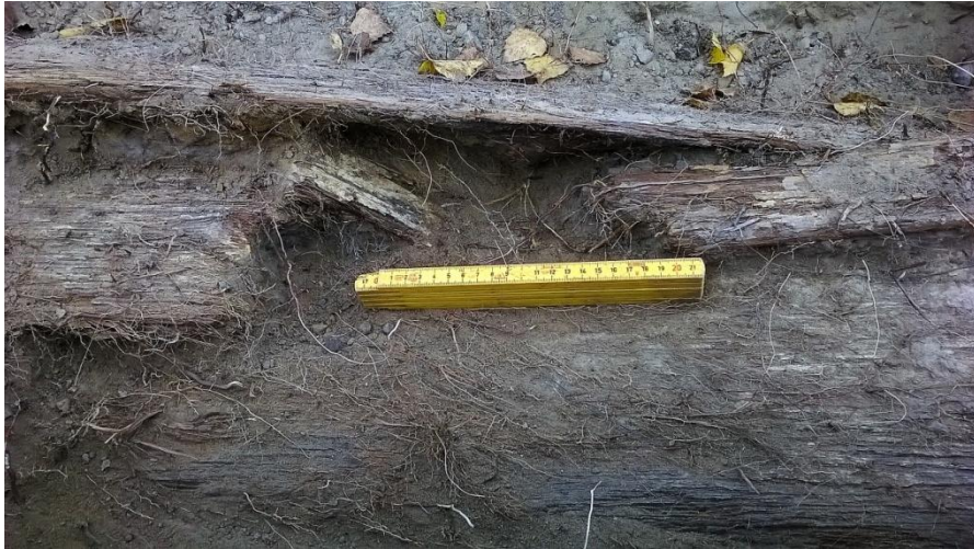
Kuva 16. Rakenneosia BB-puolella. Kappaleiden pinnoilla näkyy vaaleaa kalkkijauhetta. Kuva: Subreering.
