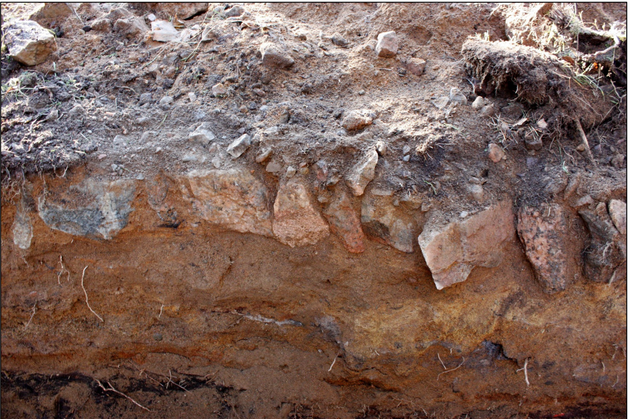
Kuva 9 Kuva 10. Yksityiskohta tien pinnan rakenteesta koeojan profiilissa. Kuvattu koillisesta. Kuva: John Lagerstedt. Museovirasto, 2015. AKDG4597:2.
