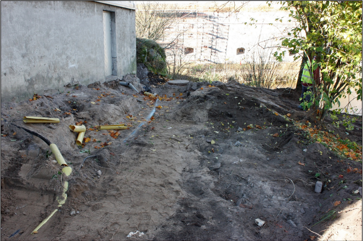
Kuva 5. Työmaan kaivu on valmistunut. Kuvattu kaakosta. AKDG4599:3.
