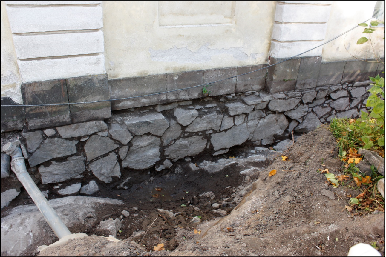
Kuva 9. Tenalji von Fersenin kivijalkaa rakennuksen B17b itäosassa. Kuvattu lounaasta. AKDG4598:9.
