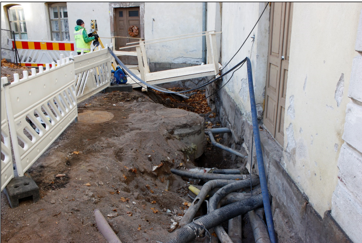
Kuva 3. Johanna Seppä kartoittaa työmaakaivannon keskiosaa takymetrillä. AKDG4598:7.
