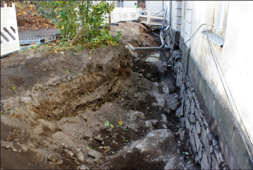
Kuva 5. Pihan itäosan kaivutyöt ovat valmistuneet. Vasemman puoleisessa profiilissa näkyy kenttäkiveystä. Kuvattu kaakosta. AKDG4598:8.
