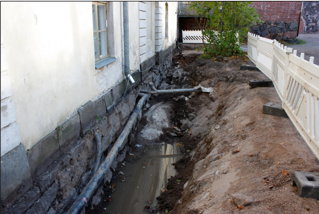
Kuva 8 Pihan itäosan työmaakaivanto. Kuvattu luoteesta. AKDG4598:10.
