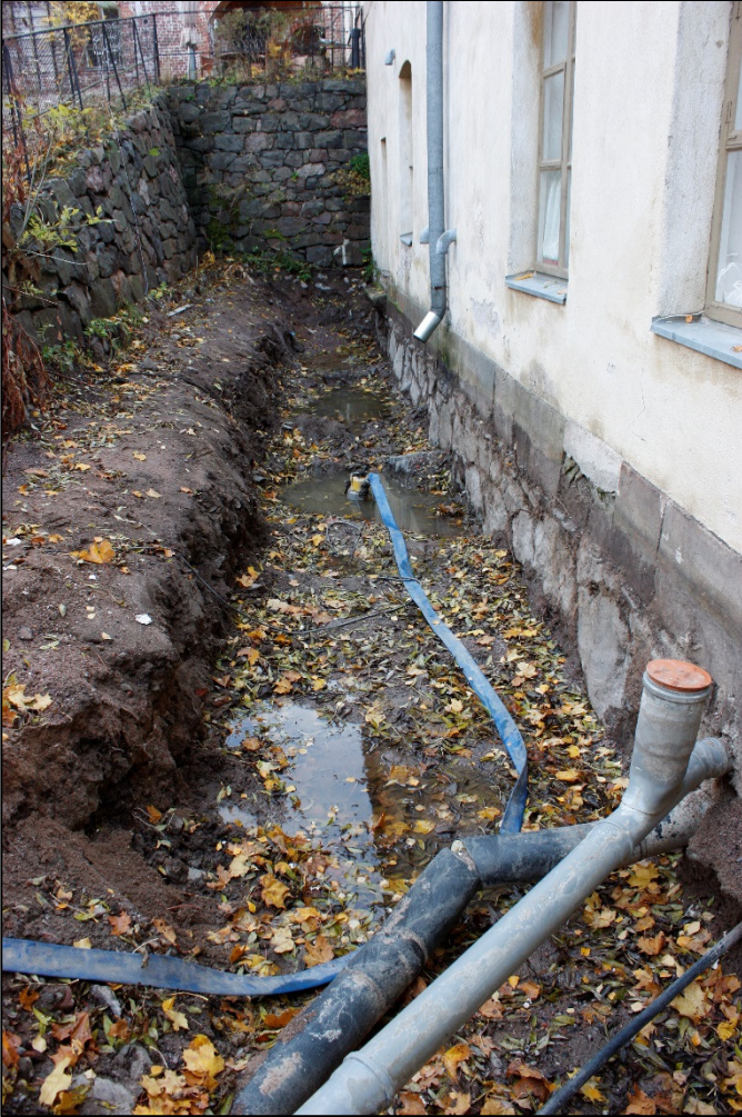
Kuva 7. Pihan länsiosan kaivutyöt ovat valmistuneet. Kuvattu koillisesta. AKDG4598:6.
