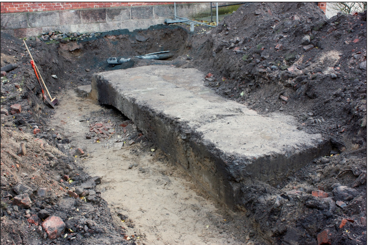
Kuva 9. Saunan D 26 pannuhuoneen perusta. Kuvattu pohjoisesta. AKDG4600:1.
