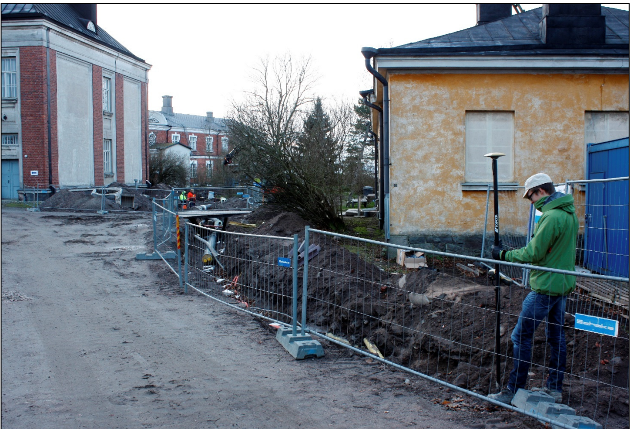
Kuva 4. Niko Anttiroiko kartoittaa työmaakaivantoa VRS-GPS-paikantimella. AKDG 4600:11.
