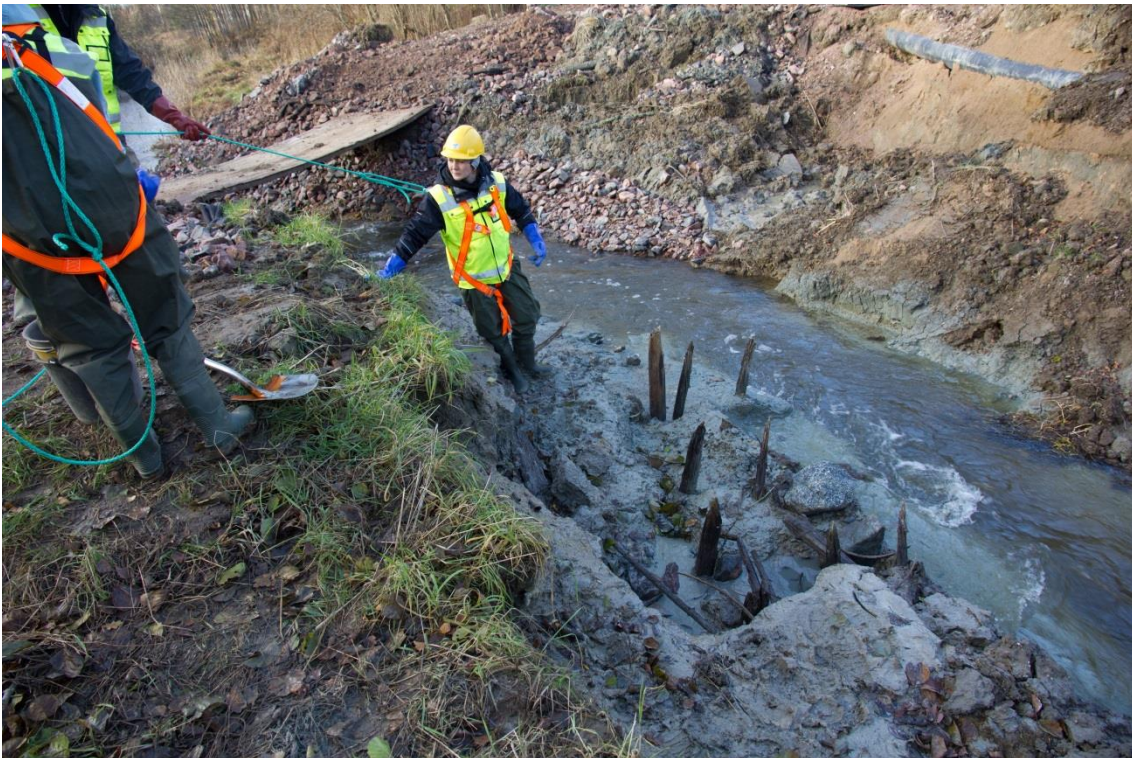
Kuva 3. ”Koekuoppa A” avattiin jo näkyvissä olleiden paalujen ympärille (AKDG4524: 10).
