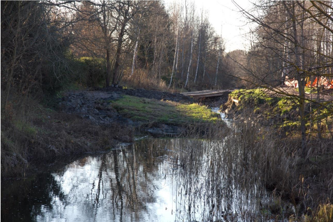
Kuva 2. Espoonjokeen romahtanut maa-aines on selkeästi erotettavissa etualan kaislikon ja taka-alan kulkusillan rajaamalla alueella (AKDG4524: 1).
