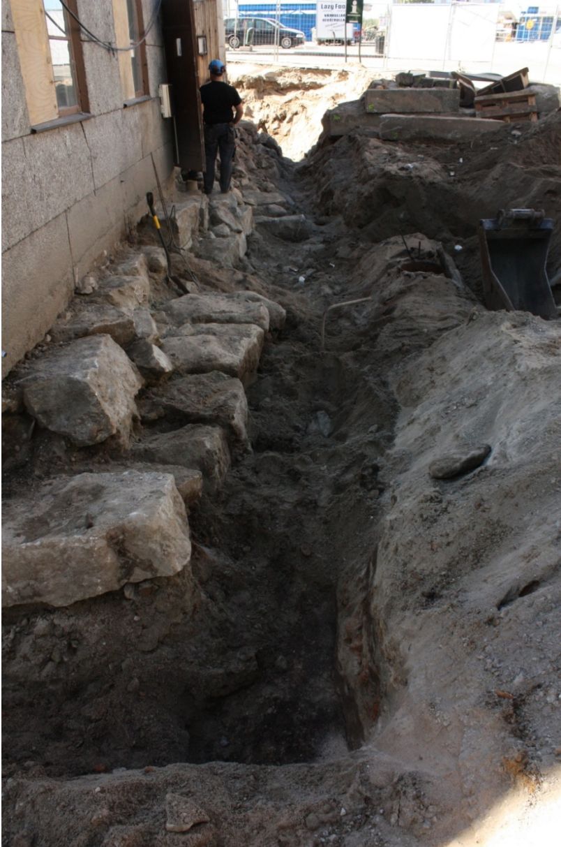
AKDG 4617:62. Yleiskuva, kaivutyön lopetus, pohjoisseinän kaivanto. Kuvattu länteen. Kuvaaja: Terhi Tanska.
