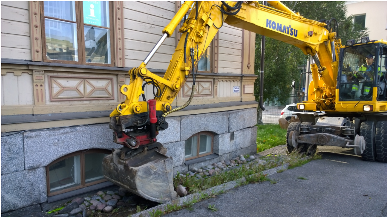
AKDG 4617:2. Kaivutyötä aloitetaan länsiseinällä mukulakivien poistolla. Kuvattu kaakkoon. Kuvaaja: Petro Pesonen.
