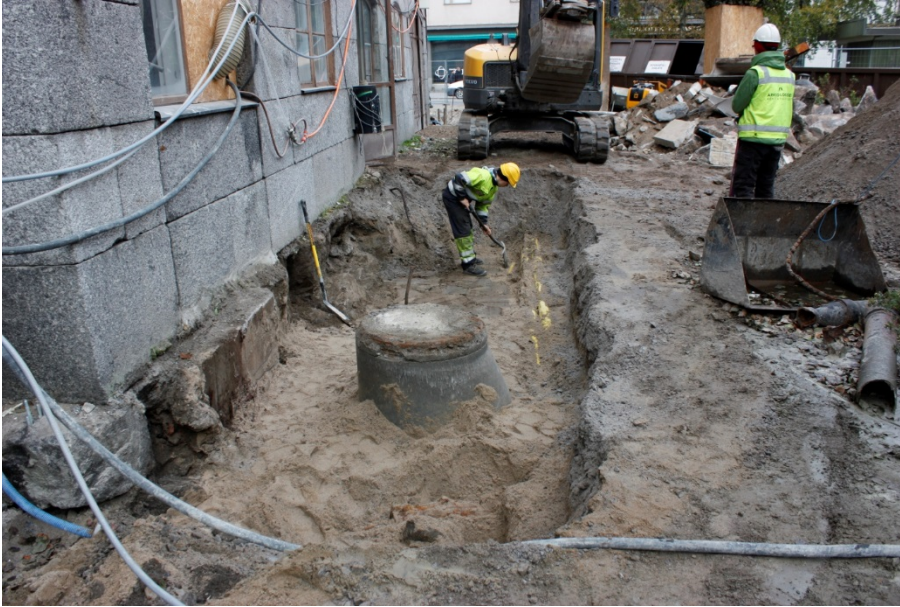
AKDG 4617:67. Itäseinustan kaivannon eteläpuolisko työn alla. Kuvattu pohjoiseen. Kuvaja: Johanna Seppä.
