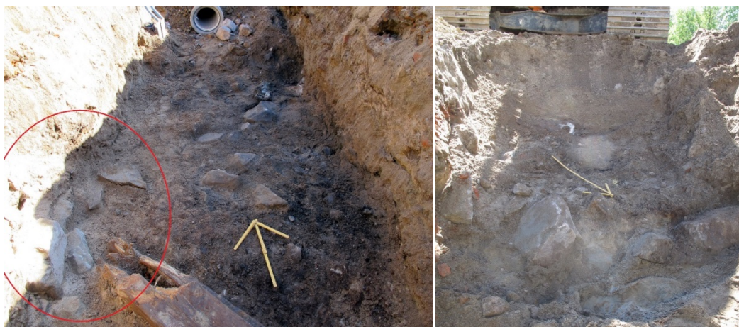
Vasemmalla: Punaisella ympyrällä merkitty kivirivi kaivannon 3 profiilissa R28 viemärikotelon päässä. Kivet näkyvät myös liitekartassa 6. AKDG 4723:122. Oikealla: Kaivannossa 3 pohjamaassa SY16 havaittu epämääräinen kivirivi. Noin 2,5 - 3 m rakenteesta R28 etelään. AKDG 4723:130.
