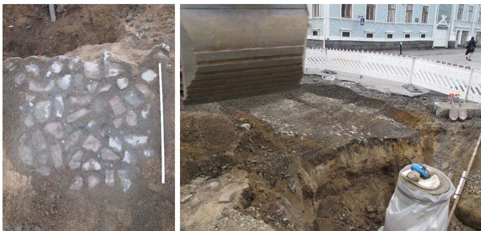
R8 tasossa kuvattuna kaivantojen 1 ja 2 välisellä alueella Hallituskadun rannan puoleisessa osassa, sekä Hallituskadun ja Rantakadun risteyksessä, jossa kuvassa näkyvän tason alla kulki L23 viemärikaivanto. AKDG4273:41 ja 62.
