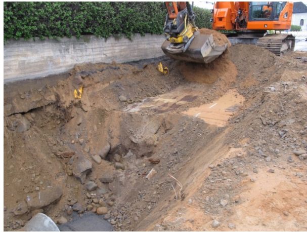
Kiviä rivissä kaivannon profiilissa kerroksen SY 14 sisässä, kerroksen SY9 alla, kaivanto L10 erottuu kuvassa kaivettavan kaivannon lounaisreunassa. AKDG4273:30
