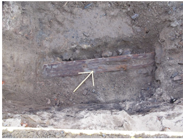
R41 puukoteloviemäri ja sen kaivanto L42 liikenteenohjauspylvään kaivannossa. AKDG 4273:234.
