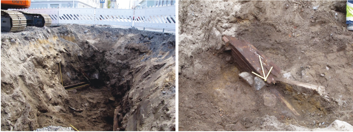
Vasemmalla: R21 ja R20 kaivannossa 1. Rakenteiden välissä kaivannon eteläkulmaan kulki L23 viemäriputki- ja kaivanto. Oikealla: Edellisessä kuvassa kaivannon päätyprofiliin jatkunut rakenteen R21 "jatke" esillä tasossa. Rakenteen on kaakkoispäästä L23:n kaivun aikana katkaistu (viisto pää) luoteispään pystyyn noussut puosa näkyy myös aiemmassa kuvassa. AKDG4273:72 ja 78
