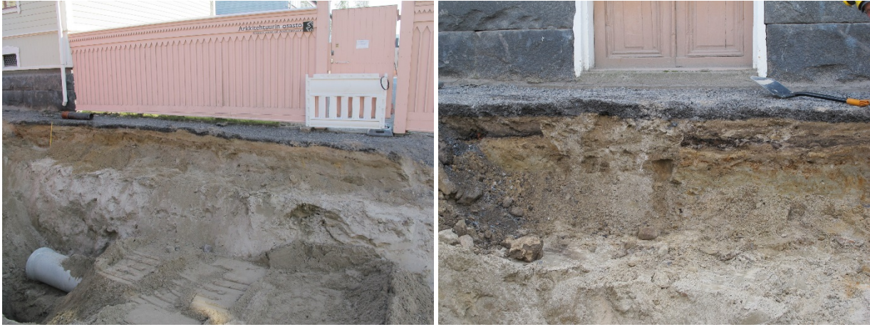
Eteläprofiili, katuosuuden itäosa. Oikeanpuoleisessa kuvassa erottuu kulttuurikerroksia leikkaava – Arkkitehtiosaston tontin Hallituskadun ja Aleksanterinkadun risteyksessä olevaan rakennukseen vedetyn – vesi- ja viemäriputken kaivanto heti SY4:n alla. AKDG 4273: 332 ja 335.
