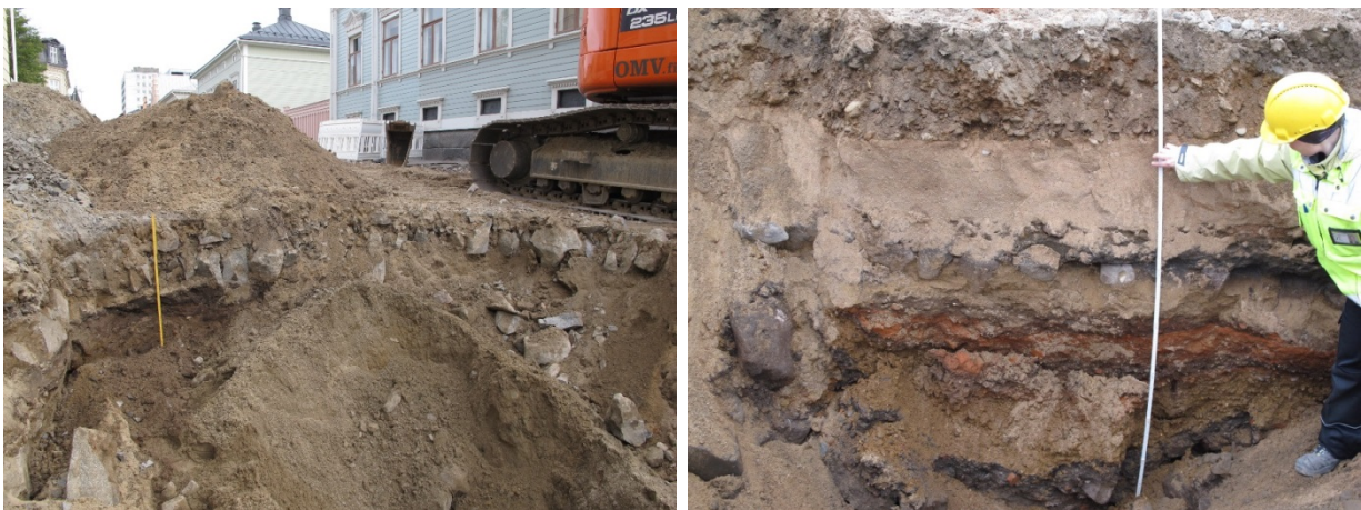
Vasemmalla: Epäsäännöllisistä lohkotuista kivistä tehty R8 kiveys Hallituskadulla välillä Rantakatu-Aleksanterinkatu. AKDG4273:280. Oikealla: R8 kiveys Hallituskadun rannanpuoleisessa päässä kaivannon 1 lounaisprofiilissa. Rakenteen päällä SY4, alla tiilensekainen SY14. AKDG4273:26
