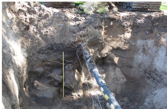
R47 kaivannon koilliskulmassa. Molemmin puolin kulkevat modernit kaivannot. AKDG 4273:290.
